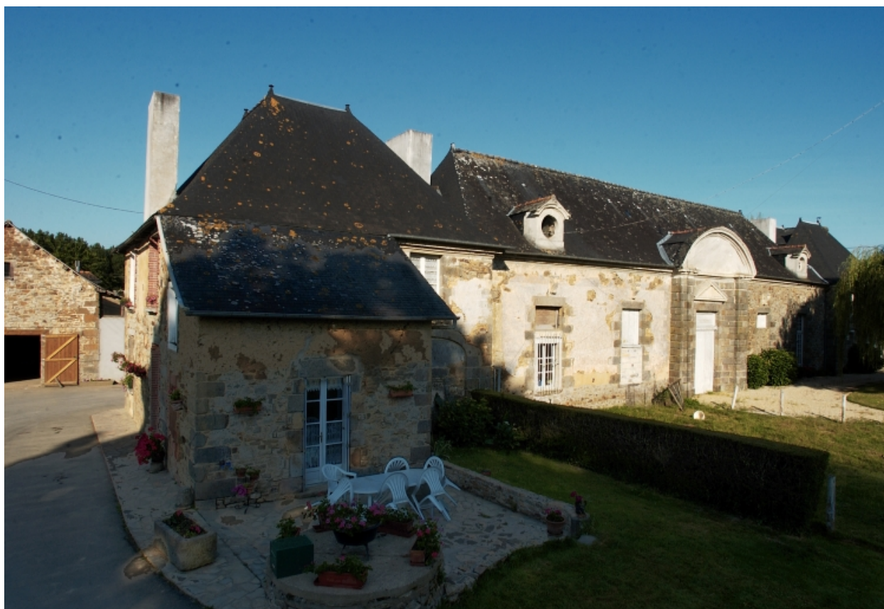
Vue sud-est des remises
