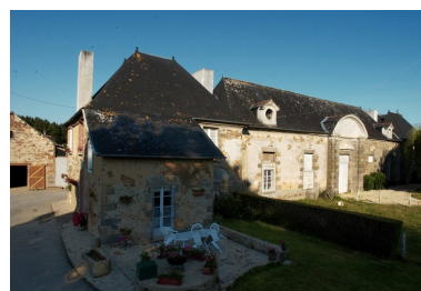
Vue sud-est des remises Phot. Norbert Lambart IVR53_20053502047NUCA
