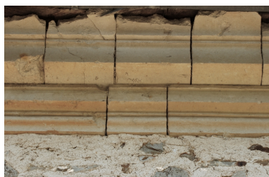
Corniche en pierre calcaire : tuffeau Phot. Norbert Lambart IVR53_20053502030NUCA
