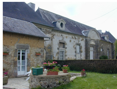
Vue sud-est de la remise
