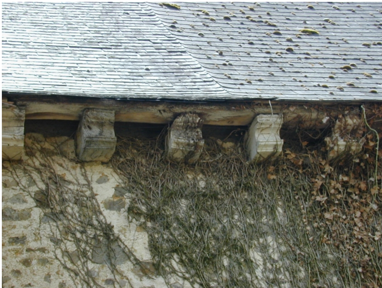
Détail des corbelets de l'écurie : façade postérieure
