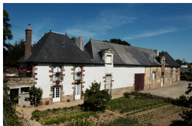
Façade postérieure des remises Phot. Norbert Lambart IVR53_20053502027NUCA
