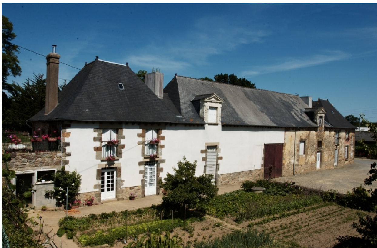
Façade postérieure des remises
