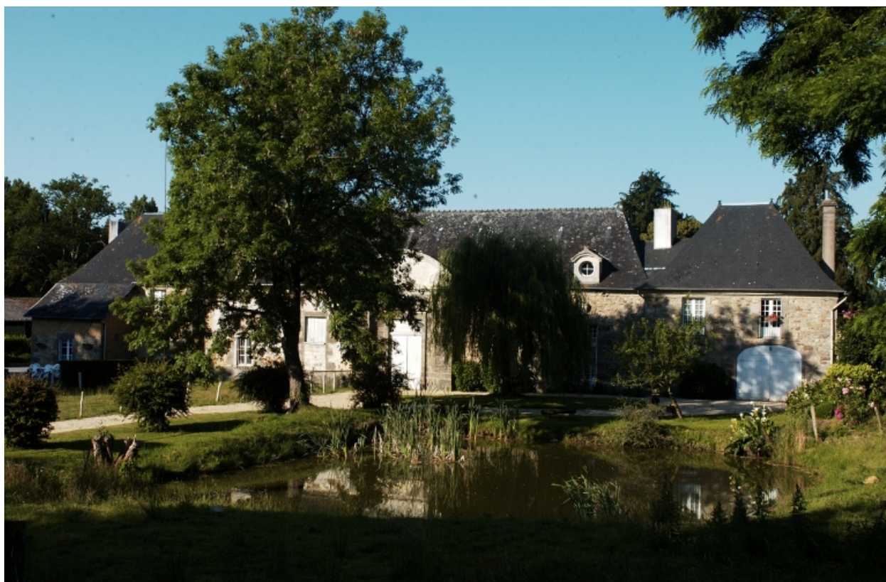
Vue de la façade principale de la remise
