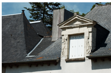
Lucarne en façade principale
