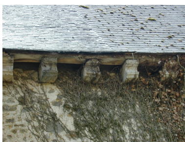
Détail des corbelets de l'écurie : façade postérieure Phot. Vanessa Hue IVR53_20053516208NUCA
