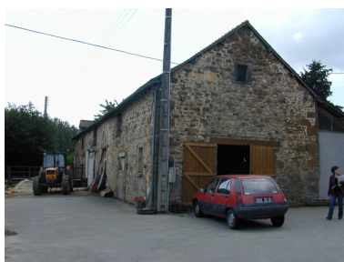
Vue sud-est de l'orangerie Phot. Vanessa Hue IVR53_20053516212NUCA
