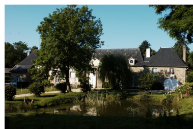
Vue de la façade principale de la remise Phot. Norbert Lambart IVR53_20053502052NUCA
