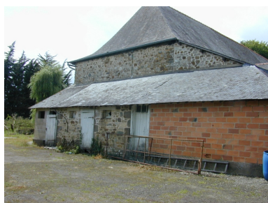
Vue des soues en appentis latéral Phot. Vanessa Hue IVR53_20053516204NUCA
