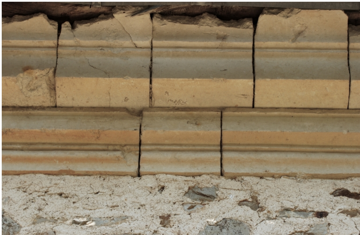
Corniche en pierre calcaire : tuffeau
