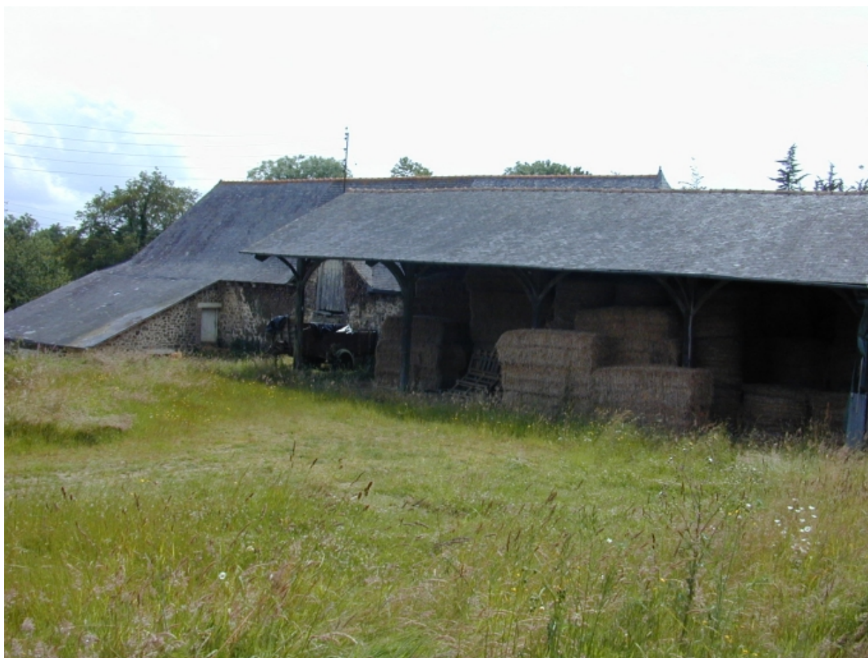
Vue de la plate-forme permettant d'accéder au grenier
