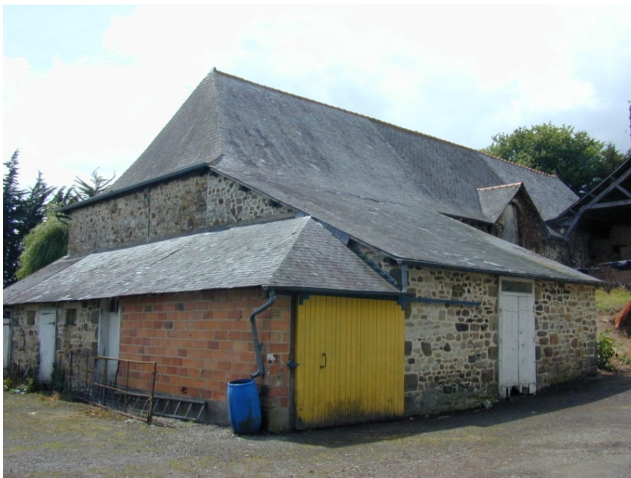
Vue nord-ouest des écuries
