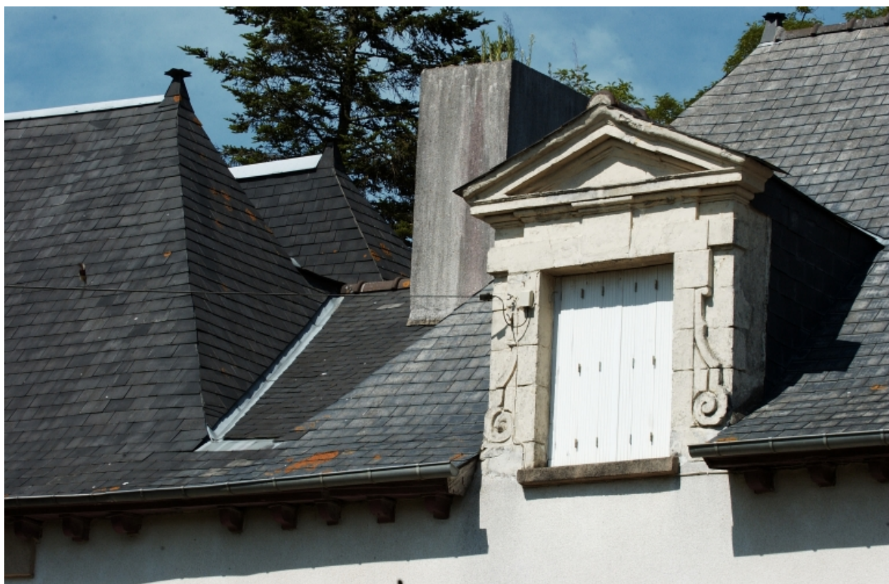
Lucarne en façade principale
