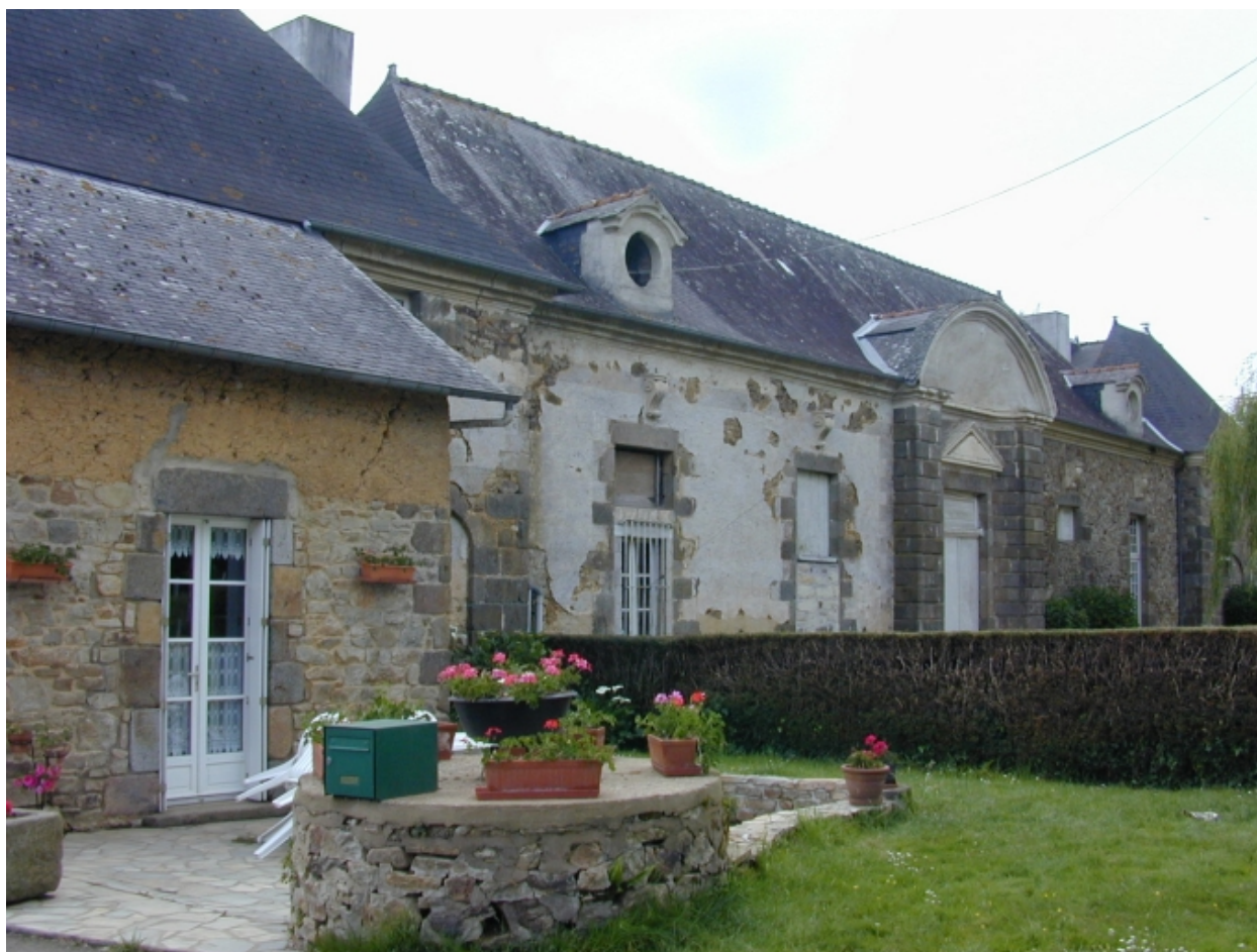
Vue sud-est de la remise
