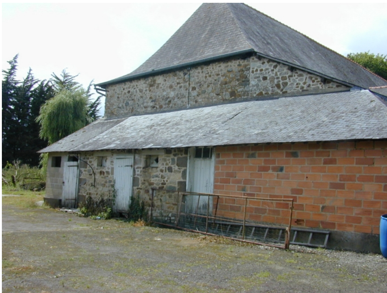
Vue des soues en appentis latéral
