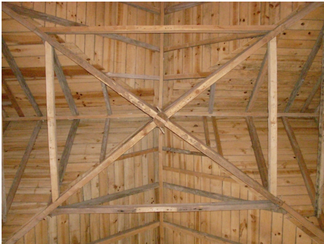
Pluguffan, chapelle Notre-Dame-des-Grâces : détail charpente apparente à la croisée du transept
