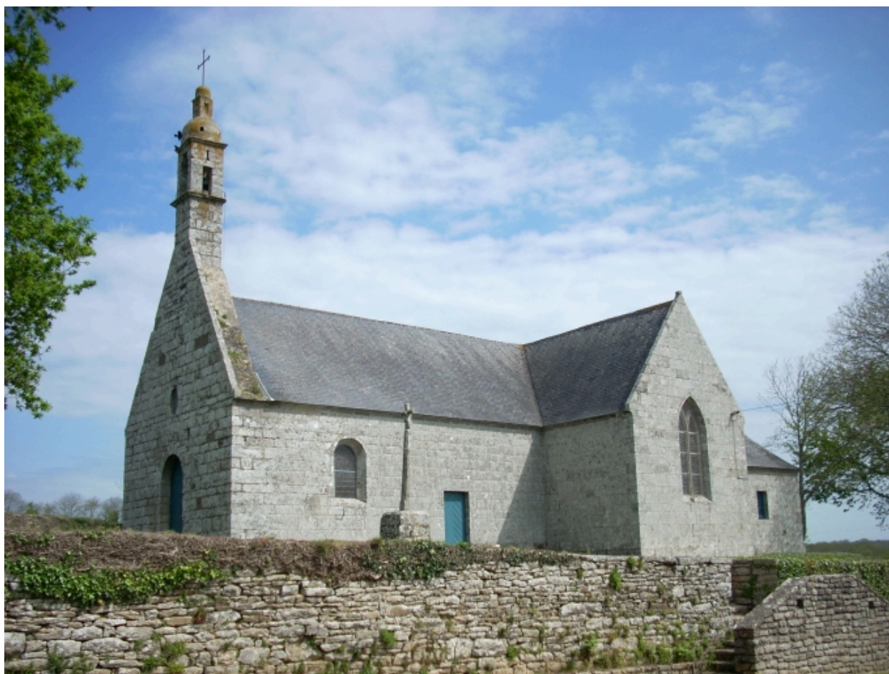
Pluguffan, chapelle Notre-Dame-des-Grâces : vue générale sud-ouest
