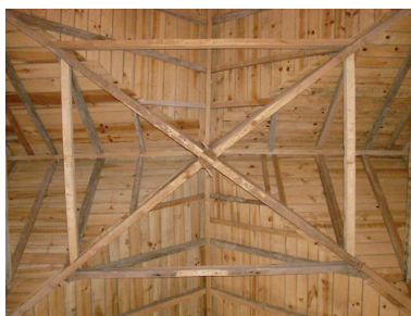
Pluguffan, chapelle Notre-Dame-des-Grâces : détail charpente apparente à la croisée du transept Phot. Gwénaél Fauchille IVR53_20082905839NUCA
