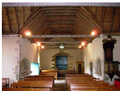
Pluguffan, chapelle Notre-Dame-des-Grâces : vue axiale ouest Phot. Gwénaél Fauchille IVR53_20082905838NUCA
