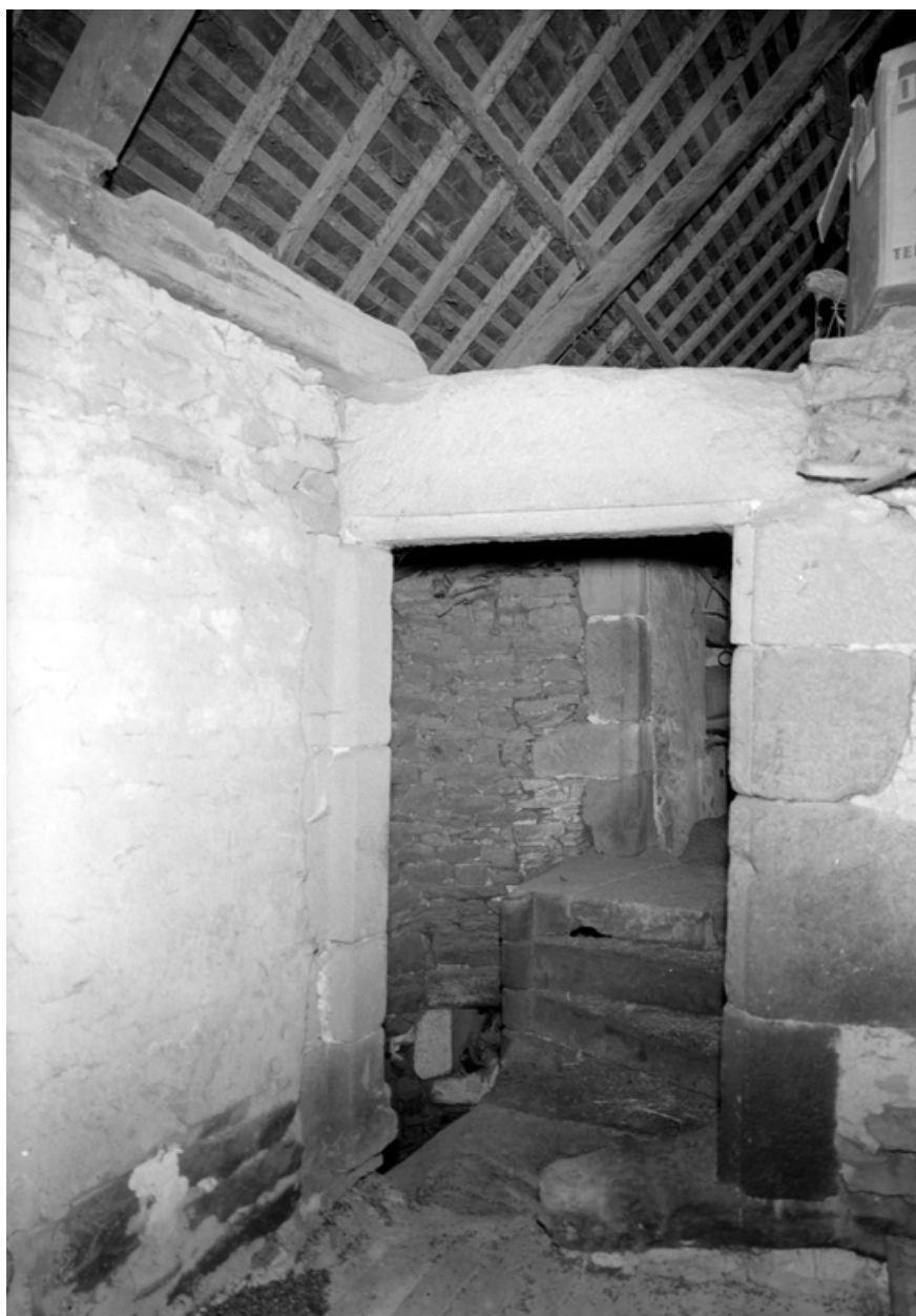
Vue de la porte d'accès à l'escalier
