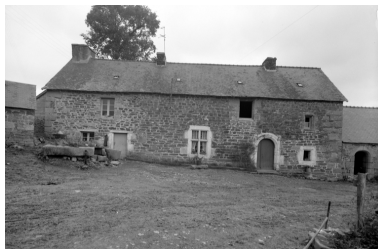
Vue de la face sud Phot. Guy Artur IVR53_19682201553V
