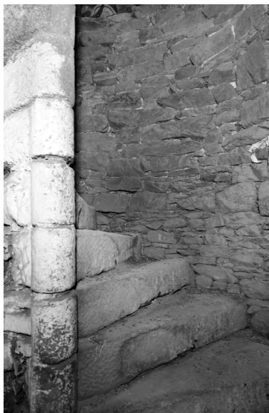
Vue de l'escalier principal en vis Phot. Guy Artur IVR53_19682201431V
