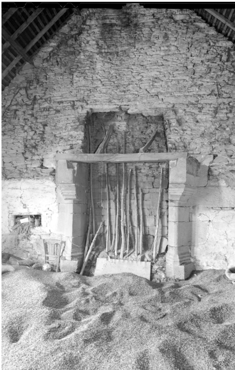
Vue de la cheminée ouest de la pièce ouest de l'étage
