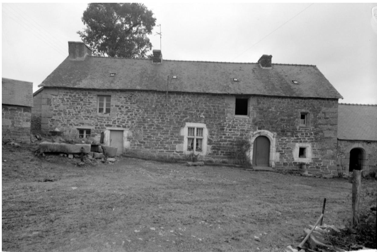
Vue de la face sud
