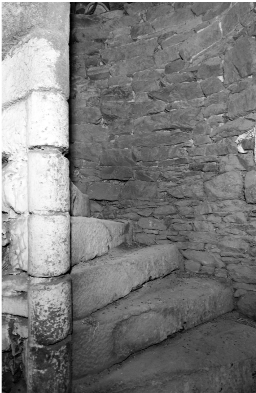
Vue de l'escalier principal en vis
