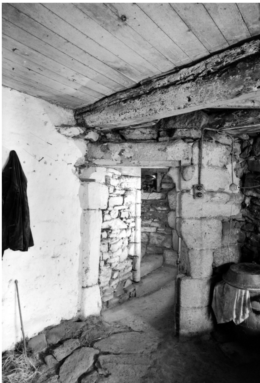
rez-de-chaussée : vue de l'angle nord-ouest de la pièce principale
