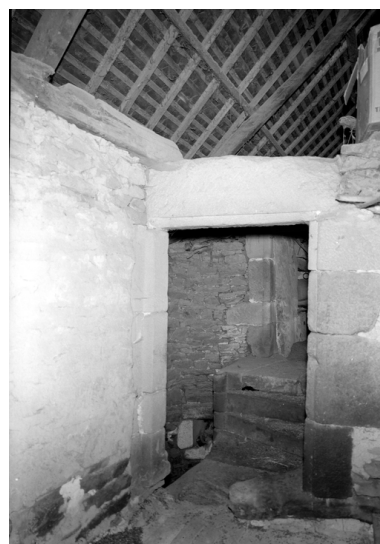
Vue de la porte d'accès à l'escalier Phot. Guy Artur IVR53_19682201432V
