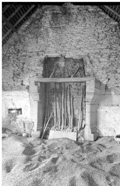
Vue de la cheminée ouest de la pièce ouest de l'étage Phot. Guy Artur IVR53_19682201430V
