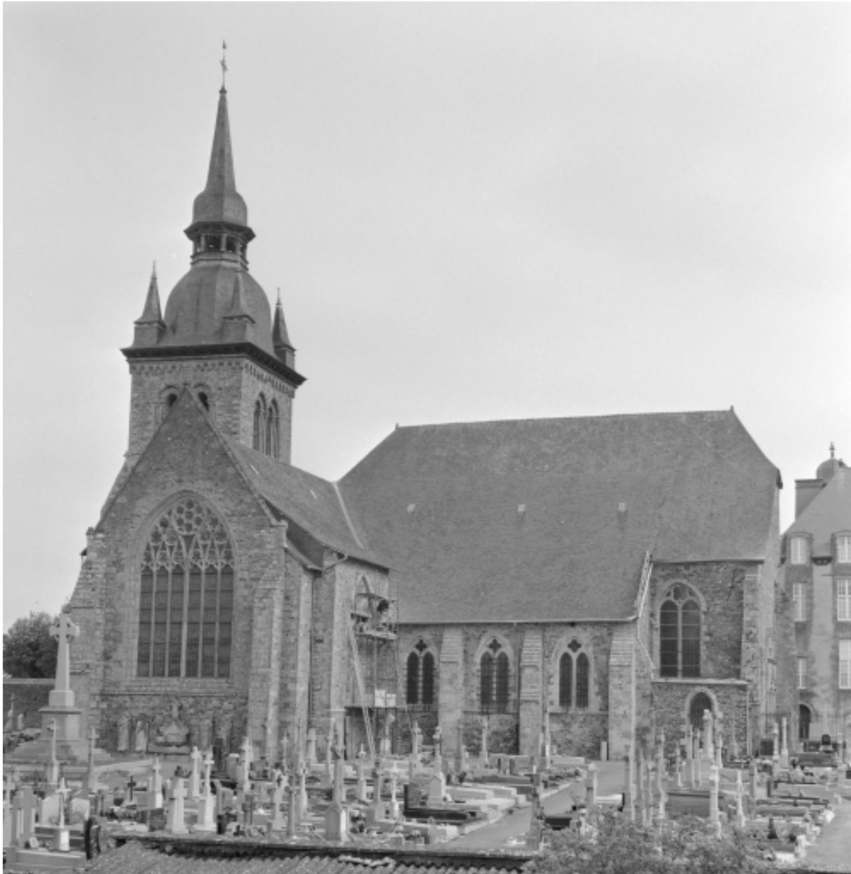
Elévation Sud : vue générale
