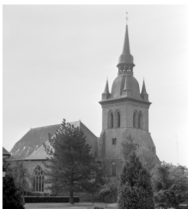
Elévation Nord-Ouest : vue générale Phot. Guy Artur, Phot. Norbert Lambart IVR53_19943500862X
