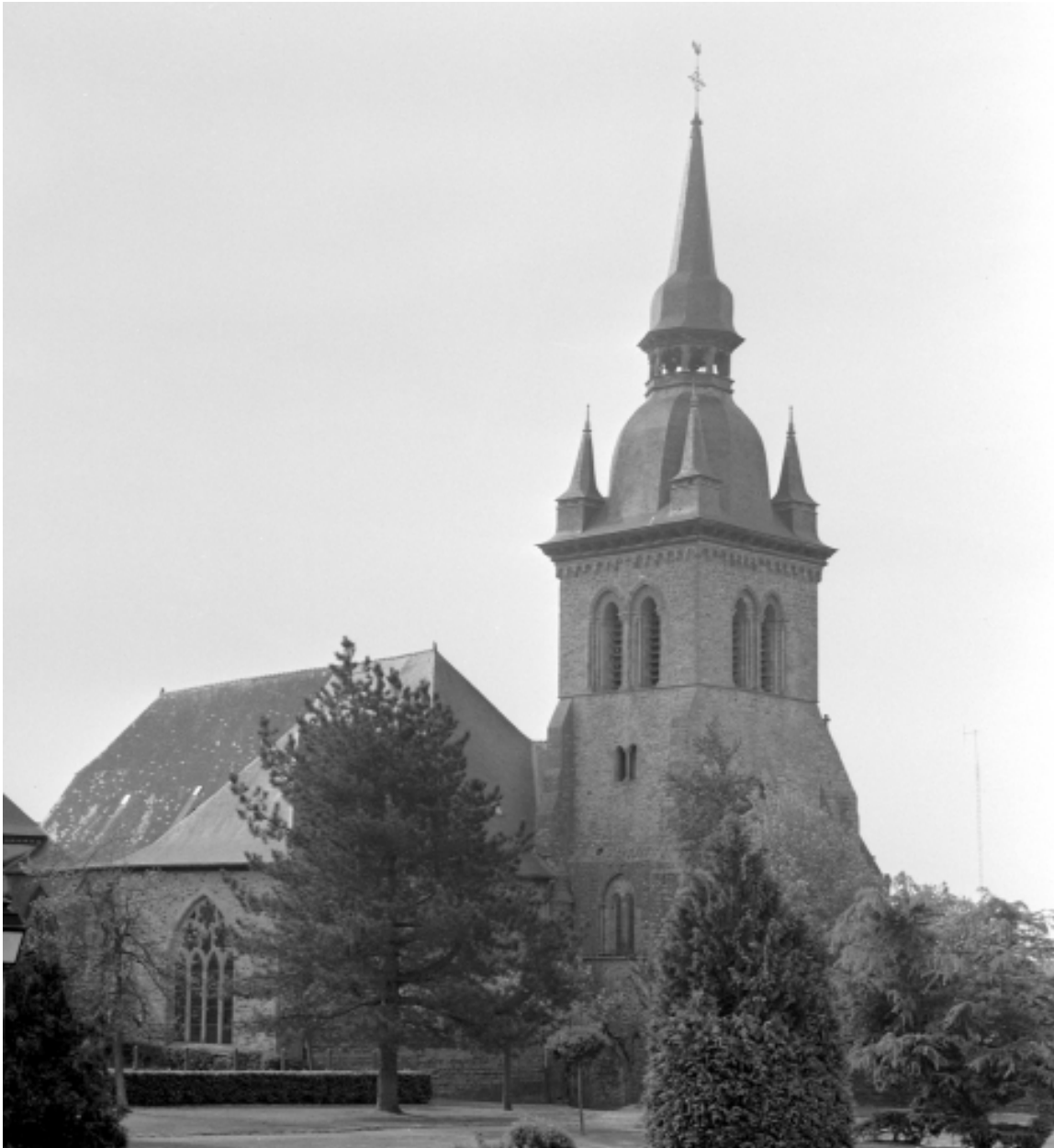
Elévation Nord-Ouest : vue générale
