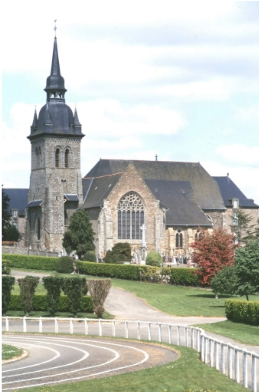
Vue générale prise du sud ouest.
