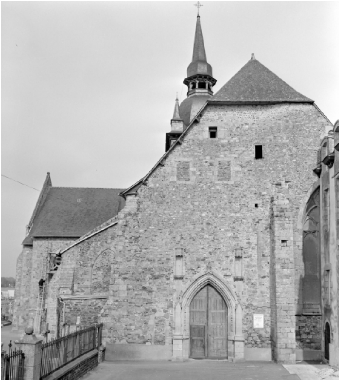
Elévation Est : vue générale
