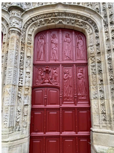
Vantail de droite Phot. Baptiste Oligo IVR53_20255611040NUCA
