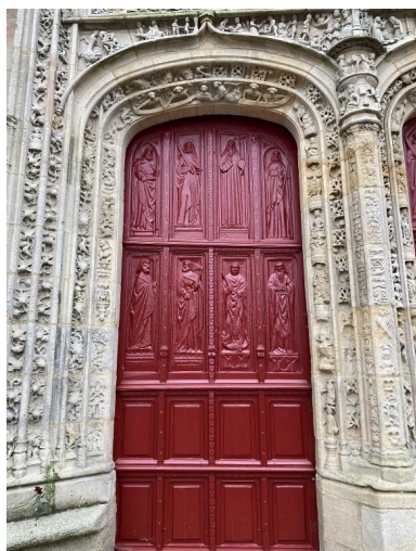
Vantail de gauche Phot. Baptiste Oligo IVR53_20255611041NUCA
