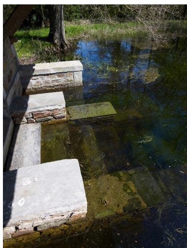
Vue de détail du lavoir Phot. Bernard Bègne IVR53_20155600113NUCA
