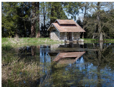
Lavoir privé, de style pittoresque avec buanderie et séchoir bordant la pièce d'eau Phot. Bernard Bègne IVR53_20155600111NUCA
