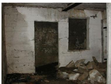
Vue de l'abri aménagé dans le rocher du Kernic : porte et fenêtre (état en 2002). Le mur est construit en béton armé de faible épaisseur
