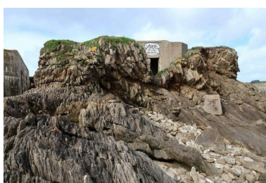
Vue générale (du côté de l'entrée du bunker vers l'est). Devant le bunker, les vestiges de la passerelle. A gauche, le bunker - abri Phot. Guillaume Lécueillier IVR53_20242911210NUCA
