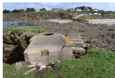
Vue générale. En arrière-plan, les vestiges de la passerelle Phot. Guillaume Lécueillier IVR53_20242911208NUCA
