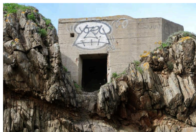
Vue générale (du côté de l'entrée du bunker vers l'est) Phot. Guillaume Lécueillier IVR53_20242911212NUCA
