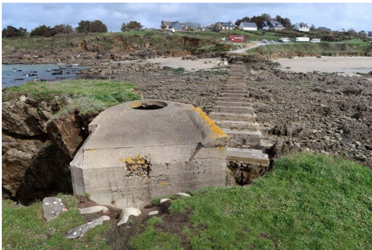
Vue générale. En arrière-plan, les vestiges de la passerelle
