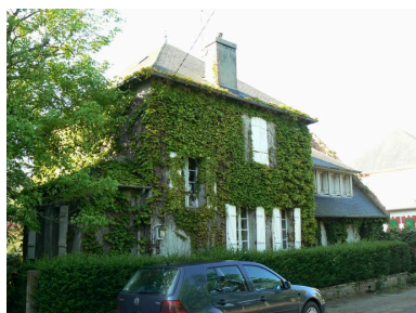
Villas Les Petite Gares, rue de Lesquiffinec Phot. Johan Vincent IVR53_20072908640NUCA
