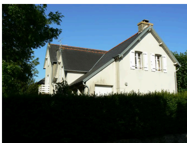
Pignon d'une des villas Les Petites Gares Phot. Johan Vincent IVR53_20072908639NUCA
