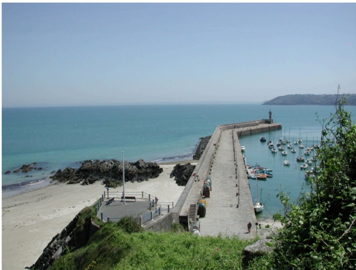
Vue du dessus de la jetée : remarquer la forme en ligne brisée de la digue et le parapet
