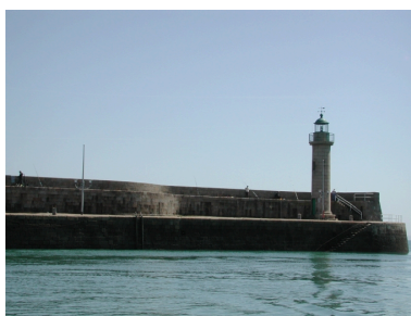
Vue du môle à son extrémité : remarquer la forme sinueuse du parapet Phot. Guy Prigent IVR53_20072206328NUCA
