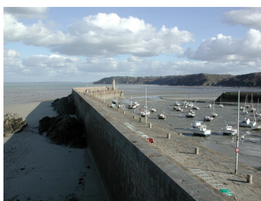
Vue du parapet et du mur du quai Phot. Guy Prigent IVR53_20072206322NUCA
