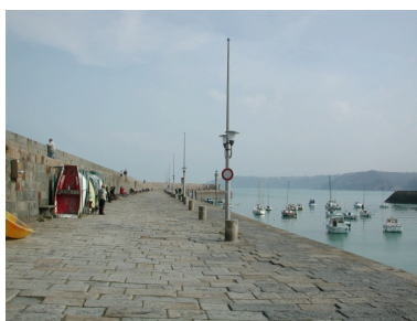
Vue du parement en pierre de taille de la jetée Phot. Guy Prigent IVR53_20072206323NUCA
