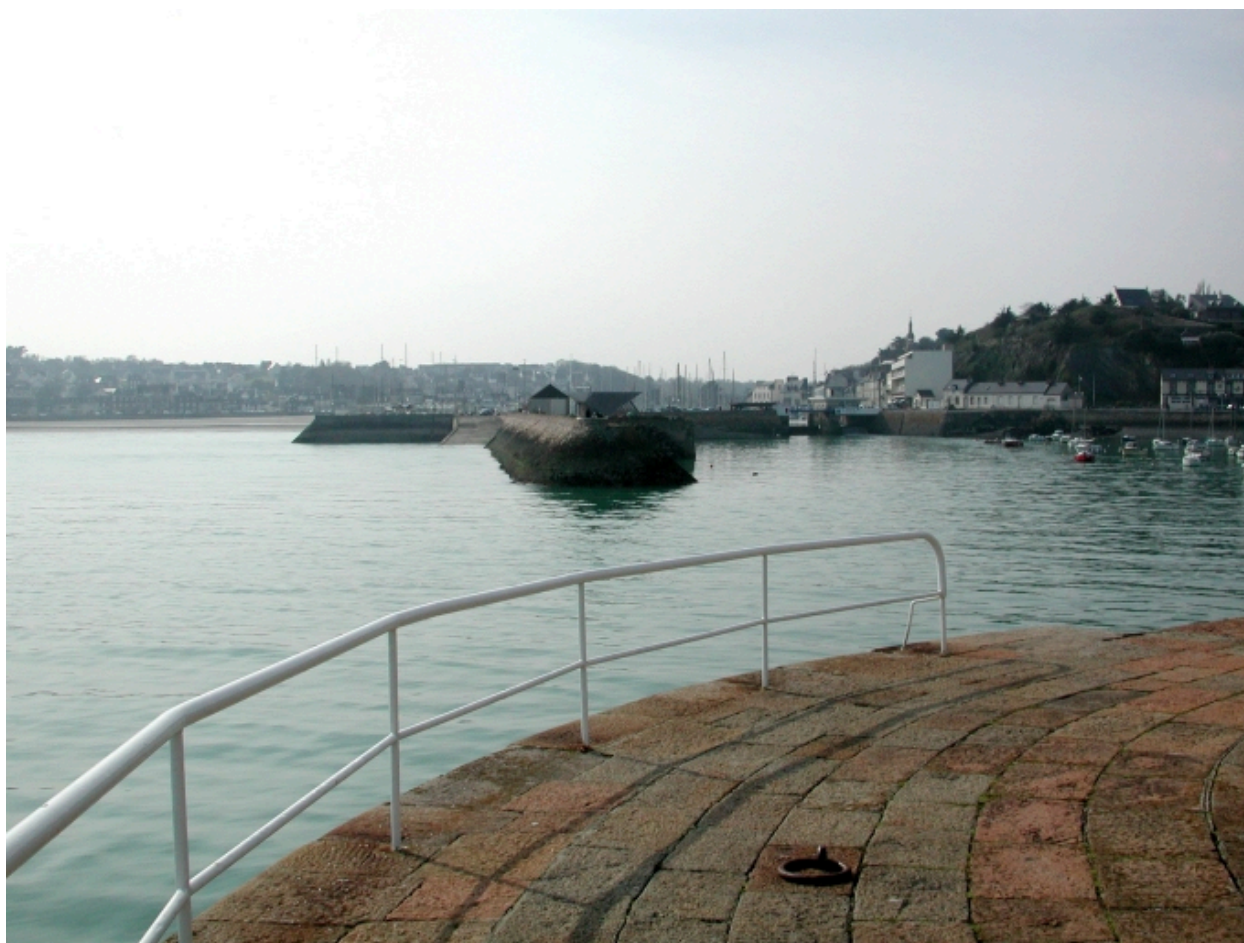
Vue du musoir du môle : remarquer la disposition circulaire des pierres de parement, faisant esplanade au pied du fanal
