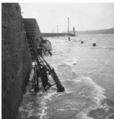
Le parapet du môle de Penthievre sous la marée : remarquer les dragues à coquilles, 1976 (AD 22, Fonds Joël) Phot. Guy Prigent, Autr. Joël Jouas Poutrel IVR53_20072206224NUCB
