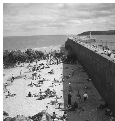
Vue du mur ouest du môle de Penthièvre : remarquer la forme du mur et le fruit prononcé de 10%, vers 1960-70 (AD 22) Phot. Guy Prigent, Autr. Joël Jouas Poutrel IVR53_20072206240NUCB
