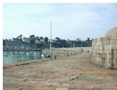
Vue de la jetée en amont Phot. Guy Prigent IVR53_20072206332NUCA
