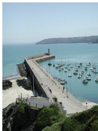
Vue générale Phot. Guy Prigent IVR53_20072206318NUCA
