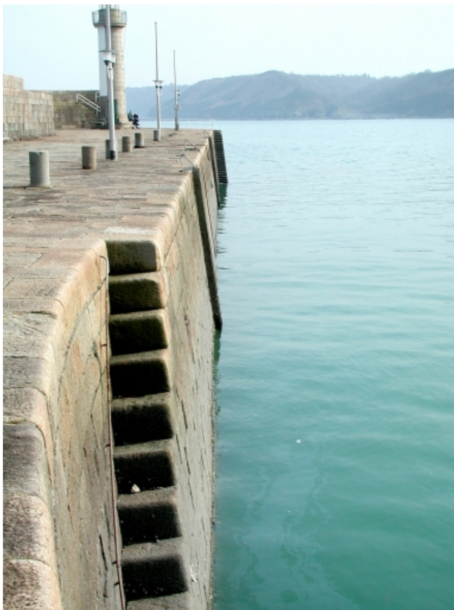
Vue en détail du mur de la jetée, côté avant-port, avec l'escalier : remarquer le fruit peu prononcé du mur du quai
