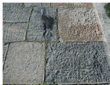
Vue de la disposition des pierres de recouvrement en granit gris et rose bouchardé Phot. Guy Prigent IVR53_20072206324NUCA
