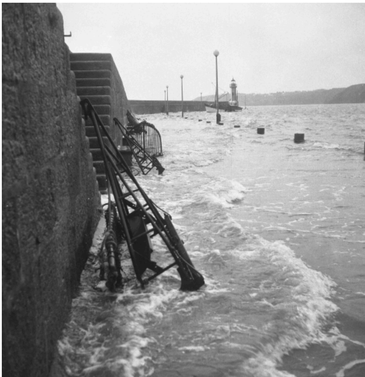
Le parapet du môle de Penthièvre sous la marée : remarquer les dragues à coquilles, 1976 (AD 22, Fonds Joël)
