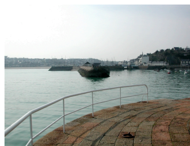
Vue du musoir du môle : remarquer la disposition circulaire des pierres de parement, faisant esplanade au pied du fanal Phot. Guy Prigent IVR53_20072206331NUCA
