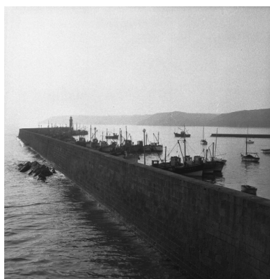
Le môle de Penthievre avec les bateaux de pêche dans l'avant- port, vers 1970 : remarquer le fruit vertical du mur du quai côté ouest (AD 22, Fonds Joël) Phot. Guy Prigent, Autr. Joël Jouas Poutrel IVR53_20072206311NUCB
