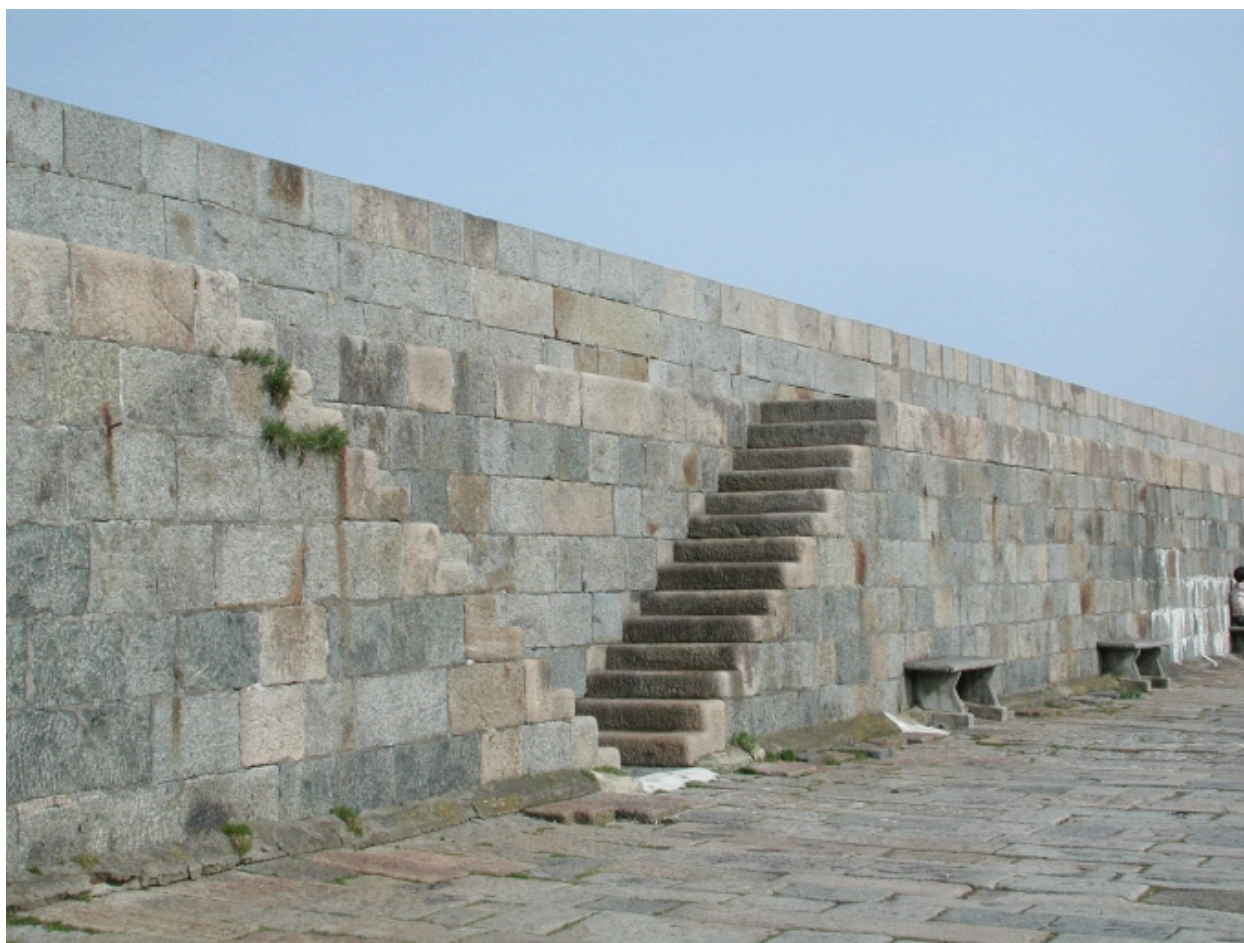
Vue du double escalier du parapet en granit taillé
