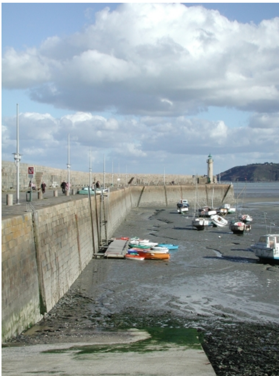
Vue du mur du quai de la jetée côté avant-port : remarquer la nouvelle cale en béton et les escaliers du quai
