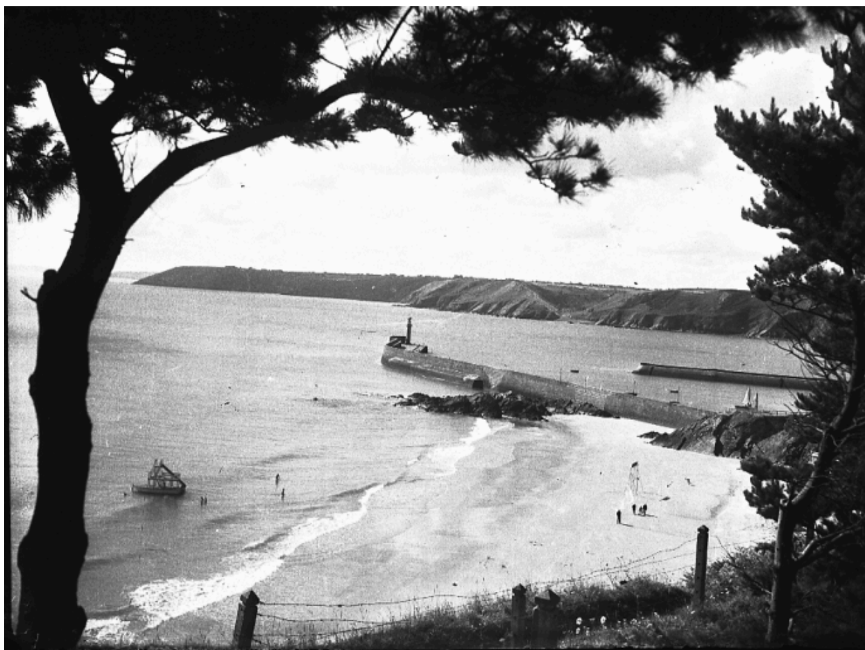
Vue de la jetée de Penthievre, avant les enrochements, juste après guerre : remarquer le plongeur et la présence des barbelés (AD 22, fonds Joël)
