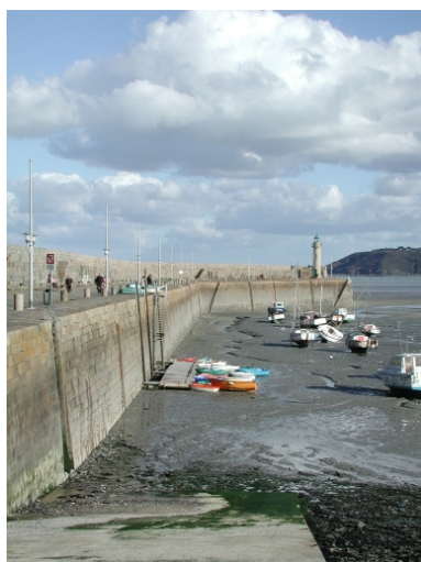
Vue du mur du quai de la jetée côté avant-port : remarquer la nouvelle cale en béton et les escaliers du quai Phot. Guy Prigent IVR53_20072206326NUCA
