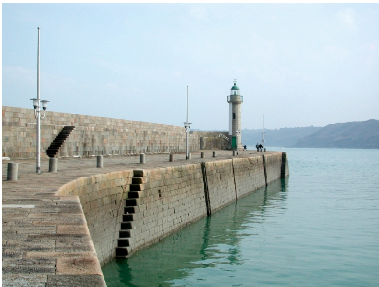
Vue du mur de quai en amont et des escaliers : remarquer le fruit du mur et la convexité du mur du parapet
