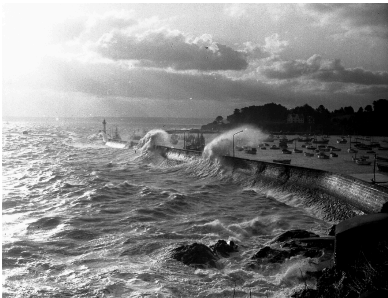
Le môle de Penthièvre et l'avant-port, un jour de tempête : remarquer les enrochements devant le mur du quai (AD 22, Fonds Joël)
