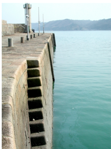
Vue en détail du mur de la jetée, côté avant-port, avec l'escalier : remarquer le fruit peu prononcé du mur du quai Phot. Guy Prigent IVR53_20072206334NUCA
