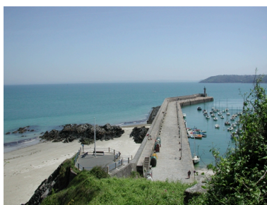
Vue du dessus de la jetée : remarquer la forme en ligne brisée de la digue et le parapet Phot. Guy Prigent IVR53_20072206320NUCA
