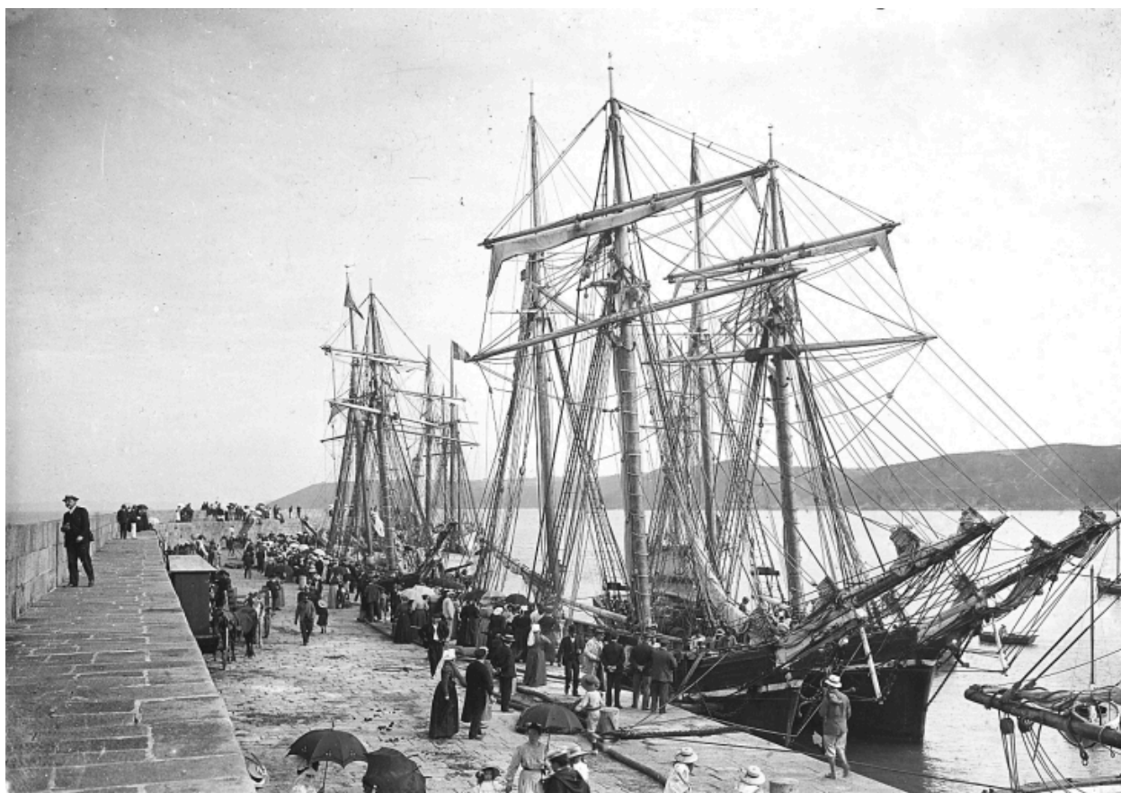
Goélettes en cours de déchargement (AD 22, fonds Barat)
