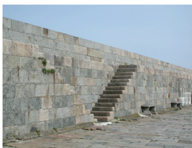
Vue du double escalier du parapet en granit taillé Phot. Guy Prigent IVR53_20072206327NUCA
