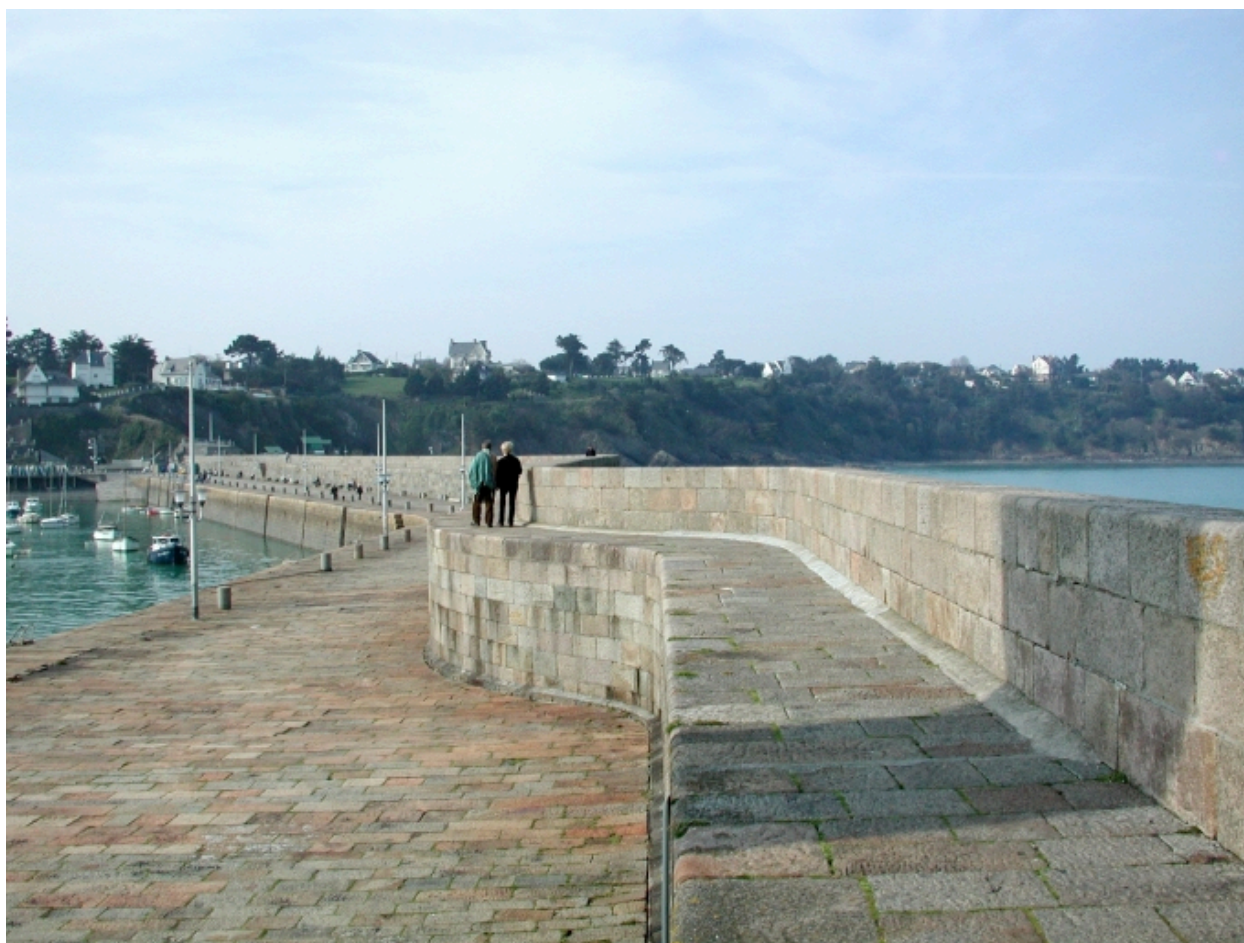
Vue de la forme ondulatoire du parapet
