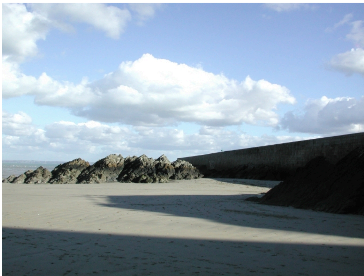
Vue à marée basse de la digue : remarquer les rochers et les enrochements
