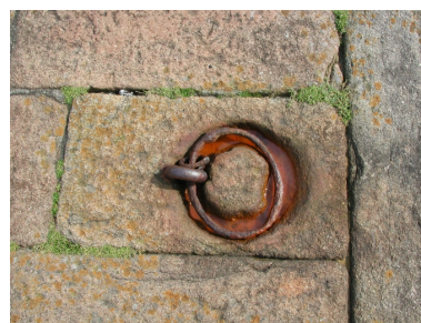
Vue en détail d'un anneau d'amarrage scellé au quai Phot. Guy Prigent IVR53_20072206335NUCA
