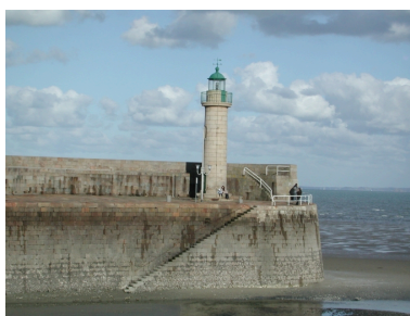
Vue du bout du môle : remarquer le musoir arrondi et l'escalier devant le fanal de la jetée Phot. Guy Prigent IVR53_20072206325NUCA
