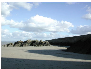
Vue à marée basse de la digue : remarquer les rochers et les enrochements Phot. Guy Prigent IVR53_20072206321NUCA
