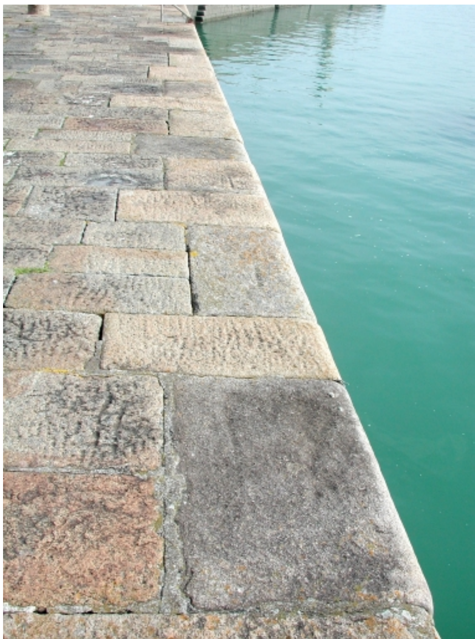
Vue en détail de l'agencement des pierres taillées au niveau de l'arête du quai
