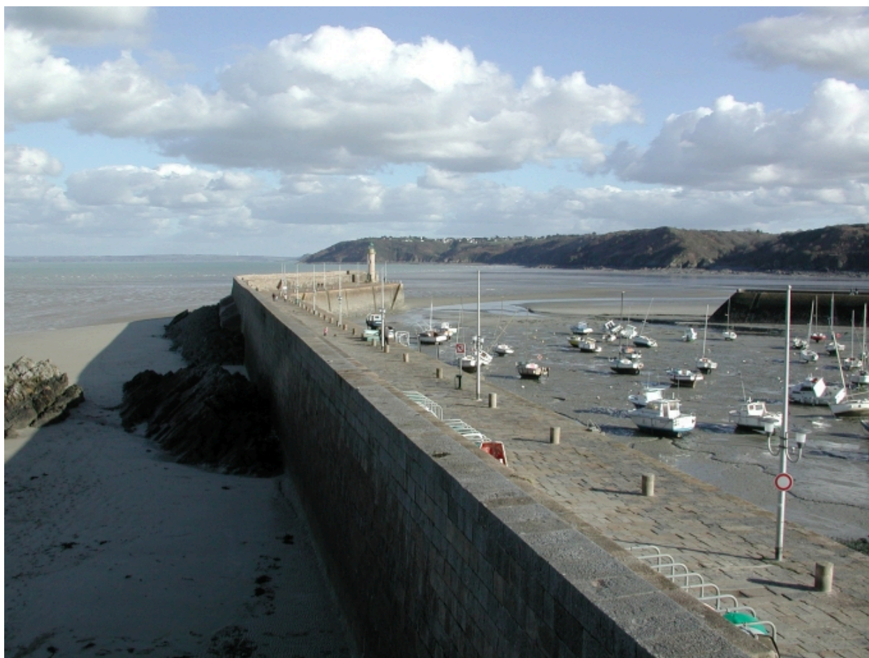
Vue du parapet et du mur du quai
