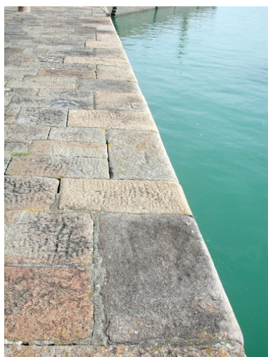
Vue en détail de l'agencement des pierres taillées au niveau de l'arête du quai Phot. Guy Prigent IVR53_20072206336NUCA
