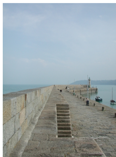
Vue du parapet Phot. Guy Prigent IVR53_20072206329NUCA
