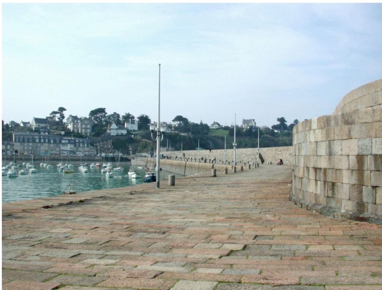
Vue de la jetée en amont
