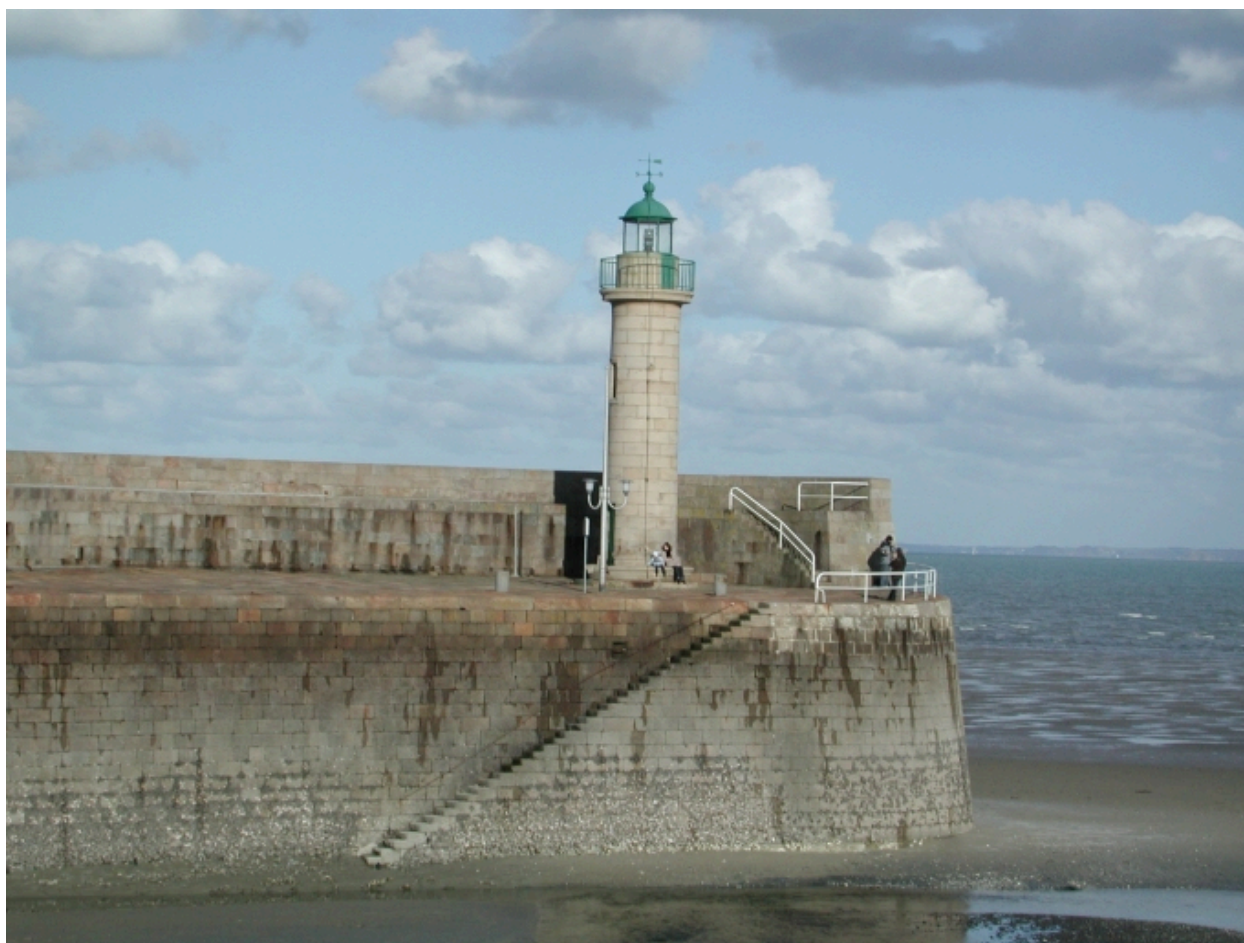
Vue du bout du môle : remarquer le musoir arrondi et l'escalier devant le fanal de la jetée
