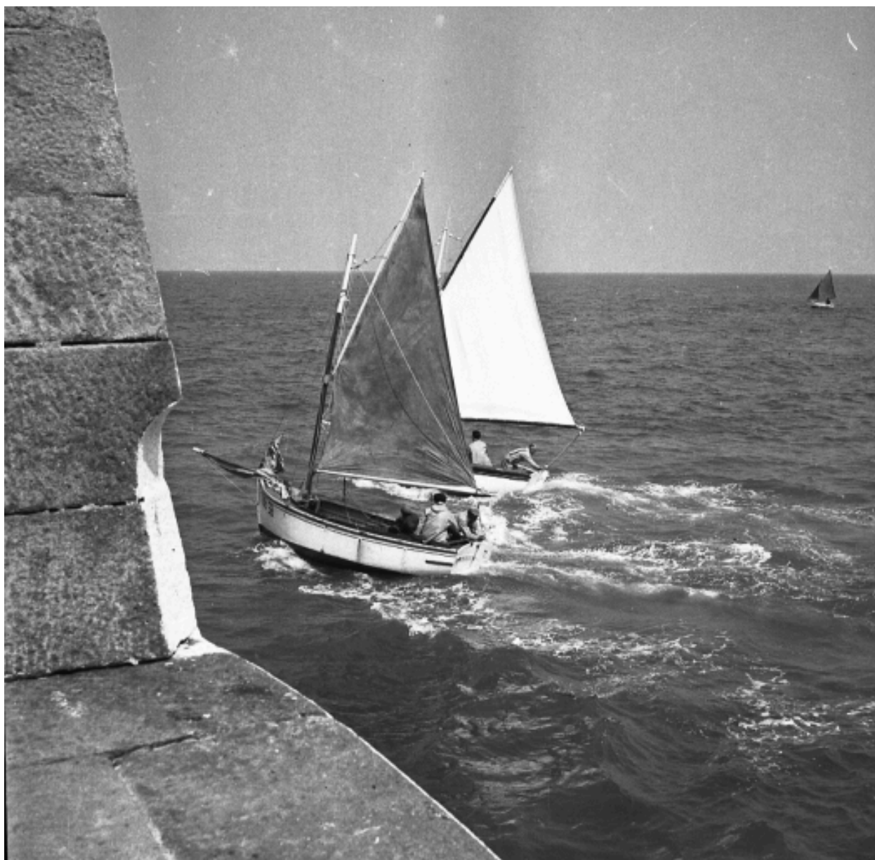
Le bout de la jetée du môle de Penthievre : remarquer le retour ouvragé (AD 22, Fonds Joël)
