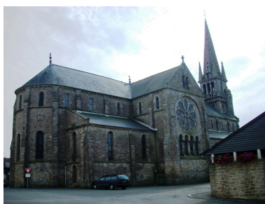
Lanmeur, église paroissiale Saint- Mélar : vue générale nord-est Phot. Gwénaél Fauchille IVR53_20082906530NUCA
