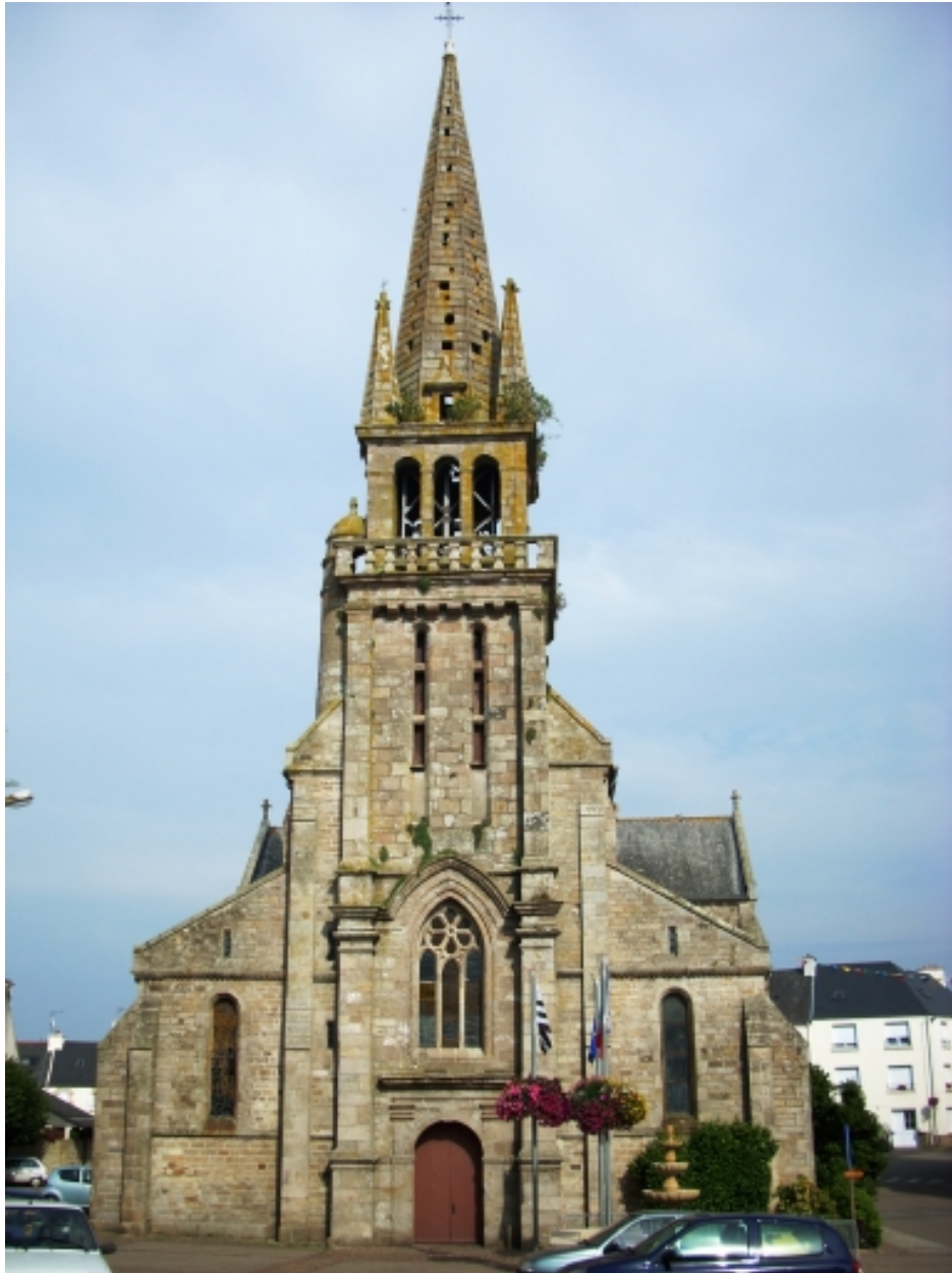
Lanmeur, église paroissiale Saint-Mélar : élévation ouest
