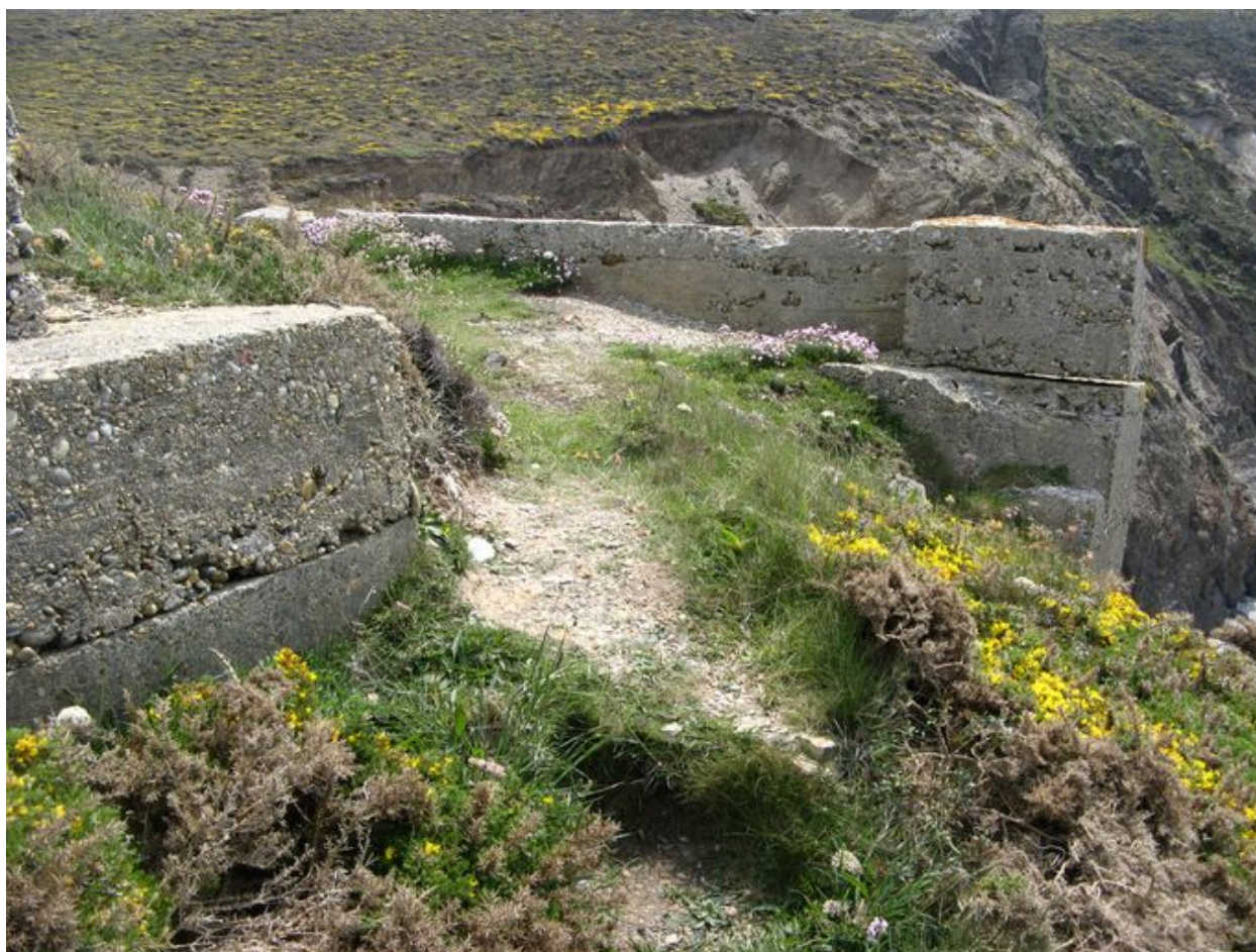
Poste de chargement de galets
