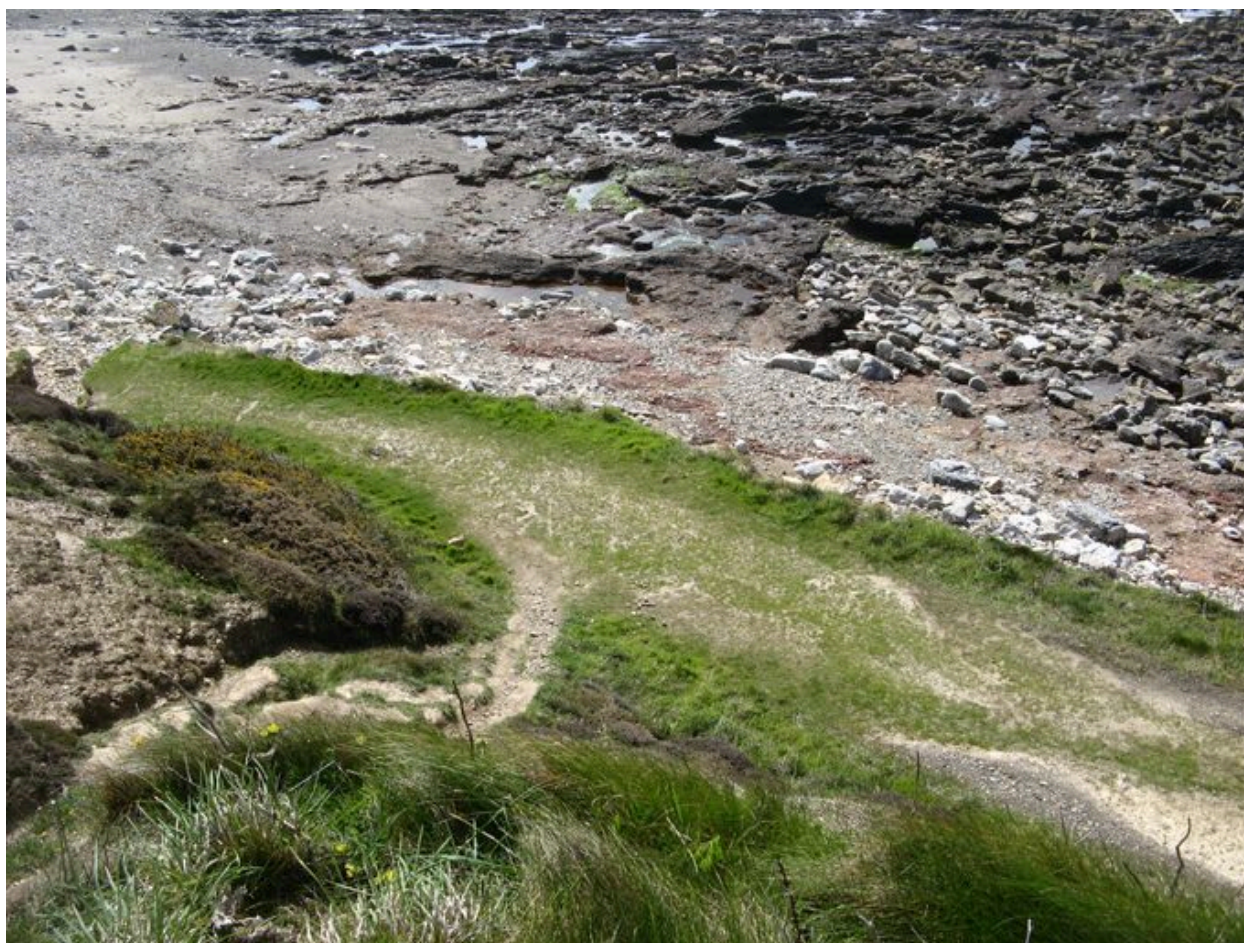
Rampe du site portuaire de Porzh Koubou depuis la falaise
