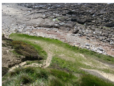
Rampe du site portuaire de Porzh Koubou depuis la falaise Phot. Guillaume Marie IVR53_20082908315NUCA
