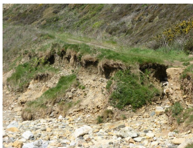
Détail de la rampe du site portuaire de Porzh Koubou Phot. Guillaume Marie IVR53_20082908313NUCA
