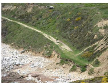
Rampe du site portuaire de Porzh Koubou depuis la falaise Phot. Guillaume Marie IVR53_20082908358NUCA
