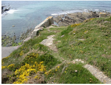
Vue arrière du poste de chargement de galets Phot. Guillaume Marie IVR53_20082908360NUCA
