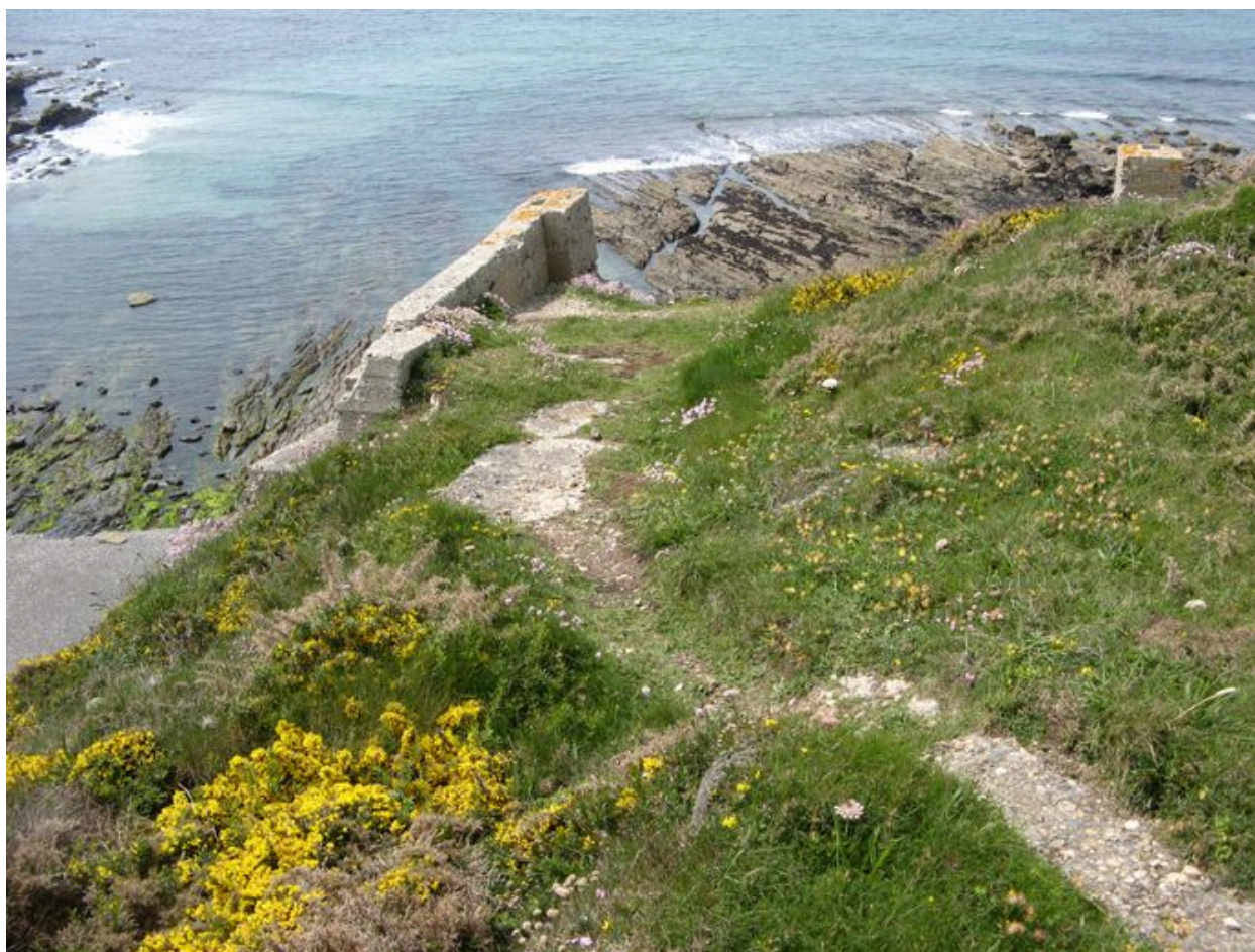
Vue arrière du poste de chargement de galets
