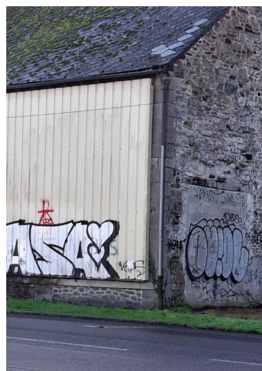
Entrepôt de stockage : partie est conservée (2 cellules), maçonnerie en pierre de taille et moellons visible Phot. Erwana L'Haridon IVR53_20262210022NUCA
