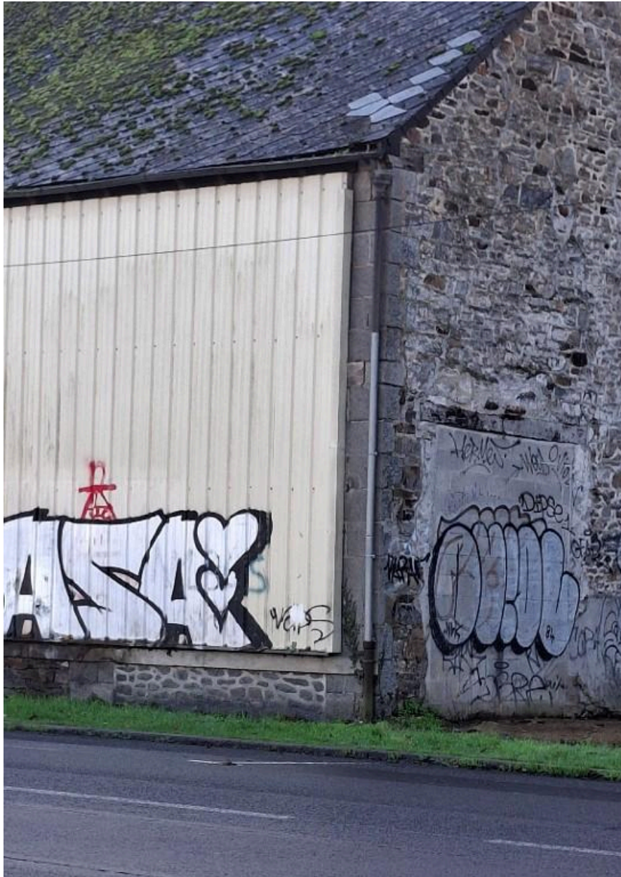
Entrepôt de stockage : partie est conservée (2 cellules), maçonnerie en pierre de taille et moellons visible
