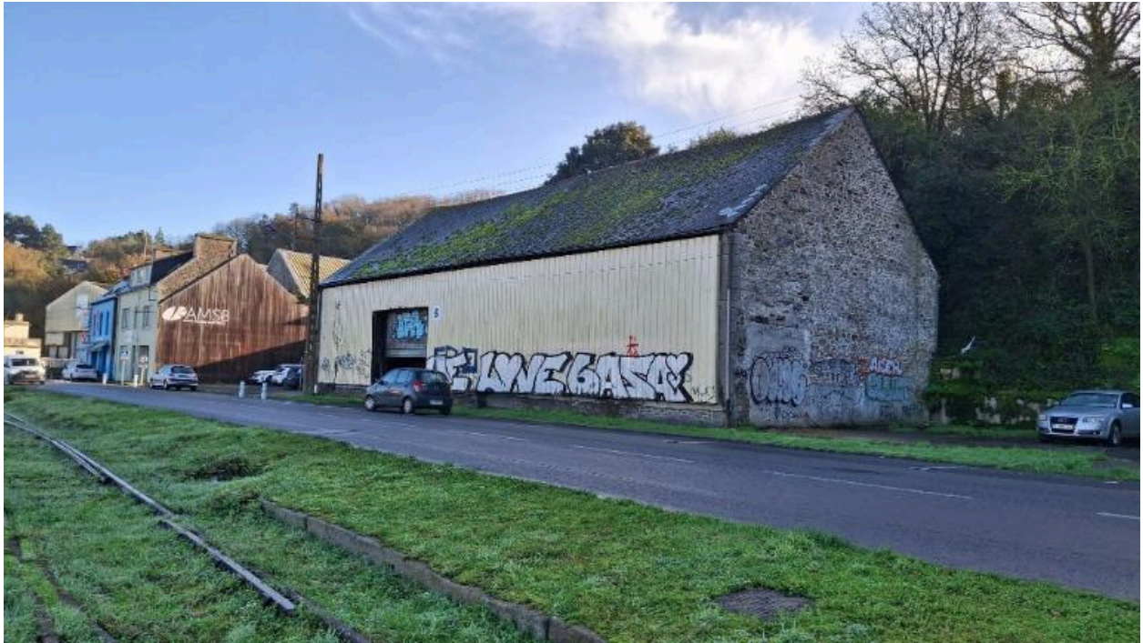
Entrepôt de stockage : partie est conservée (2 cellules), partie ouest détruite en 2004 ; ancien établissement Le Bigot & Thomas
