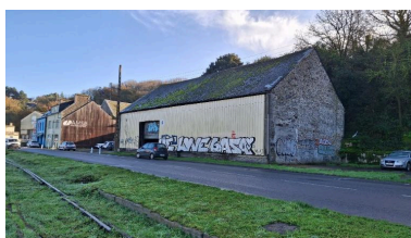
Entrepôt de stockage : partie est conservée (2 cellules), partie ouest détruite en 2004 ; ancien établissement Le Bigot & Thomas Phot. Erwana L'Haridon IVR53_20262210021NUCA
