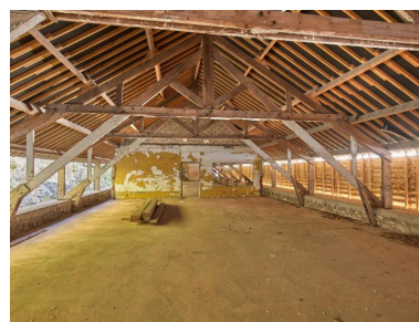
Étage et charpente des anciens ateliers. Phot. Bernard Bègne IVR53_20212200169NUCA
