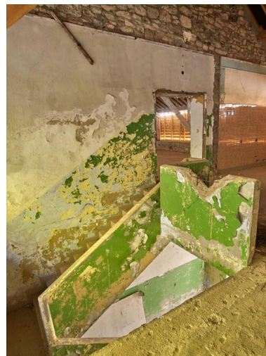
Vue intérieure des anciens ateliers. Phot. Bernard Bègne IVR53_20212200170NUCA
