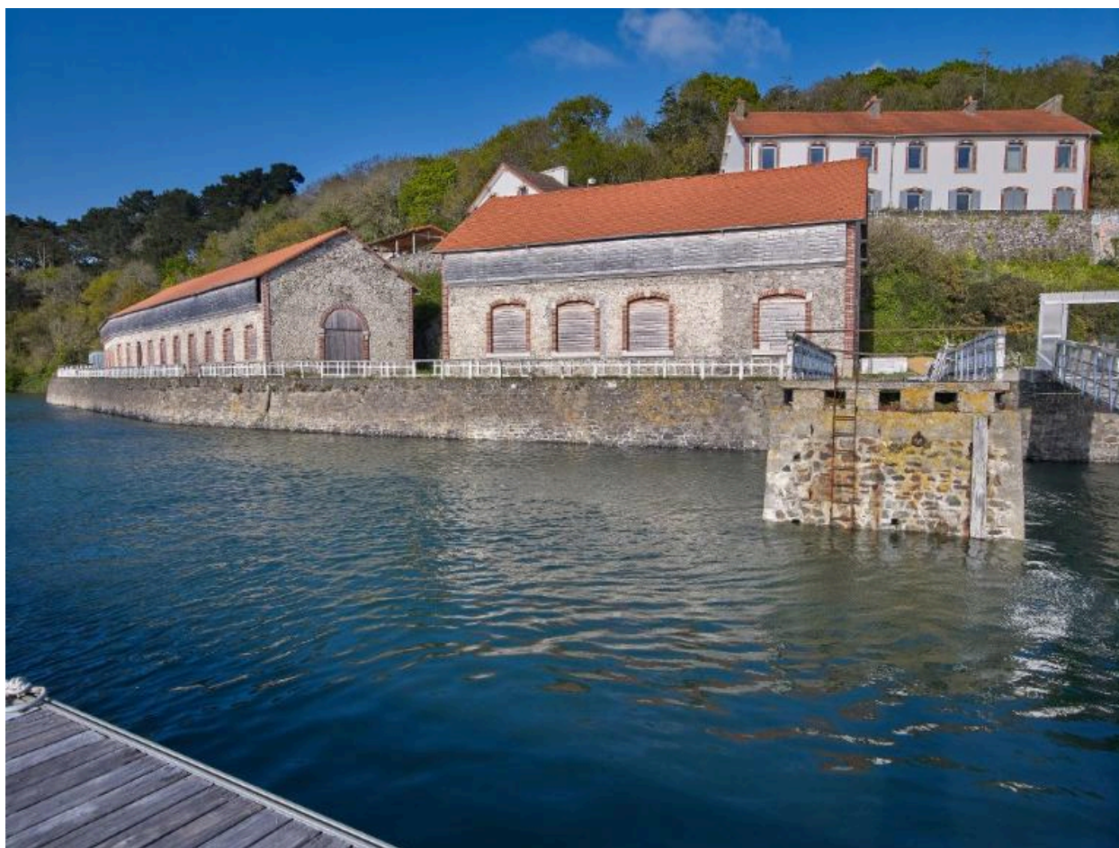
Vue d'ensemble prise d'un ponton : au premier plan, les anciens ateliers. A l'arrière-plan, la direction.
