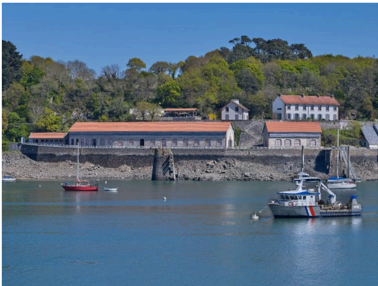
Vue d'ensemble du site de l'EAM. Au premier plan les anciens ateliers et le foyer. A l'arrière-plan, les logements et la direction.
