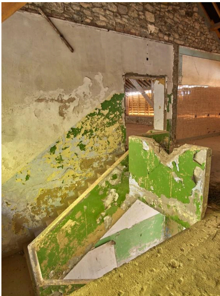
Vue intérieure des anciens ateliers.
