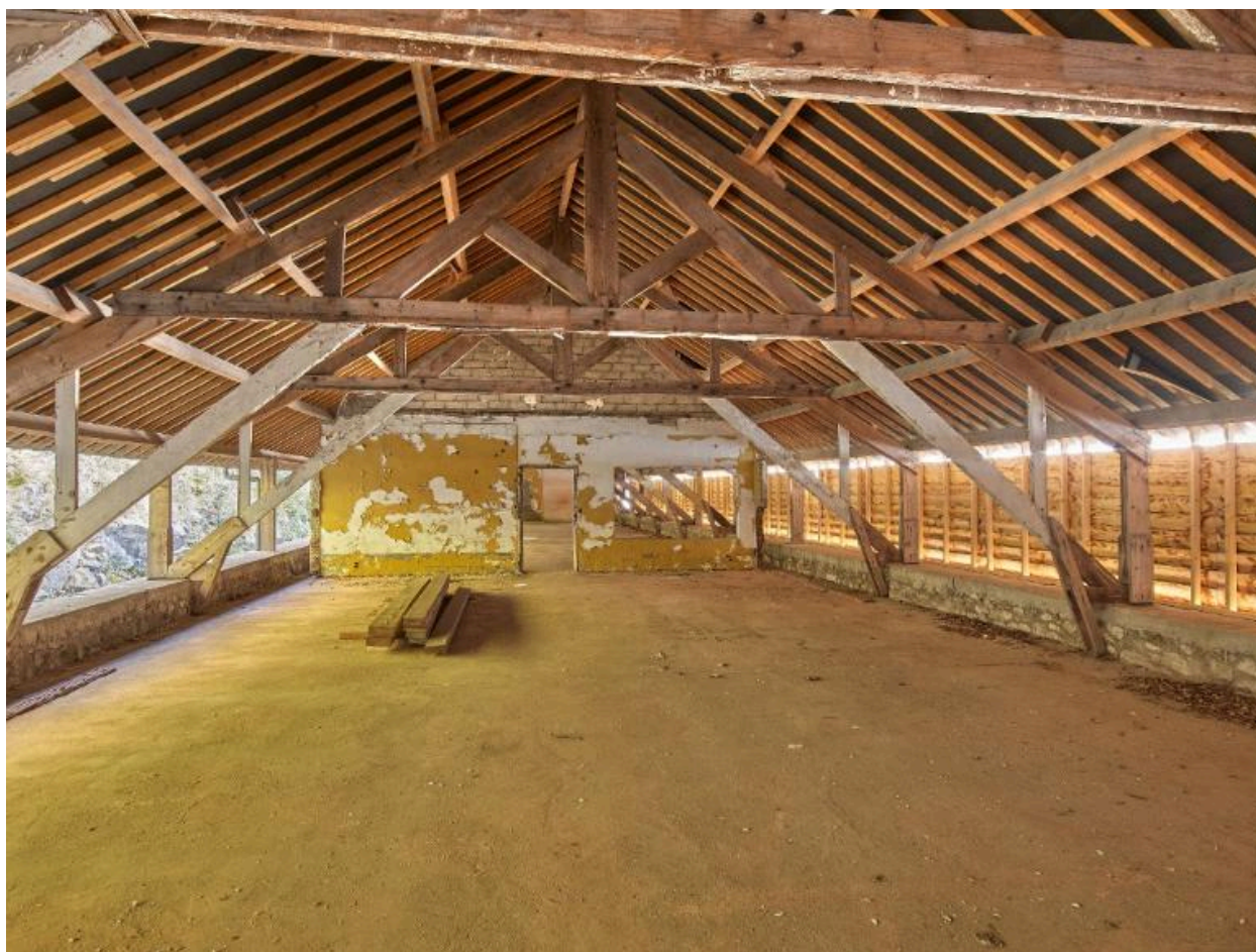
Étage et charpente des anciens ateliers.
