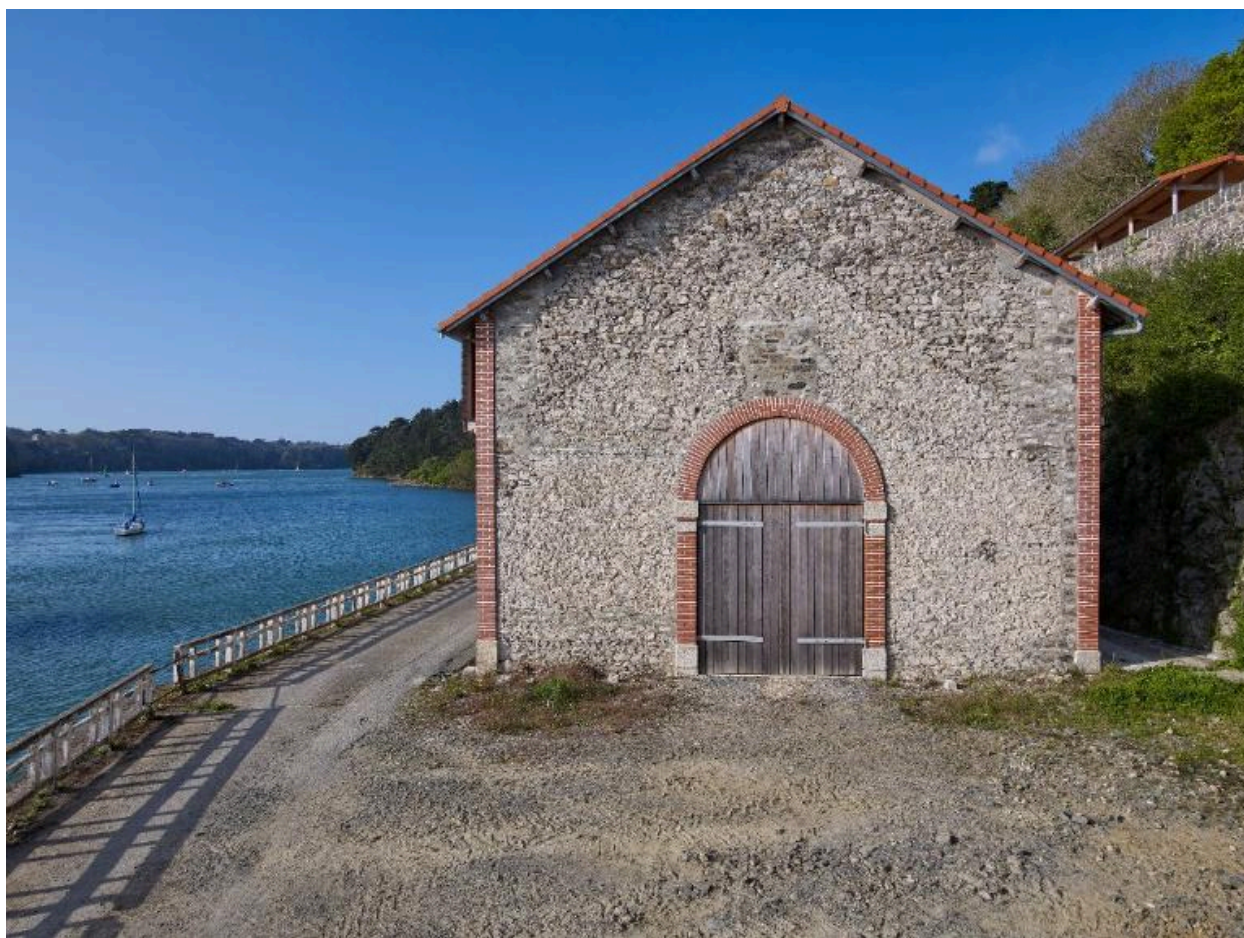
Pignon des anciens ateliers.
