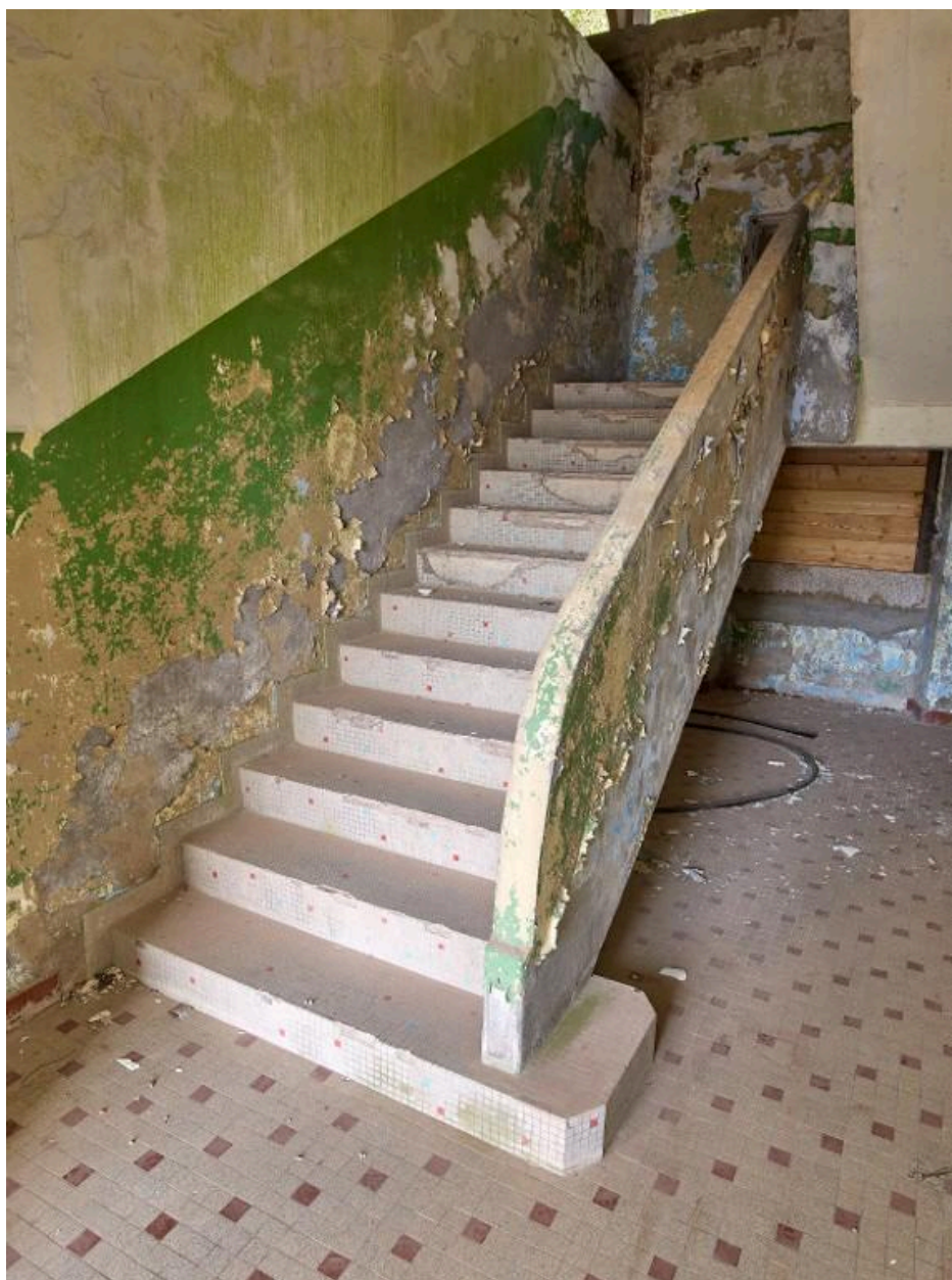
Vue intérieure des anciens ateliers.
