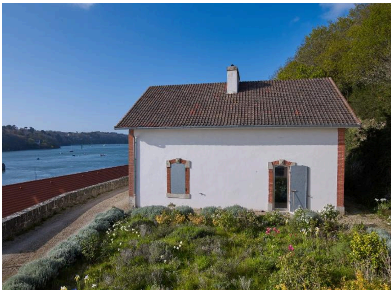
Vue d'ensemble d'une habitation.
