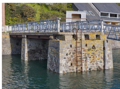
Quai d'accostage et ponton devant l'EAM. Phot. Bernard Bègne IVR53_20212200159NUCA
