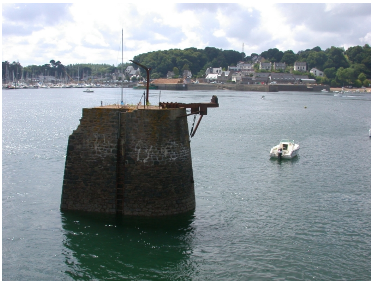
Vue de l'ancien quai
