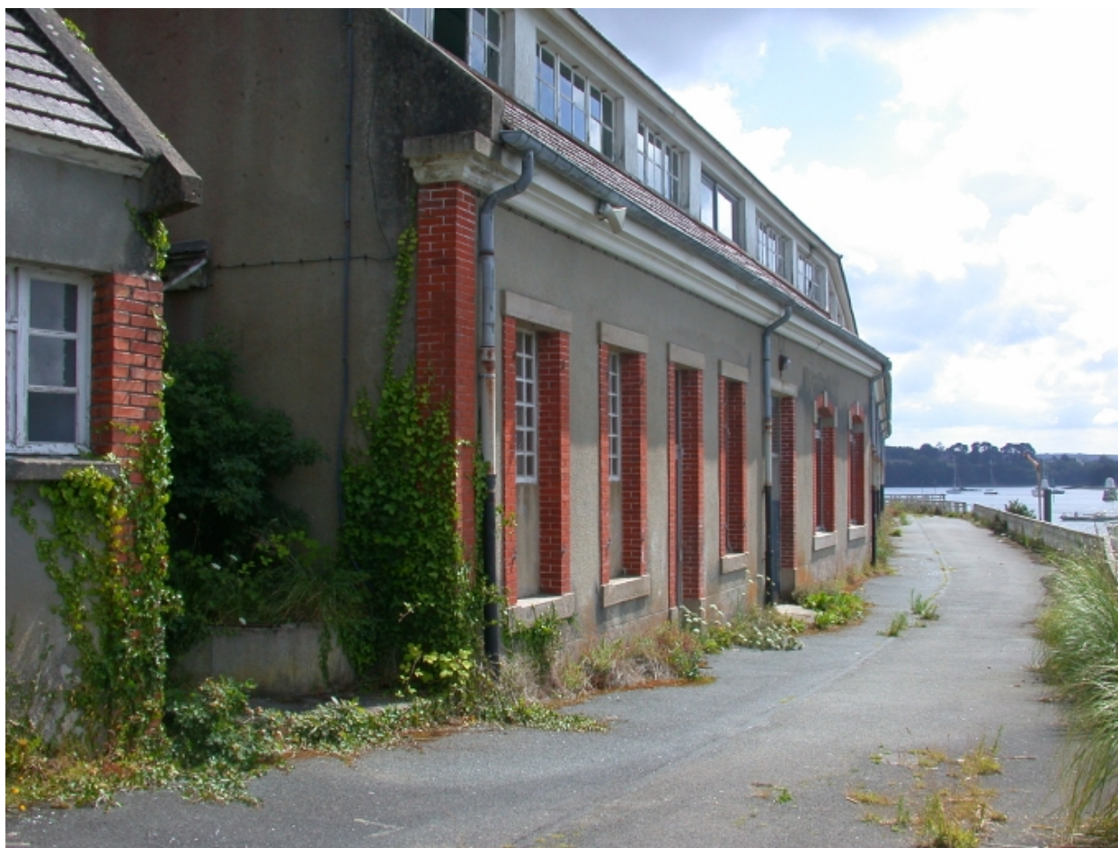
Vue du bâtiment principal désaffecté
