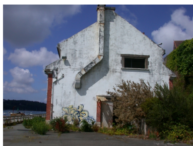
Vue du pignon Su-d-Ouest des bâtiments affectés aux cours et ateliers Phot. Guy Prigent IVR53_20092212457NUCA
