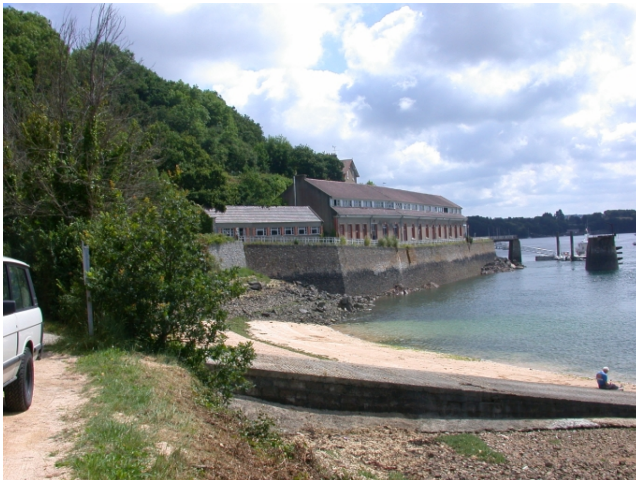
Vue des bâtiments et de la cale
