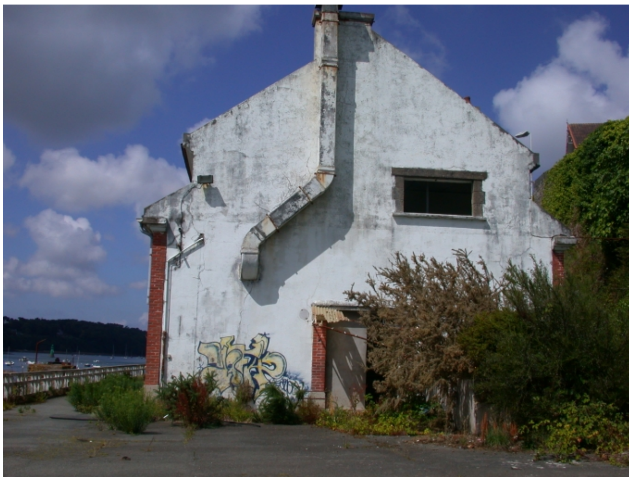
Vue du pignon Su-d-Ouest des bâtiments affectés aux cours et ateliers
