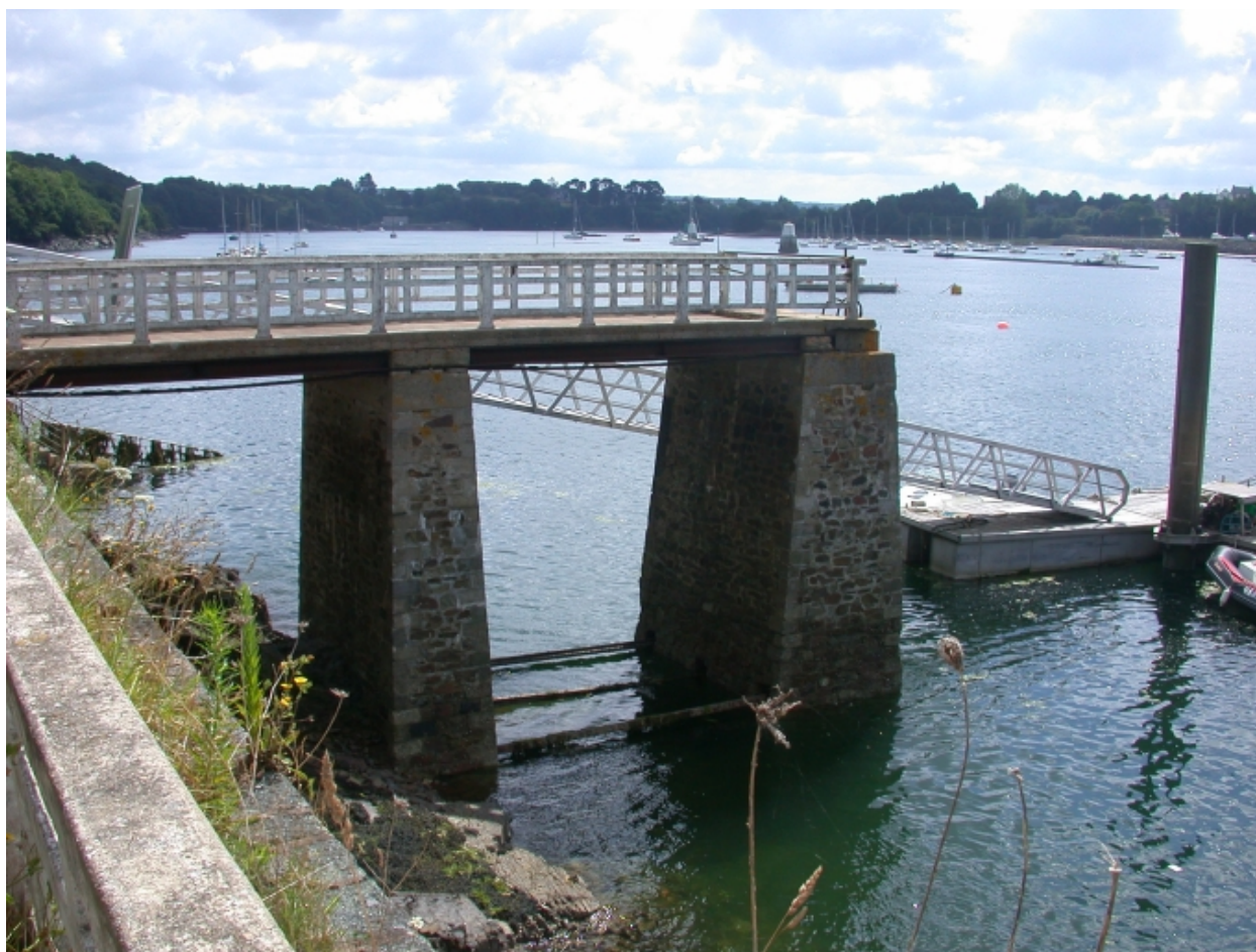
Vue de quai d'accostage et de sa passerelle
