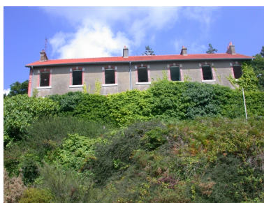
Vue des bâtiments administratifs désaffectés, situés en surplomb Phot. Guy Prigent IVR53_20092212458NUCA
