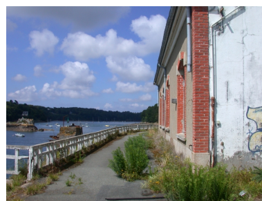
Vue des ateliers et de la terrasse Phot. Guy Prigent IVR53_20092212456NUCA
