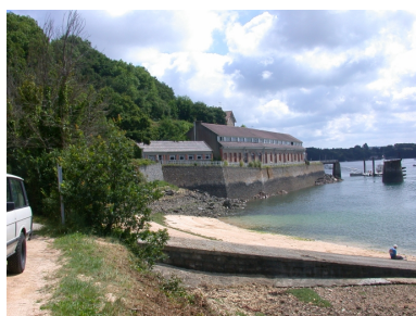
Vue des bâtiments et de la cale Phot. Guy Prigent IVR53_20092212459NUCA
