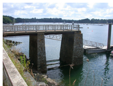
Vue de quai d'accostage et de sa passerelle Phot. Guy Prigent IVR53_20092212454NUCA
