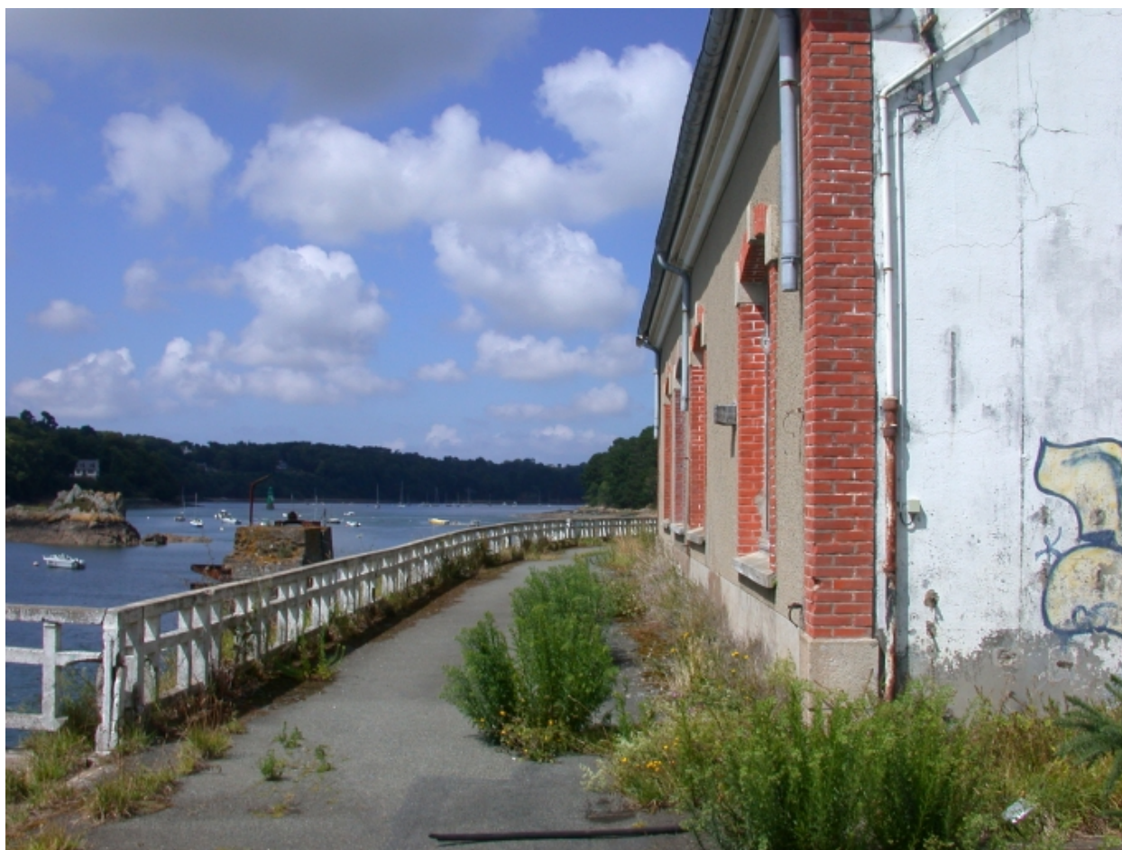
Vue des ateliers et de la terrasse
