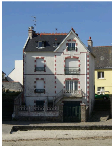
Vue générale de la maison de villégiature du 6 rue du Port Phot. Johan Vincent IVR53_20065606530NUCA
