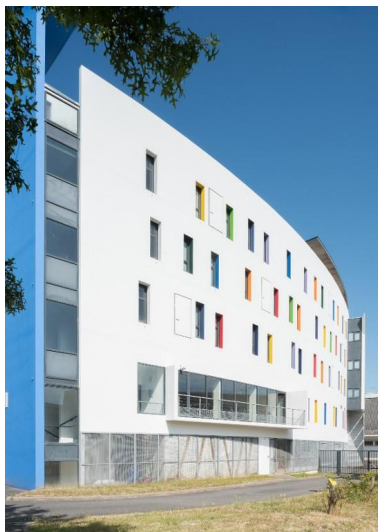
Internat : vue d'ensemble de la façade est. Agence Déesse 23, architectes, 2005-2006. Phot. Charlotte Barraud IVR53_20235600526NUCA
