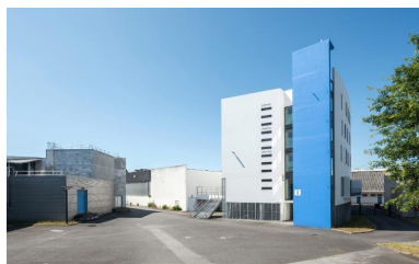
Internat. Façade sud. Agence Déesse 23, architectes, 2005-2006. Phot. Charlotte Barraud IVR53_20235600510NUCA
