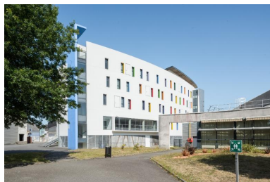
Internat : vue d'ensemble de la façade est. Agence Déesse 23, architectes, 2005-2006. Phot. Charlotte Barraud IVR53_20235600524NUCA
