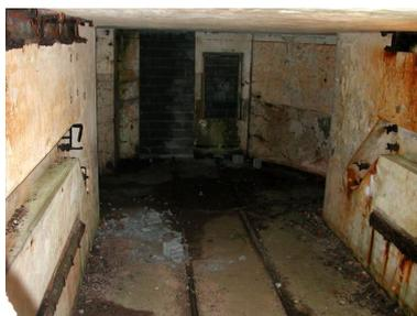
Vue de l'abri pour projecteur de 150 cm : rails et plaques tournante sont en place (état en 2002)
