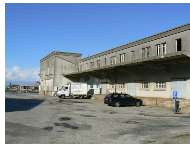
Elévation postérieure de la criée de Camaret Phot. Lénéaig L'Aot IVR53_20062908477NUCA
