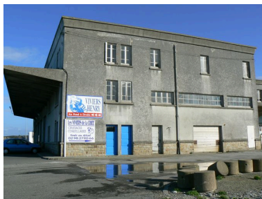
Elévation latérale de la criée de Camaret Phot. Lénéaig L'Aot IVR53_20062908476NUCA
