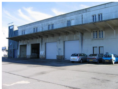
Elévation antérieure de la criée de Camaret Phot. Guillaume Marie IVR53_20062908335NUCA
