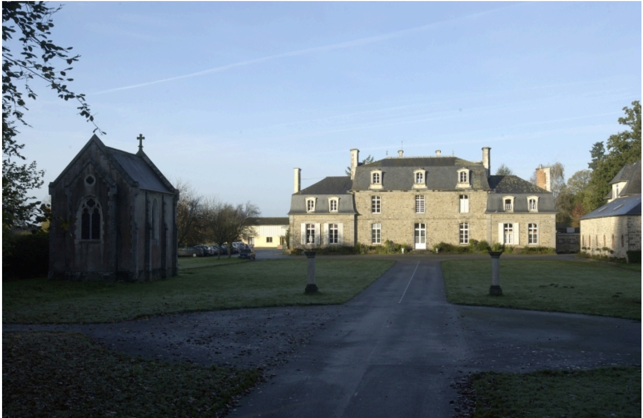
Vue générale est
