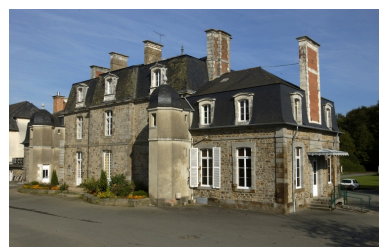
Vue sud-ouest Phot. Norbert Lambart IVR53_20053502816NUCA
