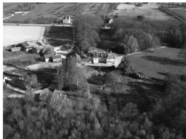
Vue aérienne vers le nord Phot. G.A.L.A.T. IVR53_19843500988V
