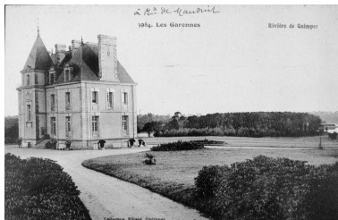
Vue générale de la façade depuis l'arrivée Phot. Elise Lauranceau IVR53_20042905516NUCB
