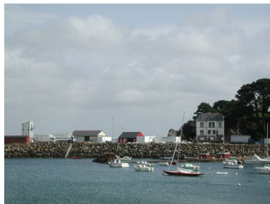
Les différents bâtiments à vocation maritime du port : le terre-plein de manutention, la chambre froide, la criée, le vivier, le local SNSM, l'atelier du mareyeur
