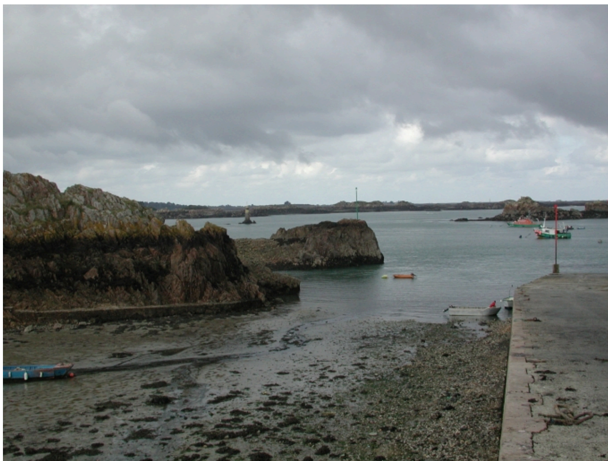
Vue générale du goulet du port et de la nouvelle cale
