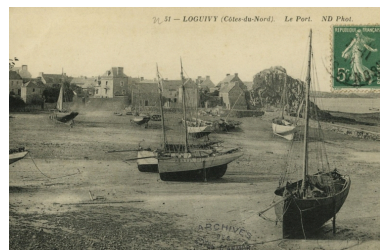
Le port de Loguivy de la mer vers 1910 : remarquer la cale ouest, les murs de soutènement et les langoustiers à viviers (AD 22 16 Fi) Phot. Guy Prigent, Phot. Auteur inconnu IVR53_20082207075NUCB
