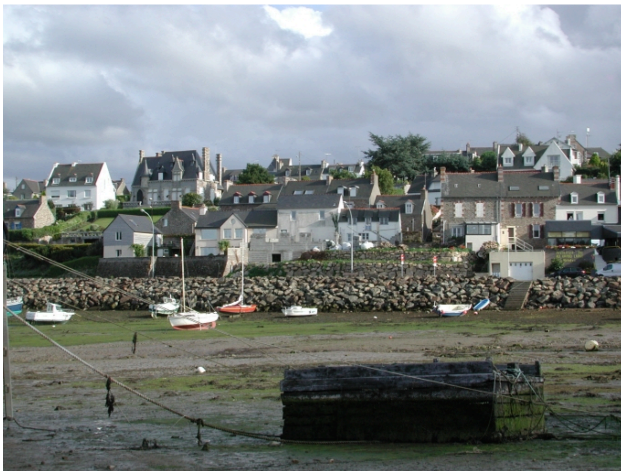
Les enrochements de la partie Est du port
