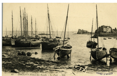
Le port très encombré de Loguivy de la mer vers 1910 : remarquer les canots creux, homardiers de loguivy (AD 22 16 Fi) Phot. Guy Prigent, Phot. Auteur inconnu
