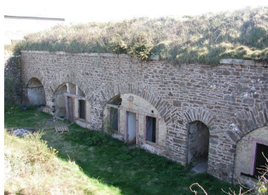
Vue de la cour et des du casernement (état en 2007). Le réduit est daté par millésime de 1884 Phot. Guillaume Lécueillier IVR53_20072906535NUCA
