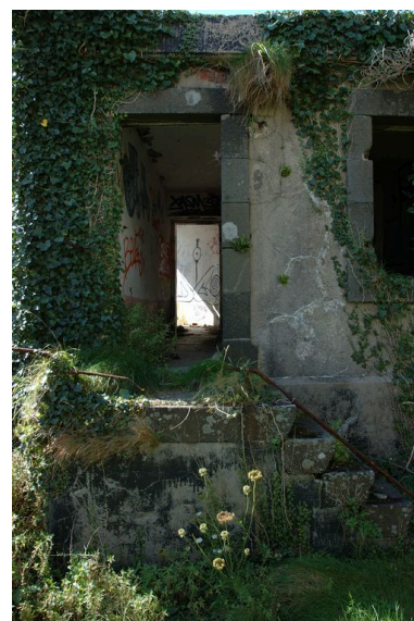
Vue du poste de commandement de groupe de Toulbroc'h implanté dans le fossé sec au sud-ouest (état en 2007) Phot. Guillaume Lécueillier IVR53_20072907152NUCA
