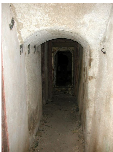
Vue de l'un des couloirs de circulation (état en 2007) Phot. Guillaume Lécueillier IVR53_20072906538NUCA
