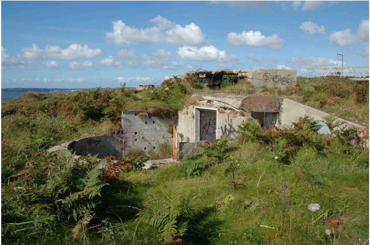
Vue de l'observatoire situé devant le poste de commandement de groupe de Toulbroc'h (état en 2007)
