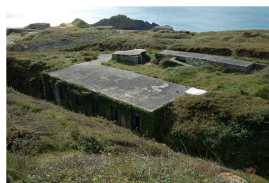
Vue du poste de commandement de groupe de Toulbroc'h implanté dans le fossé sec au sud-ouest (état en 2007) Phot. Guillaume Lécueillier IVR53_20072907149NUCA
