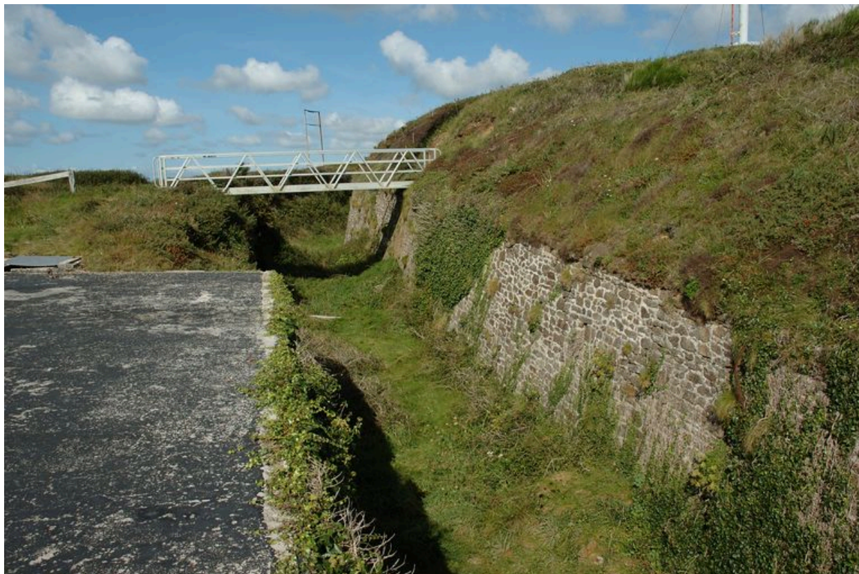
Vue du fossé sec au sud-ouest (état en 2007). A gauche, la dalle de couverture du poste de commandement de groupe de Toulbroc'h
