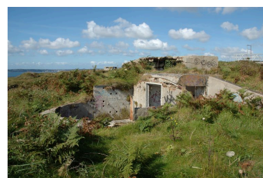
Vue de l'observatoire situé devant le poste de commandement de groupe de Toulbroc'h (état en 2007) Phot. Guillaume Lécueillier IVR53_20072907155NUCA
