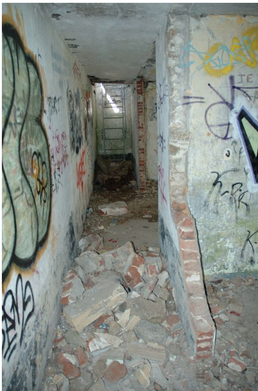
Vue intérieur du poste de commandement de groupe de Toulbroc'h implanté dans le fossé sec au sud-ouest (état en 2007)
