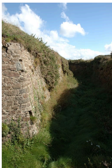
Vue du fossé sec au sud-ouest (état en 2007) Phot. Guillaume Lécueillier IVR53_20072907147NUCA
