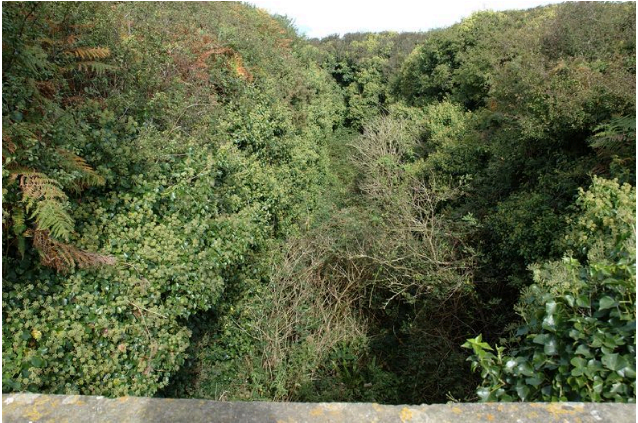
Vue du fossé sec à l'est (état en 2007). Il est envahi par la végétation
