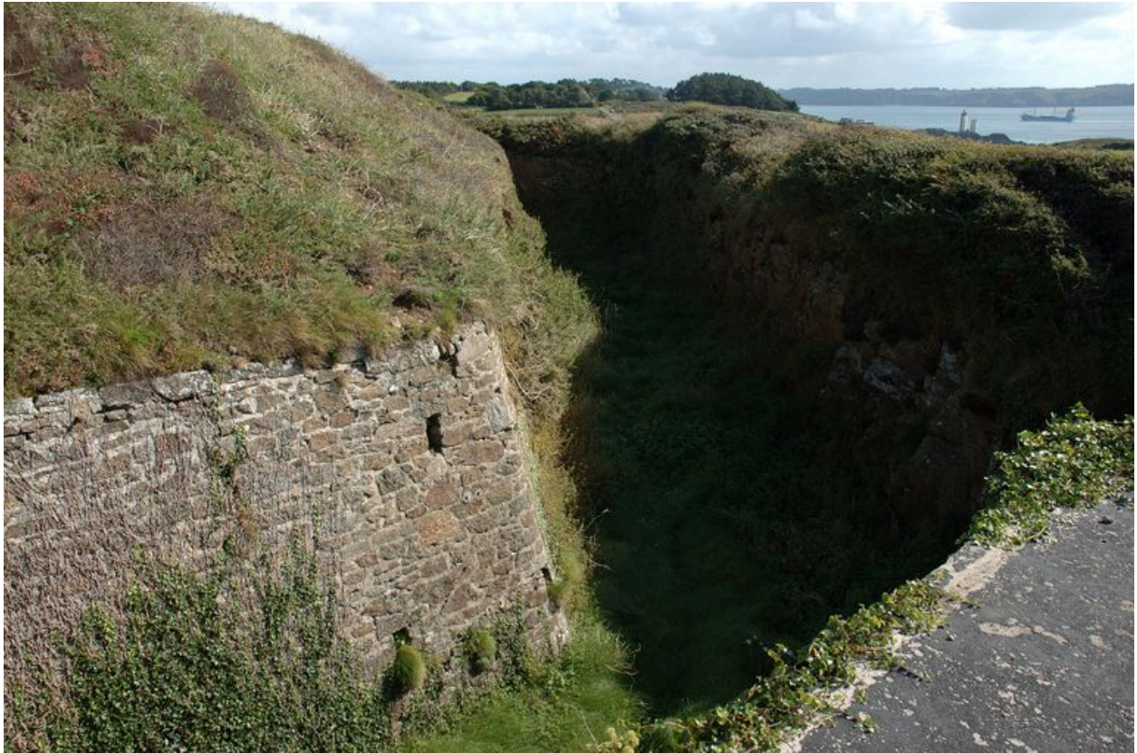
Vue du fossé sec au sud-ouest (état en 2007)
