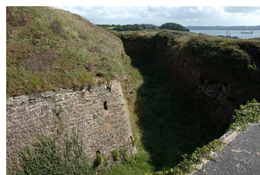
Vue du fossé sec au sud-ouest (état en 2007) Phot. Guillaume Lécueillier IVR53_20072907144NUCA
