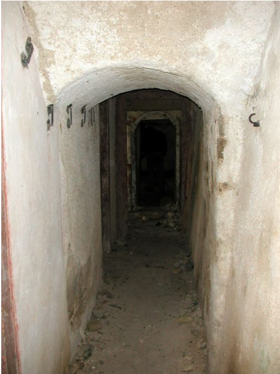
Vue de l'un des couloirs de circulation (état en 2007)
