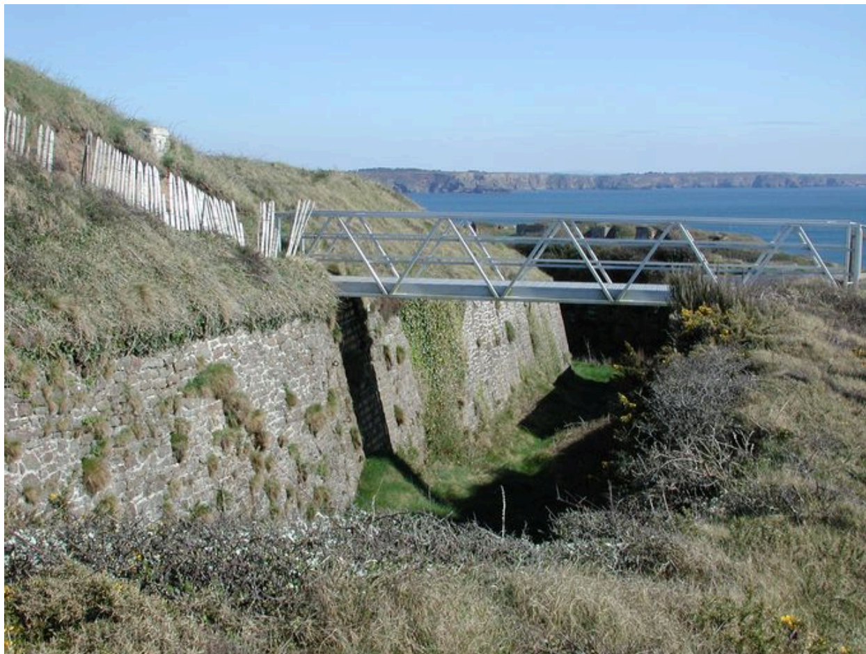
Vue du fossé sec au sud-ouest (état en 2007). La passerelle permet de traverser le réduit
