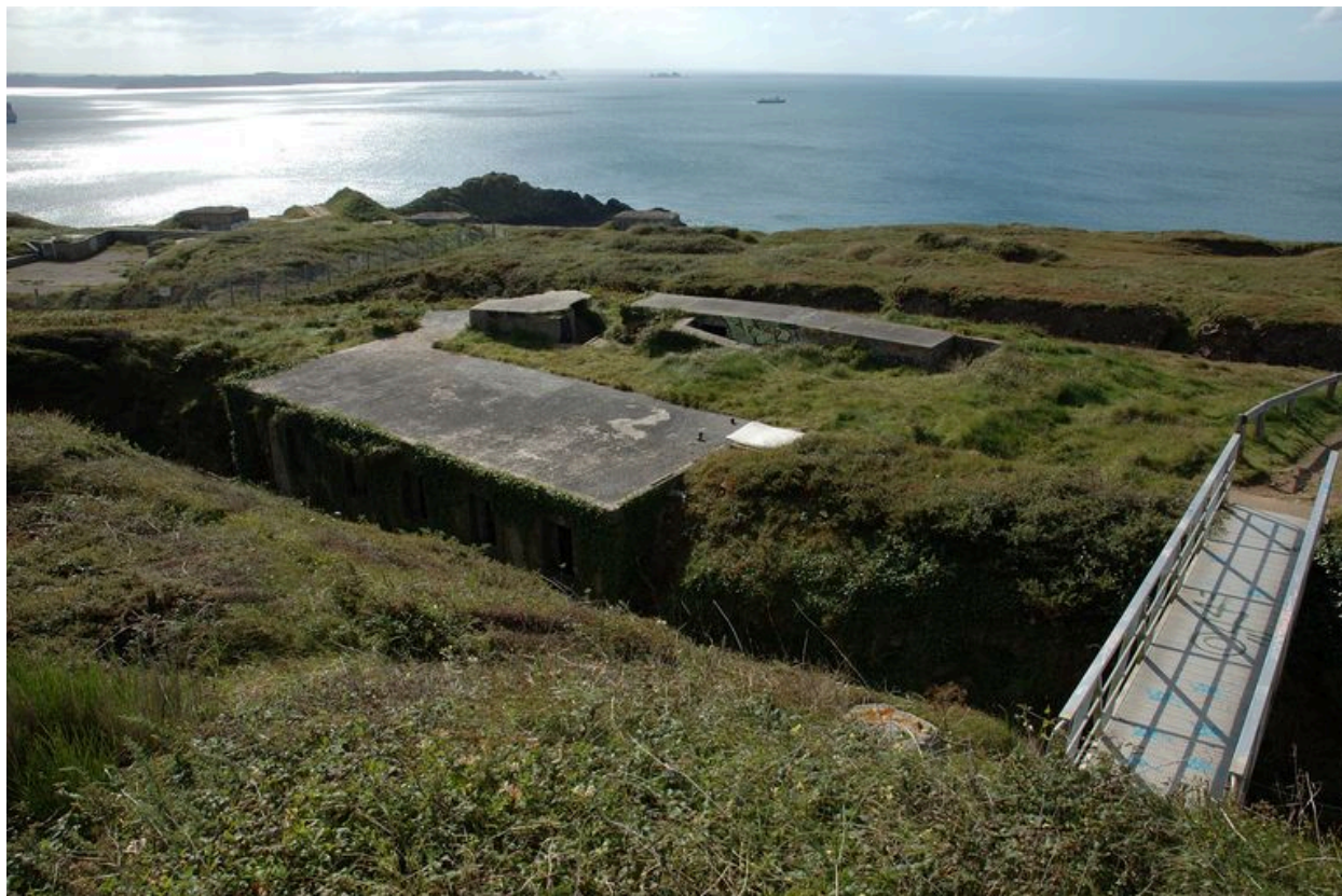
Vue du poste de commandement de groupe de Toulbroc'h implanté dans le fossé sec au sud-ouest (état en 2007). A droite, la passerelle permet de traverser le réduit
