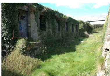
Vue du poste de commandement de groupe de Toulbroc'h implanté dans le fossé sec au sud-ouest (état en 2007) Phot. Guillaume Lécueillier IVR53_20072907151NUCA
