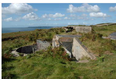
Vue de l'observatoire situé devant le poste de commandement de groupe de Toulbroc'h (état en 2007) Phot. Guillaume Lécueillier IVR53_20072907154NUCA
