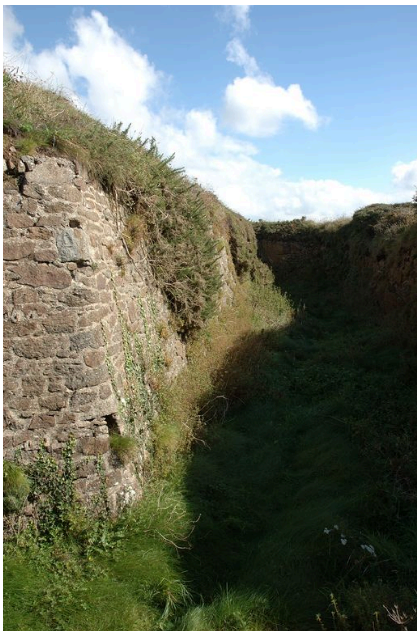
Vue du fossé sec au sud-ouest (état en 2007)
