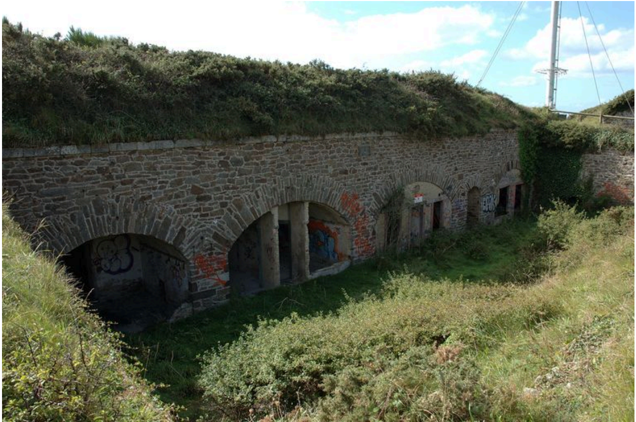
Vue de la cour et du casernement (état en 2007)
