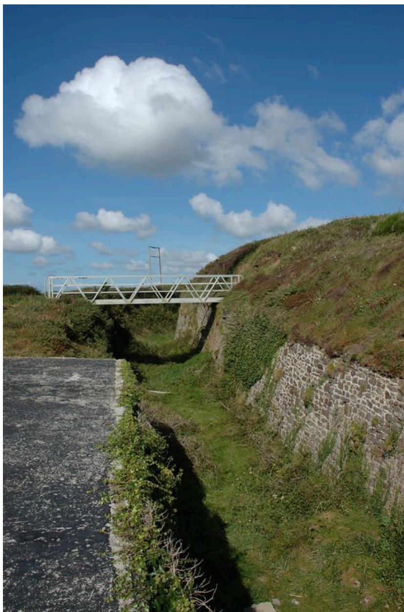
Vue du fossé sec au sud-ouest (état en 2007). A gauche, la dalle de couverture du poste de commandement de groupe de Toulbroc'h
