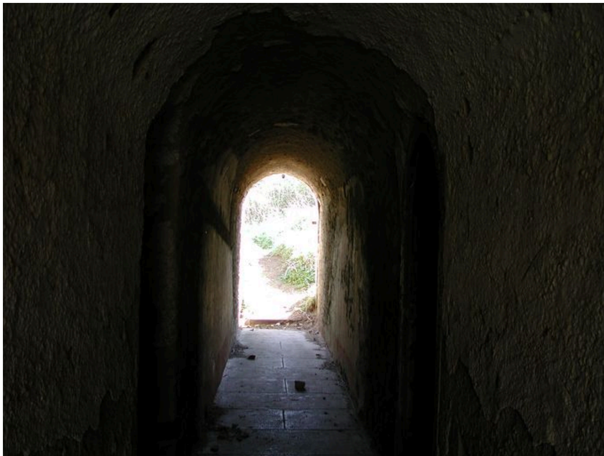
Vue de l'un des couloirs de circulation (état en 2007)
