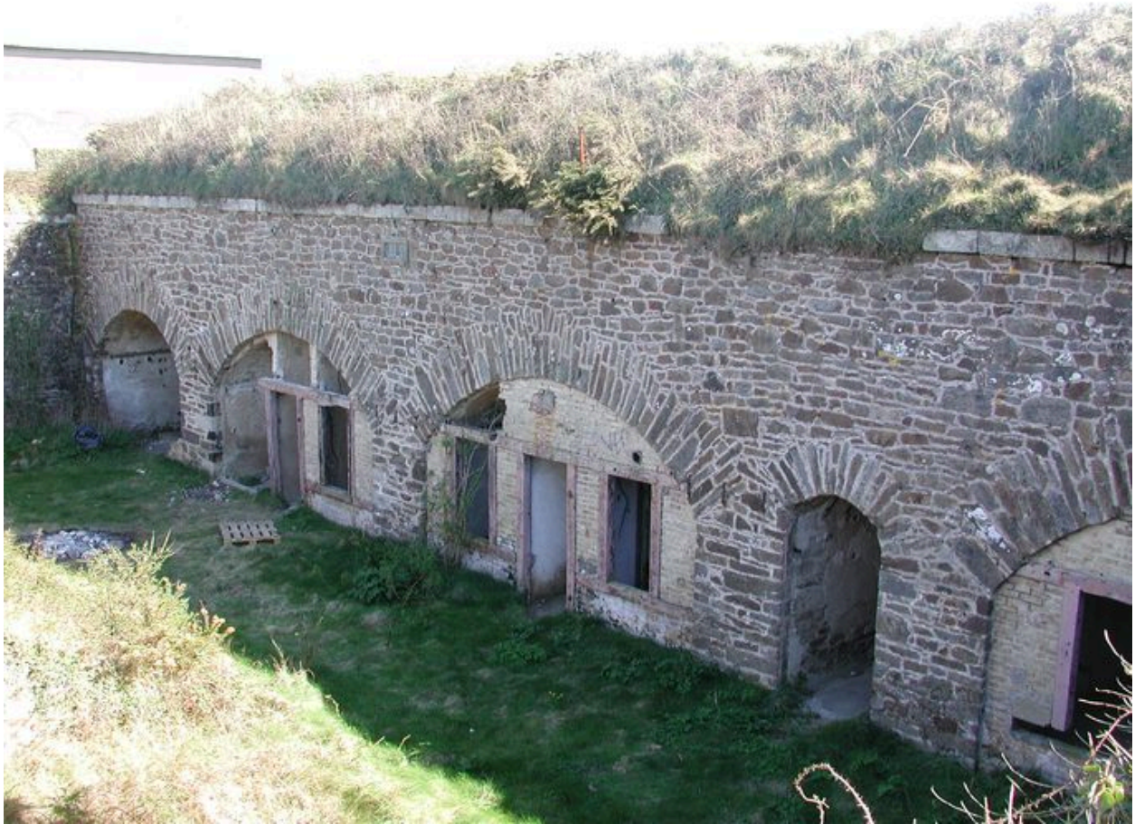
Vue de la cour et des du casernement (état en 2007). Le réduit est daté par millésime de 1884
