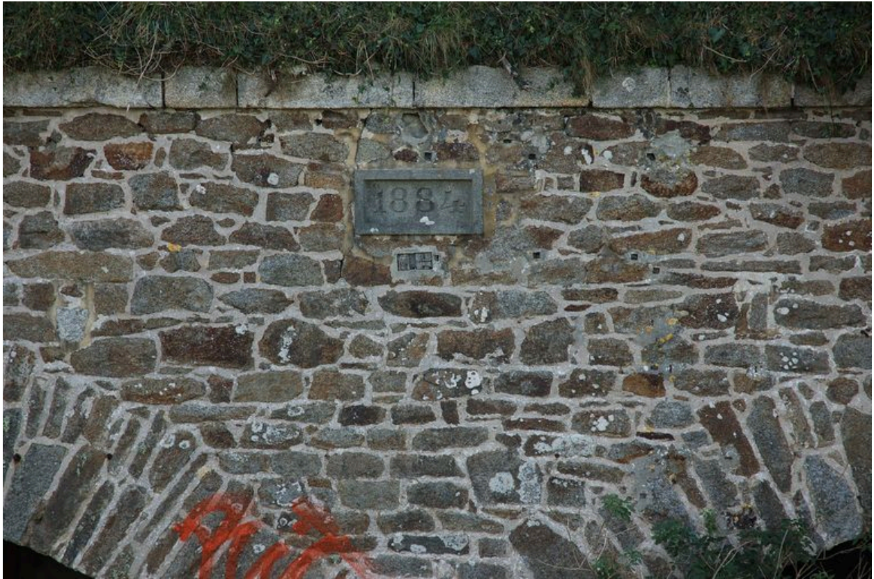
Vue du millésime 1884 gravée sur une pierre de taille de kersanton du casernement (état en 2007)
