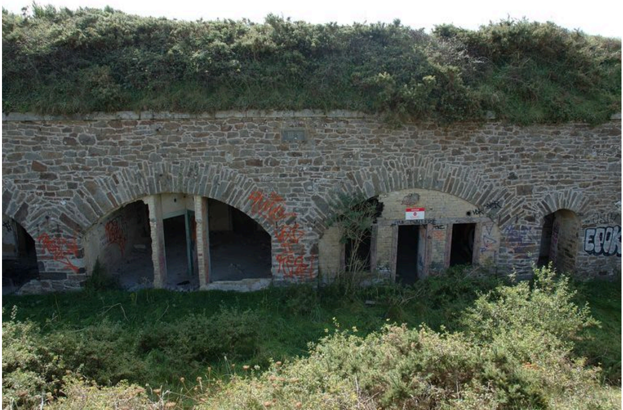
Vue de la cour et du casernement (état en 2007). Le réduit est daté par millésime de 1884
