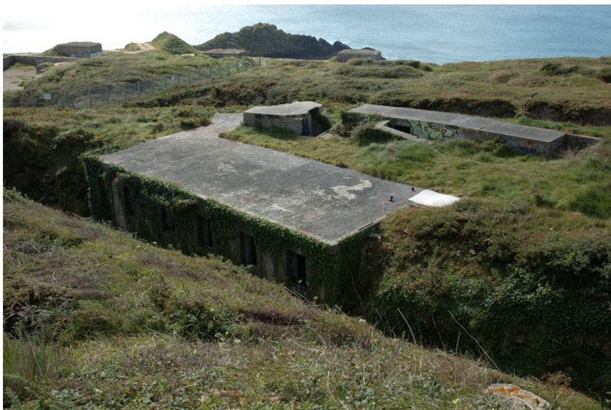
Vue du poste de commandement de groupe de Toulbroc'h implanté dans le fossé sec au sud-ouest (état en 2007)
