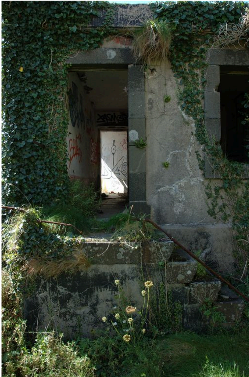
Vue du poste de commandement de groupe de Toulbroc'h implanté dans le fossé sec au sud-ouest (état en 2007)
