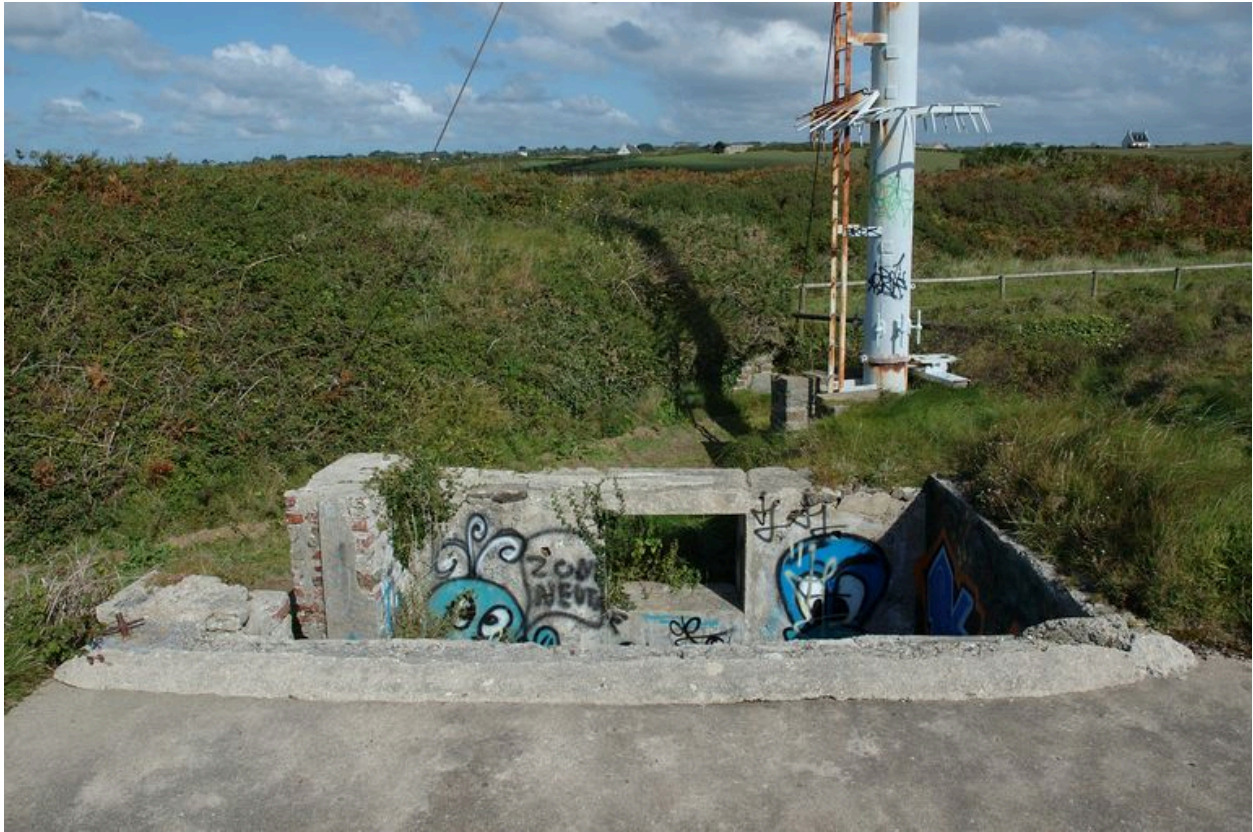
Vue de l'observatoire bétonné situé au sommet du réduit (état en 2007)
