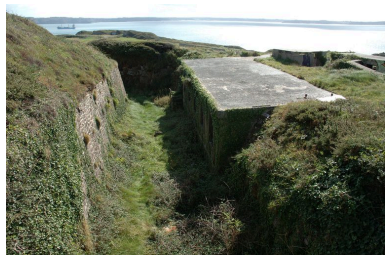
Vue du poste de commandement de groupe de Toulbroc'h implanté dans le fossé sec au sud-ouest (état en 2007) Phot. Guillaume Lécueillier IVR53_20072907150NUCA
