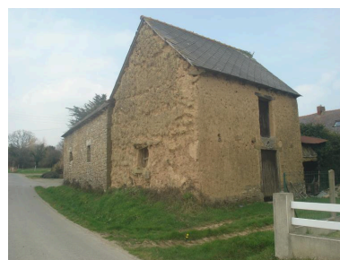
Maison en bauge, village de l'Hermitage Phot. Fadila Hamelin IVR53_20212265725NUCA
