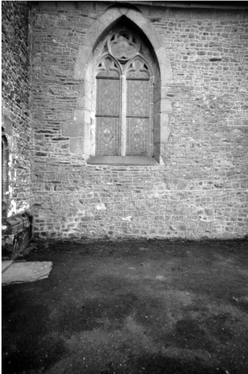
Façade Nord, nef, détail fenêtre.
