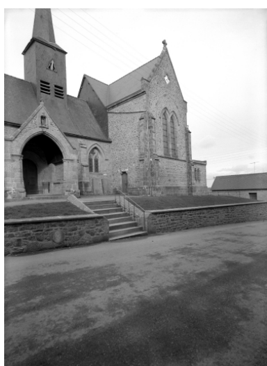
Elévation Sud, partie Est : vue générale
