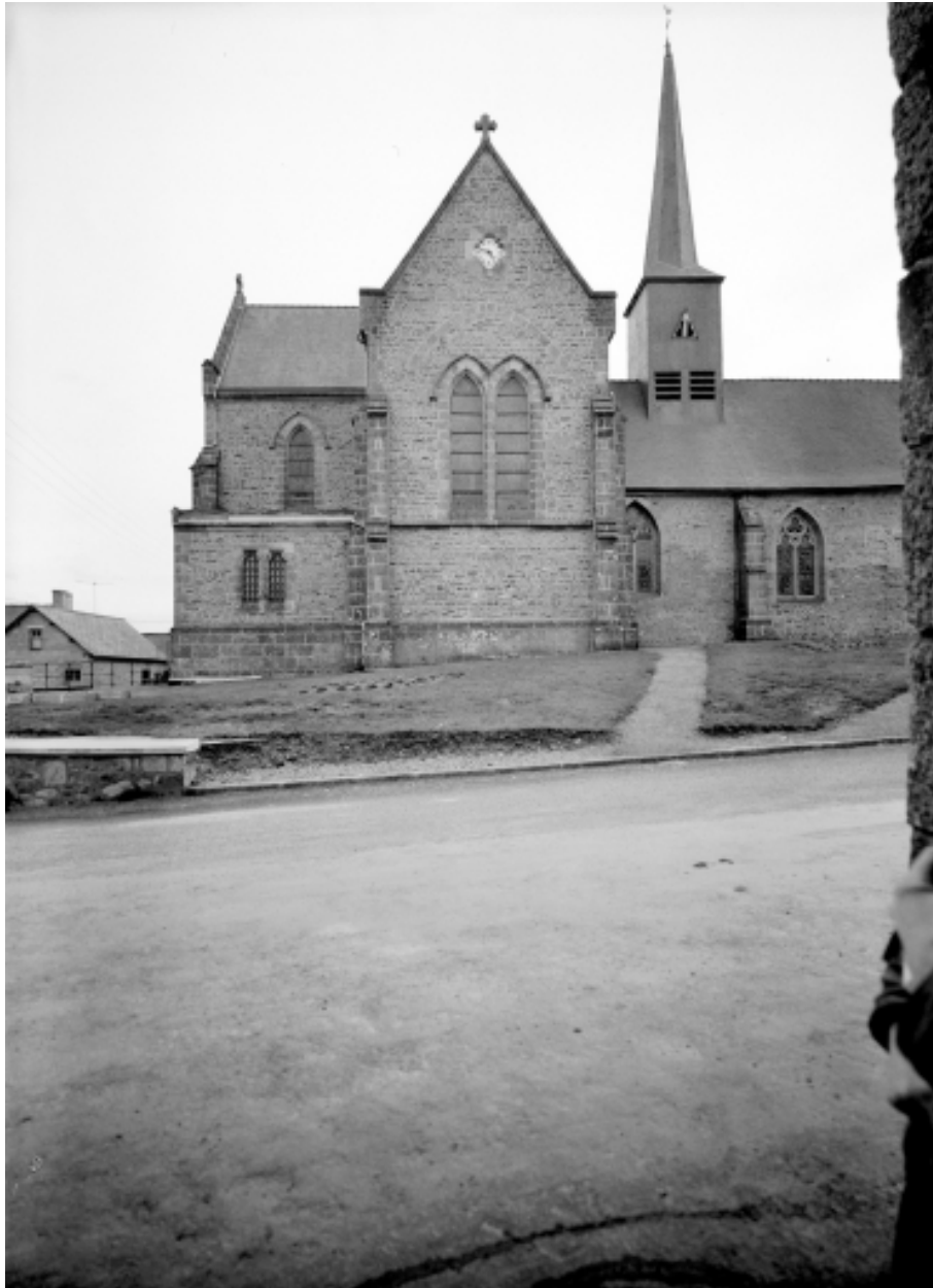
Elévation Nord, partie Est : vue générale
