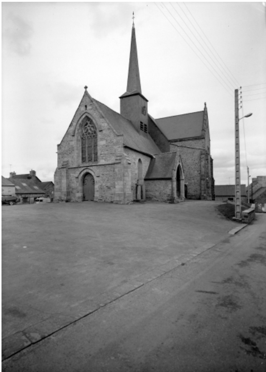
Elévation Sud-Ouest : vue générale
