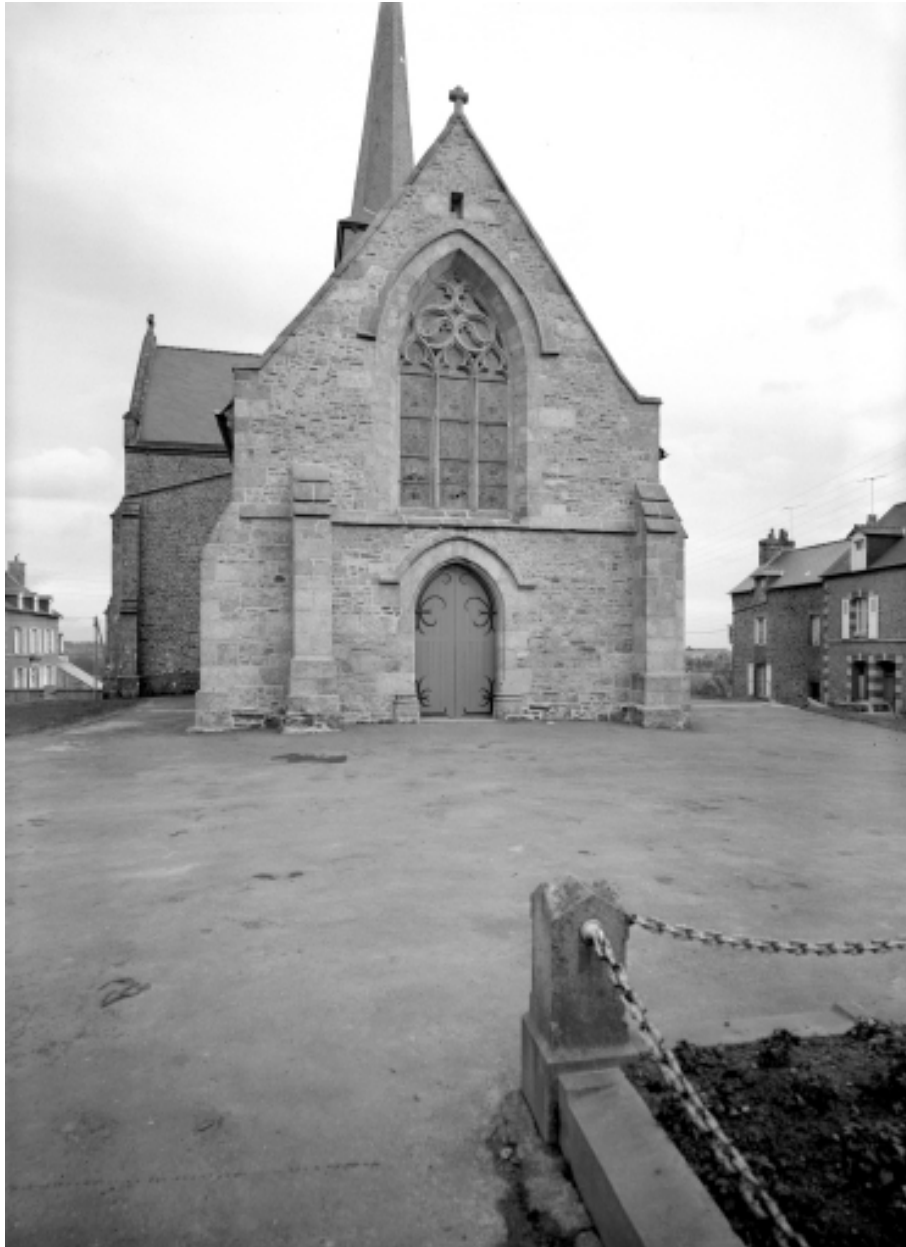
Elévation Ouest : vue générale
