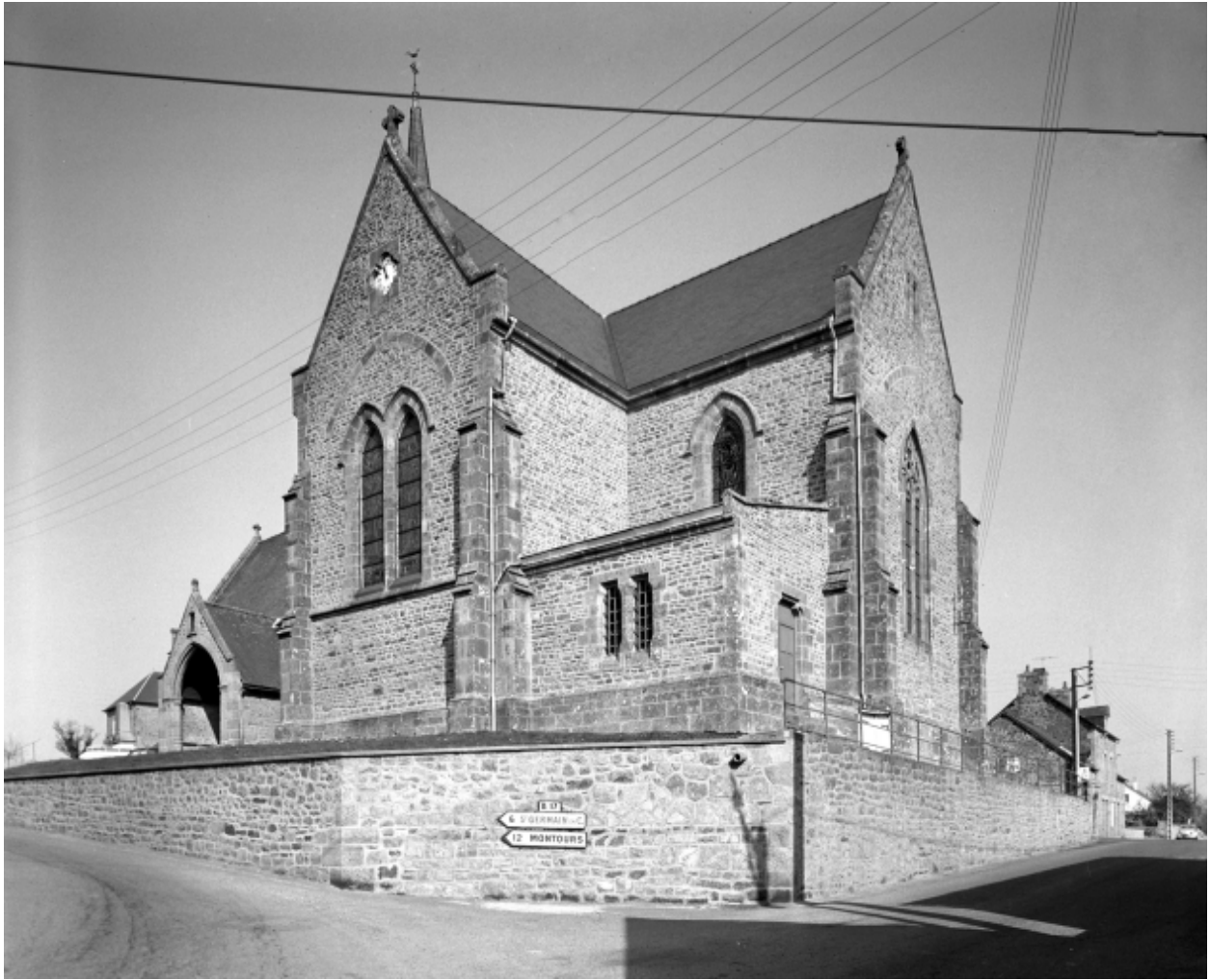
Elévation Sud-Est : vue générale.
