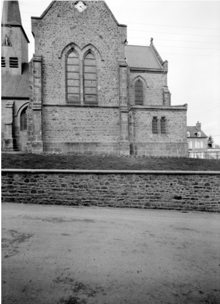
Elévation Est : vue générale
