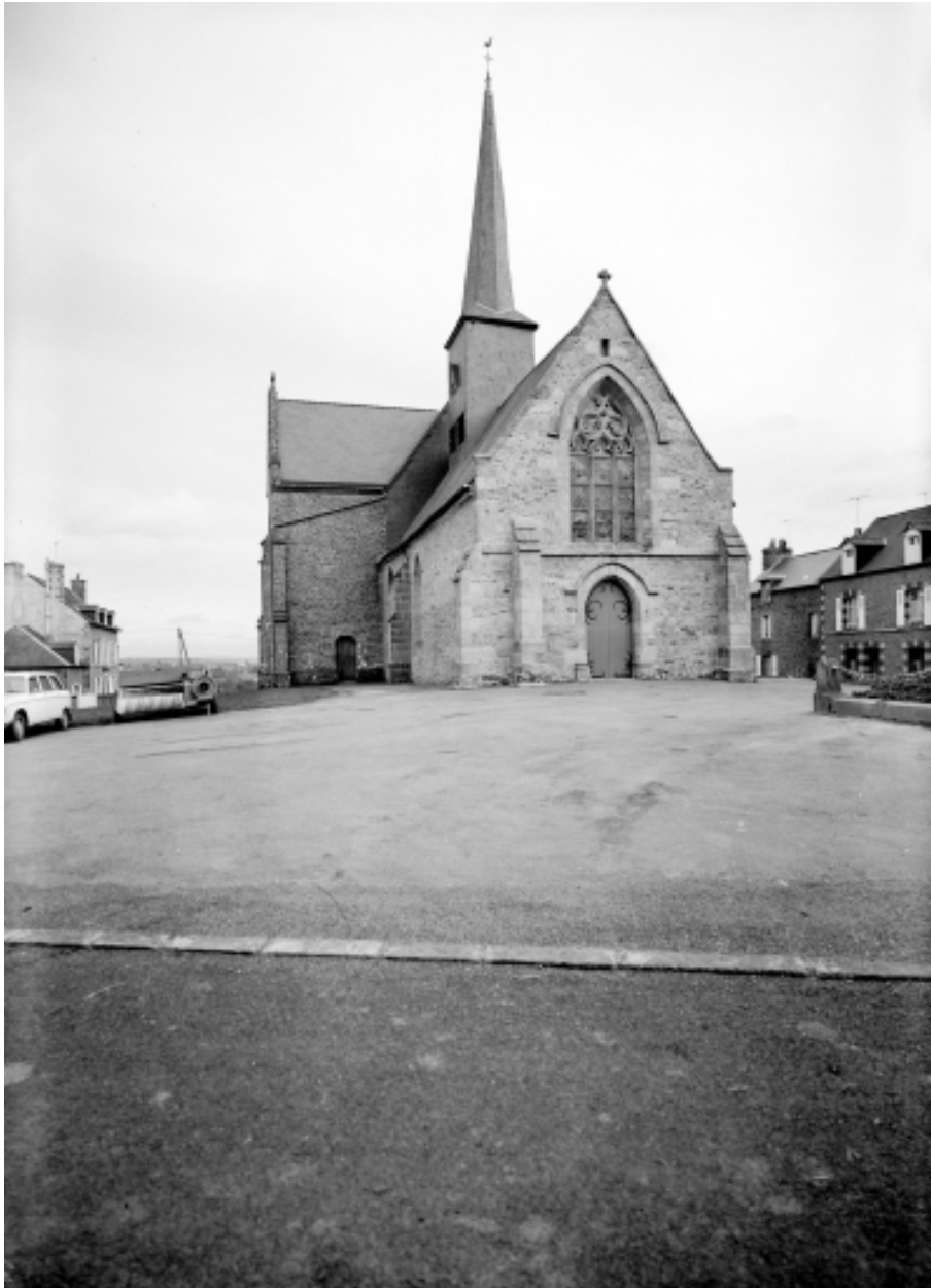
Elévation Ouest : vue générale
