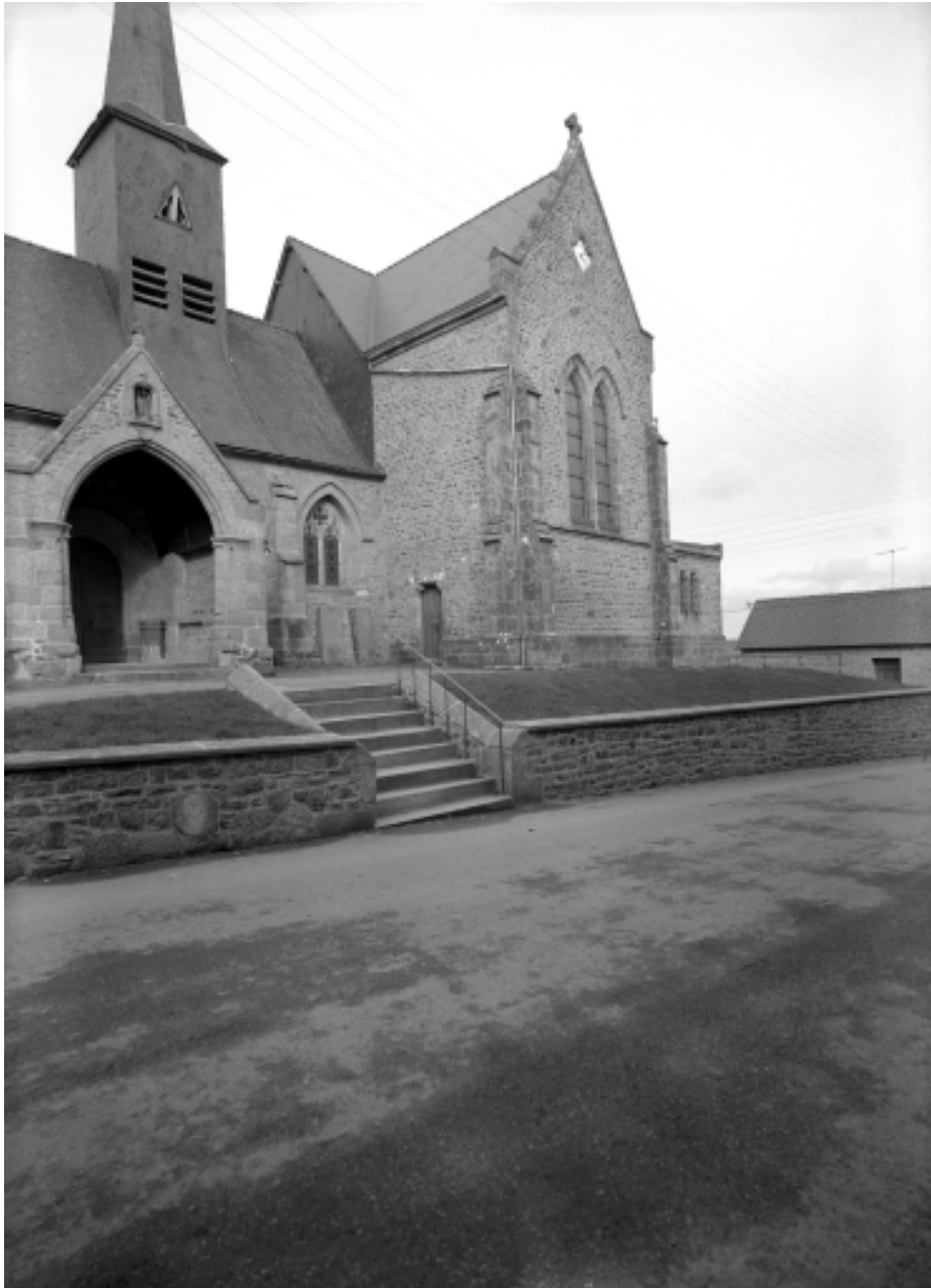
Elévation Sud, partie Est : vue générale
