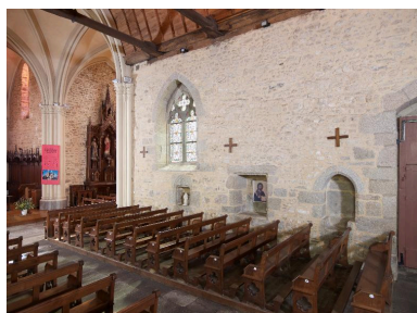
Vue intérieure de l'église Phot. Bernard Bègne IVR53_20143500034NUCA
