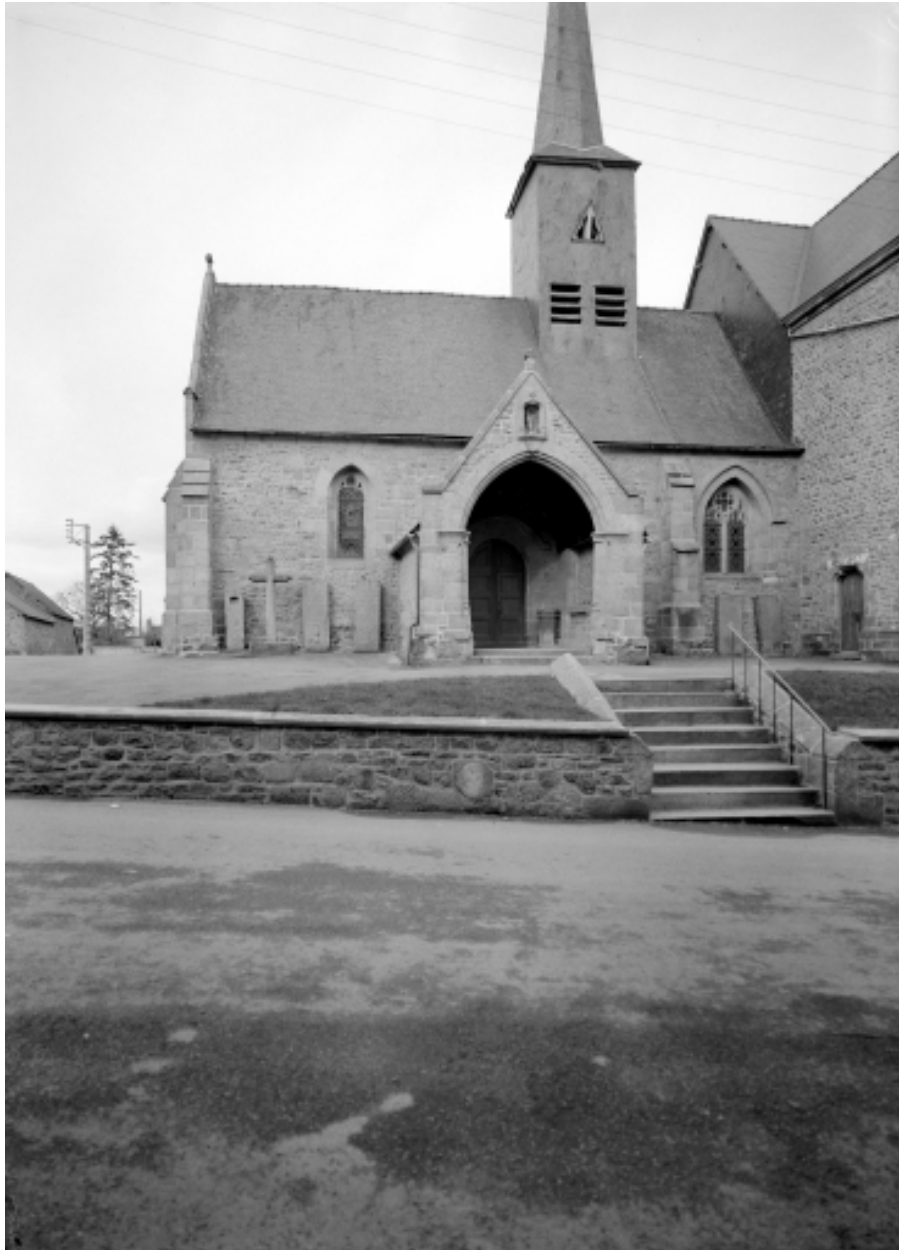
Elévation Sud, partie Ouest: vue générale
