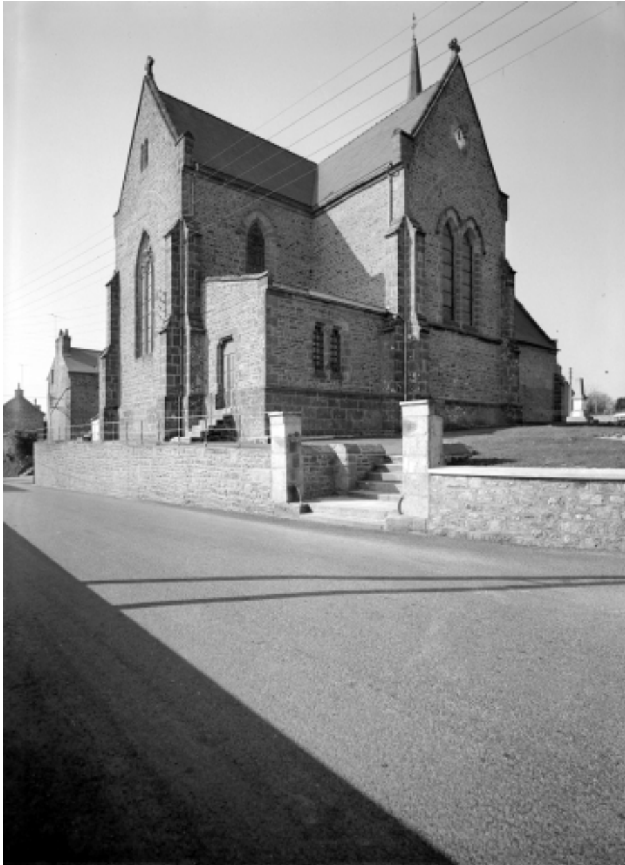
Elévation Nord-Est : vue générale.
