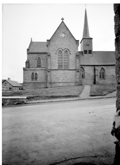
Elévation Nord, partie Est : vue générale Phot. François Dagorn IVR53_19733500126V
