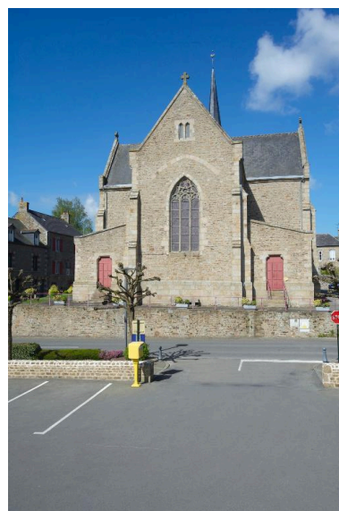
Le chevet de l'église Phot. Norbert Lambart IVR53_20143500555NUCA
