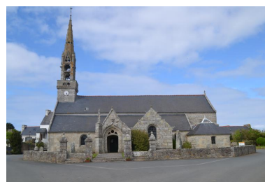
Vue générale de l'église prise du nord. (2018) Phot. Fabien Serre IVR53_20182905553NUCA
