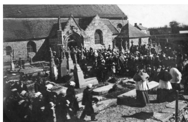
Vue de l'église prise du sud, cimetière. Etat au début du 20e siècle. (Coll. particulière). Phot. Auteur inconnu IVR53_20182906214PB
