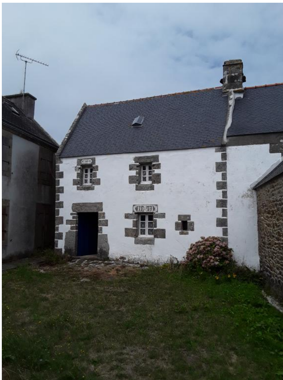
Maison 1 datée 1818, élévation antérieure. (2018)
