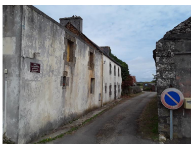
Venelle du presbytère, dite hent bihan, entrée. Phot. Fabien Serre IVR53_20182906227NUCA
