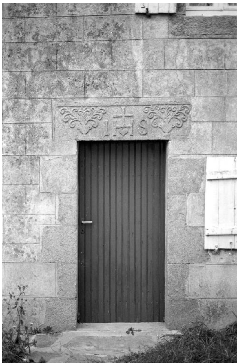
Maison 3, détail de la porte d'entrée. (1978)
