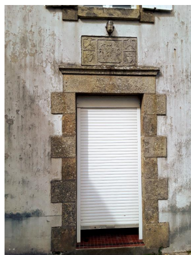
Maison 5, détail du linteau de la porte d'entrée. (2018) Phot. Fabien Serre IVR53_20182906224NUCA
