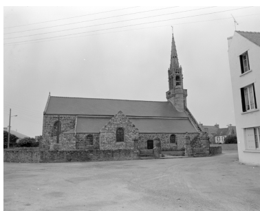
Vue générale de l'église prise du nord. (1979) Phot. Norbert Lambart IVR53_19792901730X
