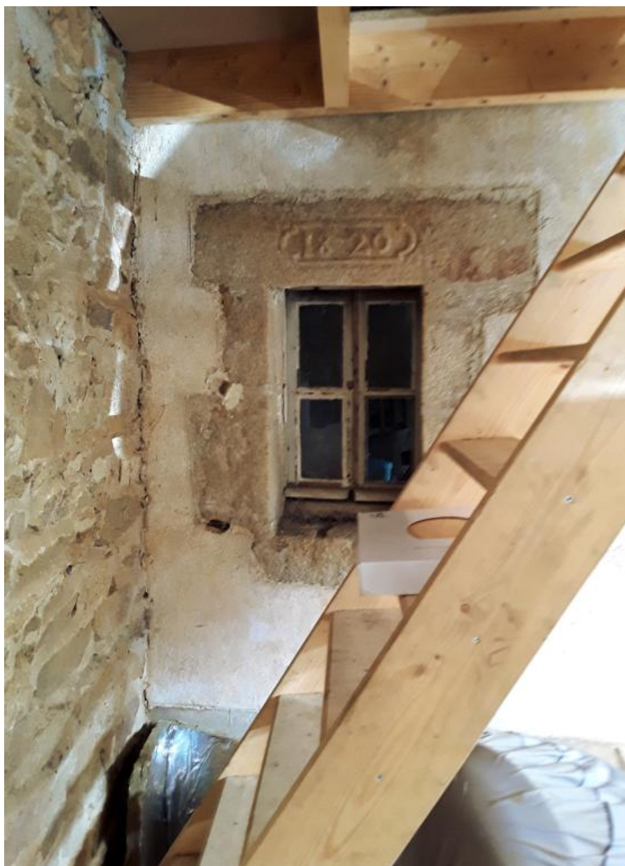
Maison 2 (mitoyenne à la maison 1), détail de la fenêtre.
