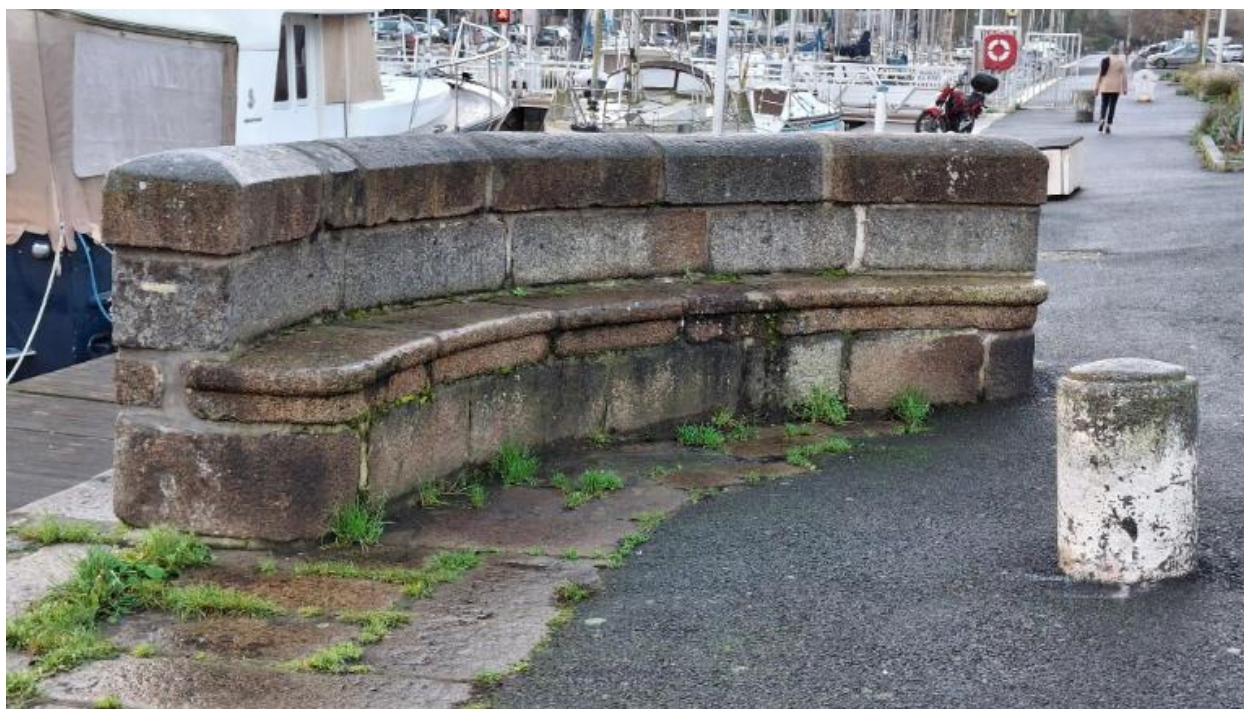
Vue rapprochée du banc et de la maçonnerie
