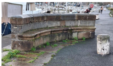
Vue rapprochée du banc et de la maçonnerie Phot. Erwana L'Haridon IVR53_20262210350NUCA
