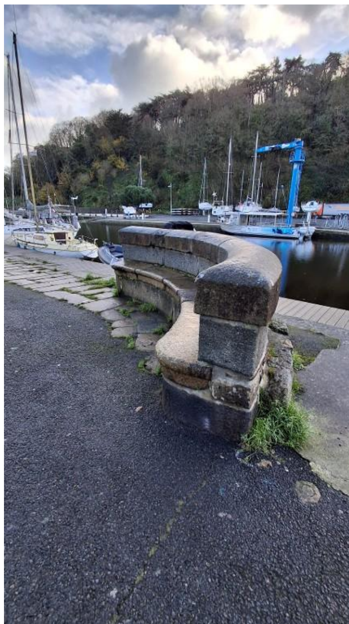
Vue rapprochée de la mise en oeuvre de la maçonnerie
