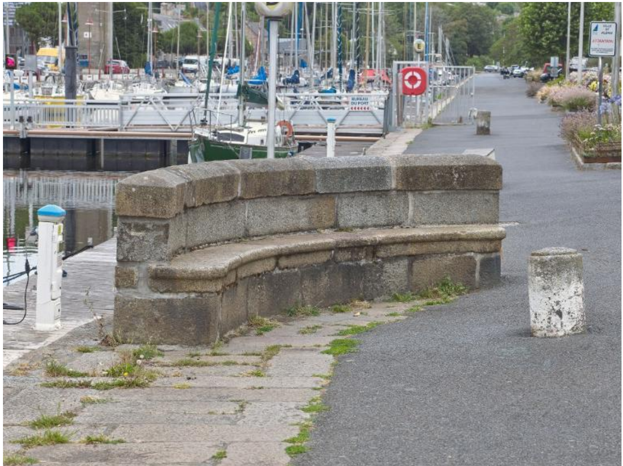
Banc du milieu du 18e siècle contemporain des aménagements portuaires
