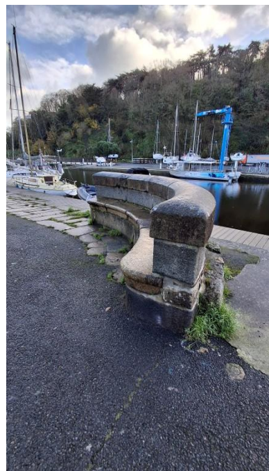
Vue rapprochée de la mise en oeuvre de la maçonnerie
