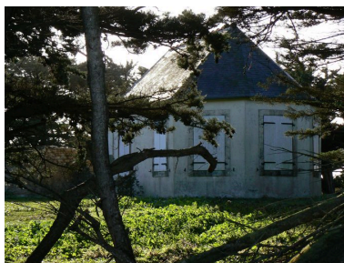
Vue latérale de l'ancien sémaphore du Toulinguet Phot. Julien Amghar IVR53_20072908583NUCA
