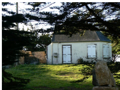
Vue générale de l'ancien sémaphore du Toulinguet Phot. Julien Amghar IVR53_20072908582NUCA
