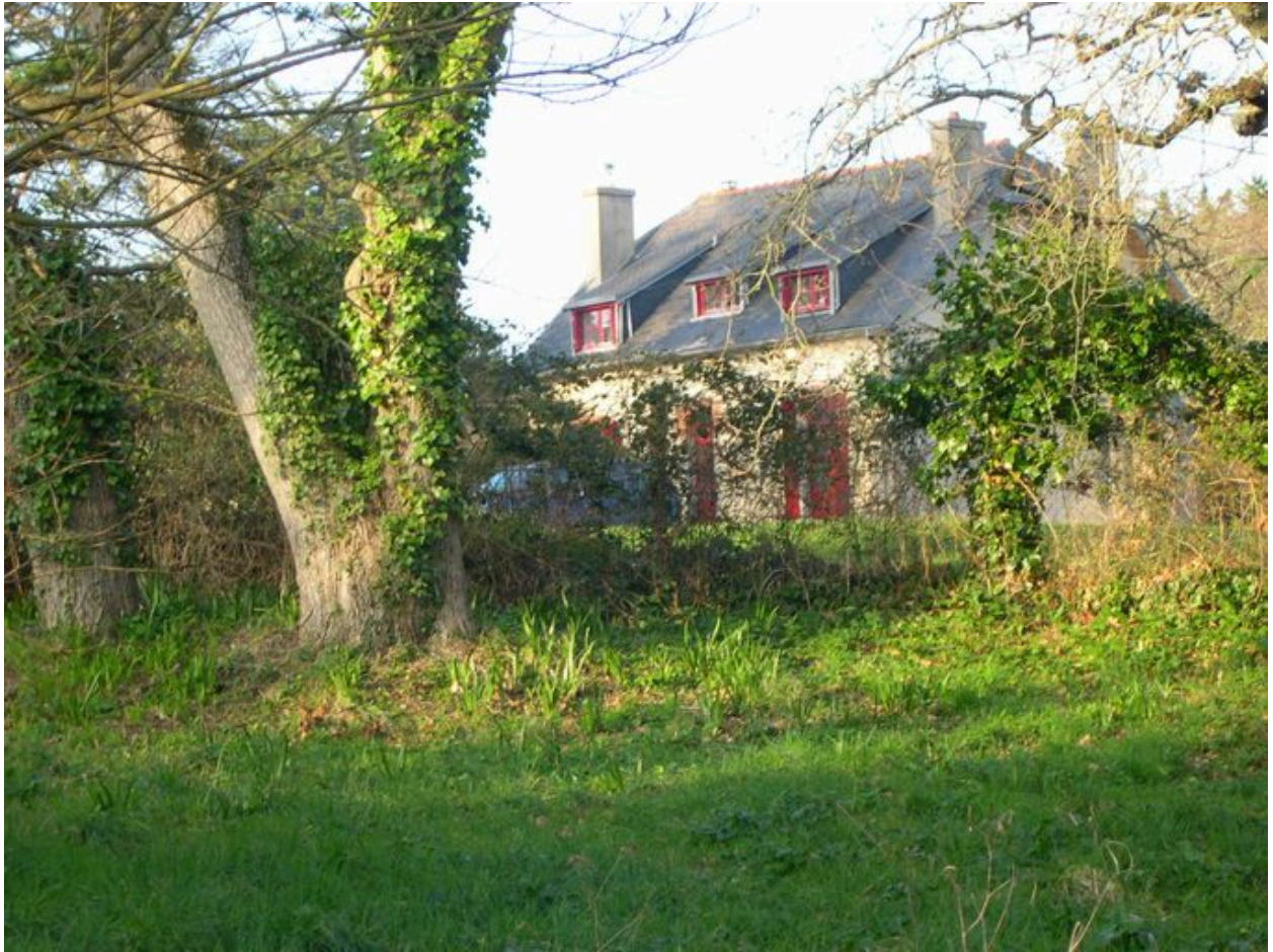
Vue arrière de la Villa Le Joncour
