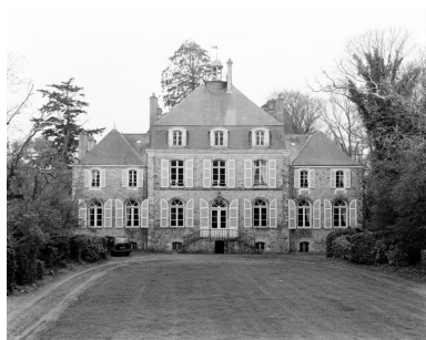
Elévation nord, vue générale. Phot. Guy Artur, Phot. Norbert Lambart IVR53_19935600848X
