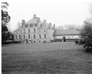
Vue générale sud-est. Phot. Guy Artur, Phot. Norbert Lambart IVR53_19935600844X
