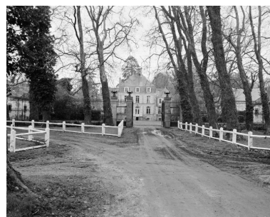
Vue de situation prise du nord. Phot. Guy Artur, Phot. Norbert Lambart IVR53_19935600854X
