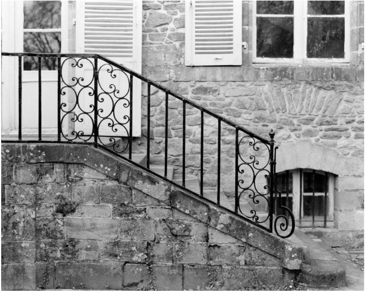
Elévation nord, pavillon central, détail rampe.
