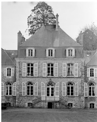
Elévation nord, pavillon central, vue générale. Phot. Guy Artur, Phot. Norbert Lambart IVR53_19935600853X
