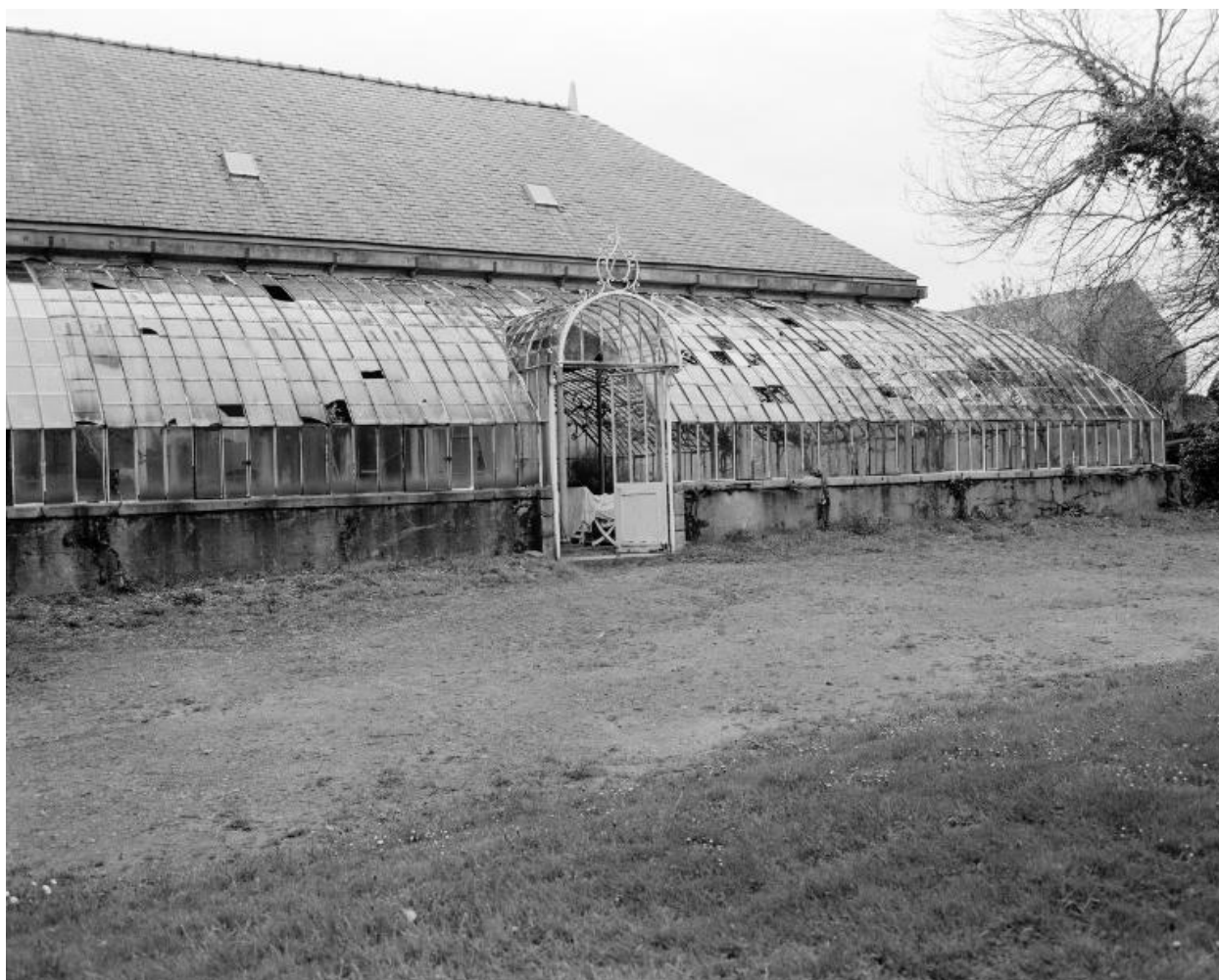
Serre, vue générale sud.
