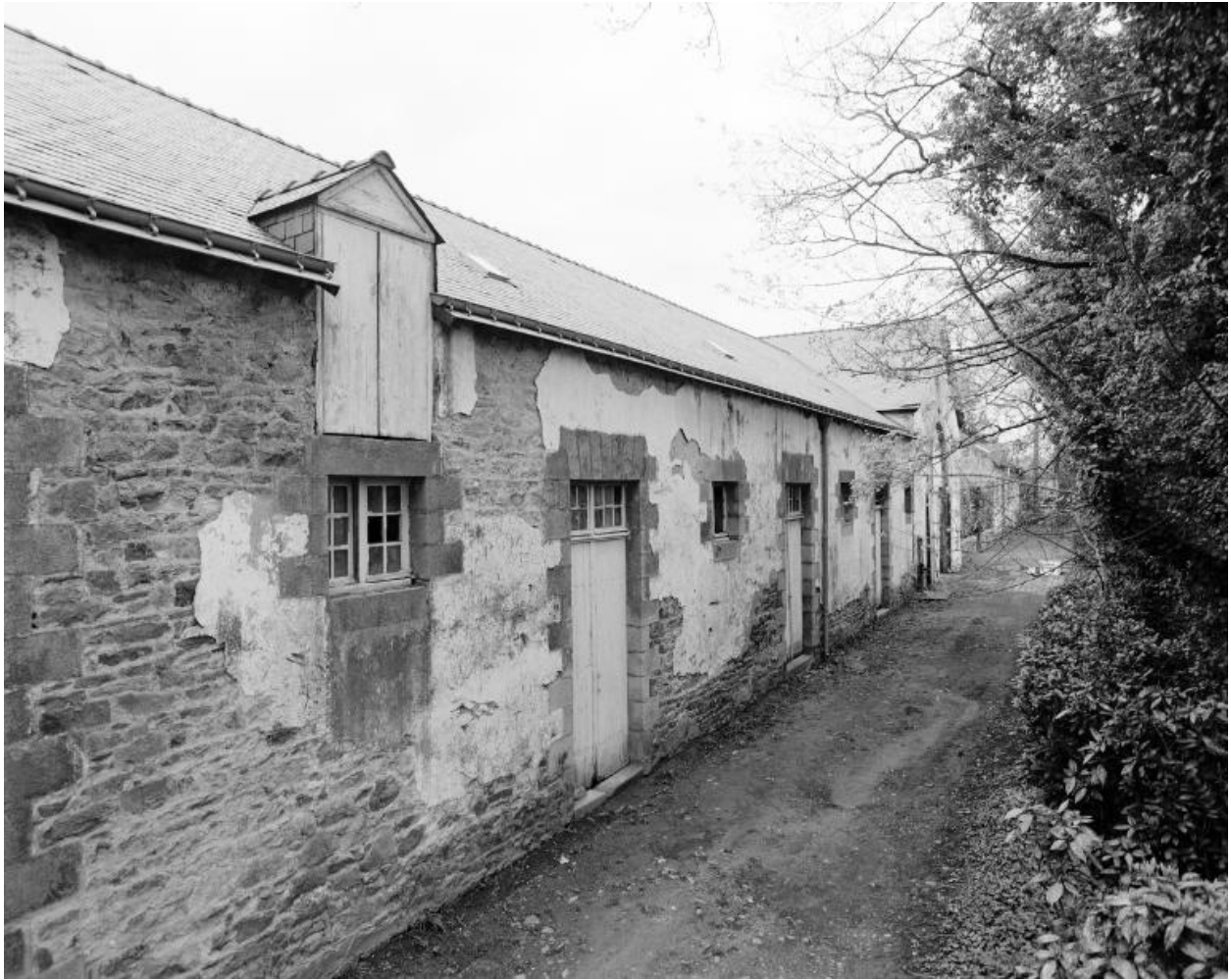
Cour nord, communs ouest, élévation est.
