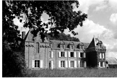
Vue générale sud ouest Phot. Groussard IVR53_19675601721Z
