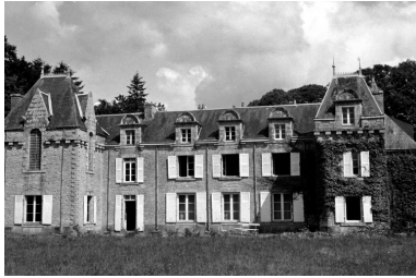
Vue générale sud Phot. Groussard IVR53_19675601720Z
