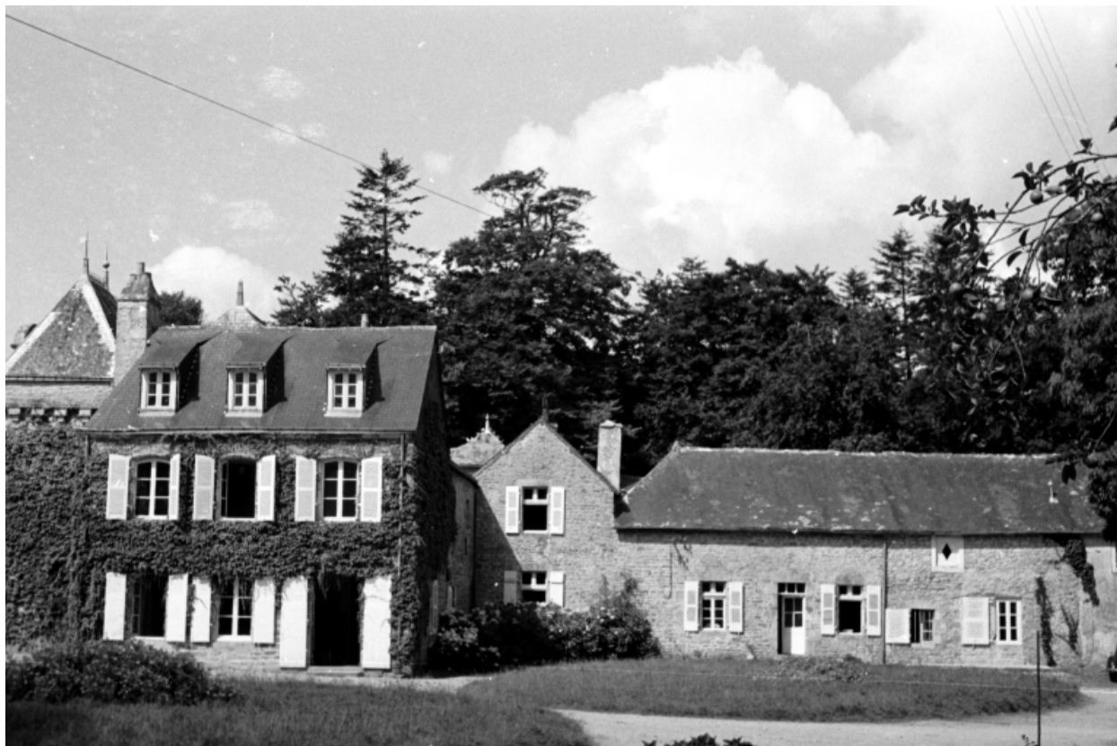
Vue générale est
