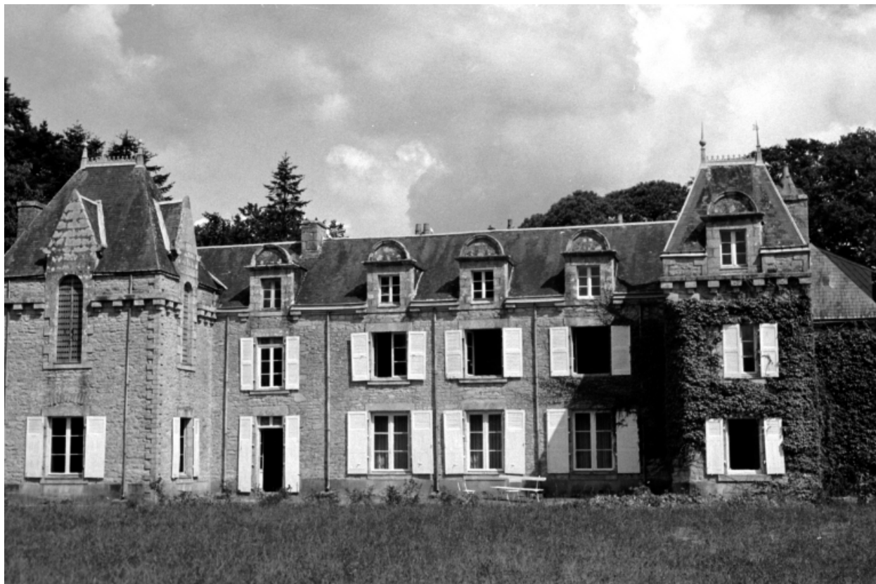
Vue générale sud
