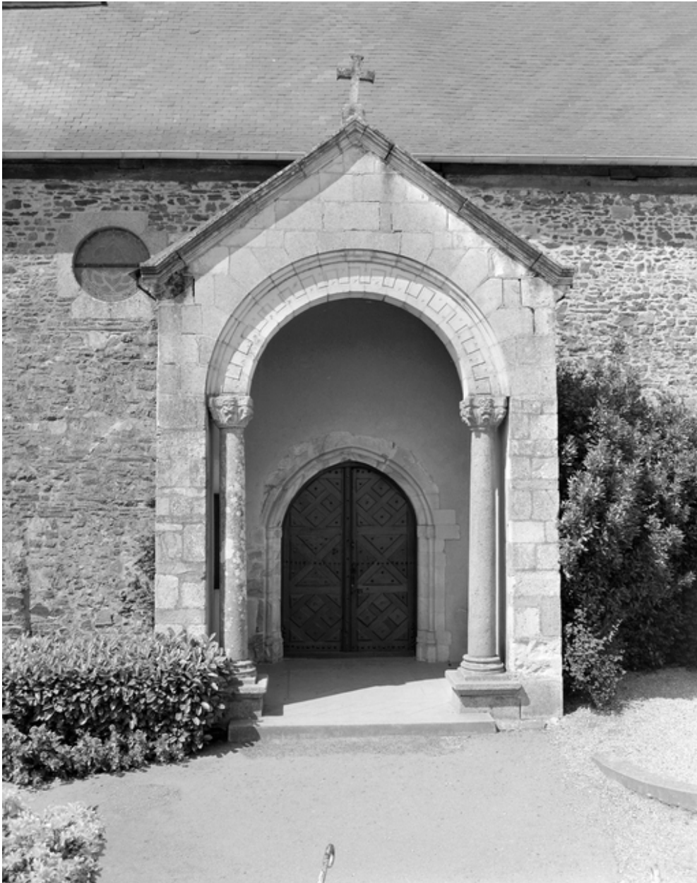
Elévation Sud, porche : vue générale
