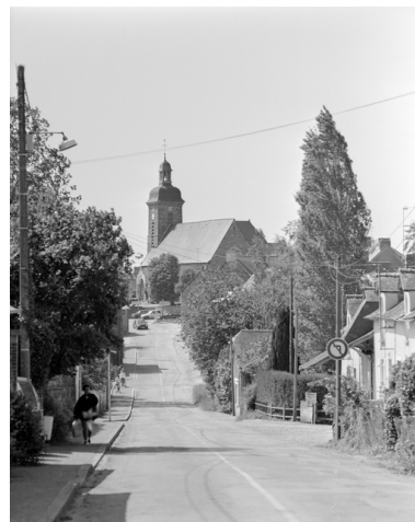
Elévation Sud-Ouest : vue générale Phot. Guy Artur, Phot. Norbert Lambart IVR53_19943500937X
