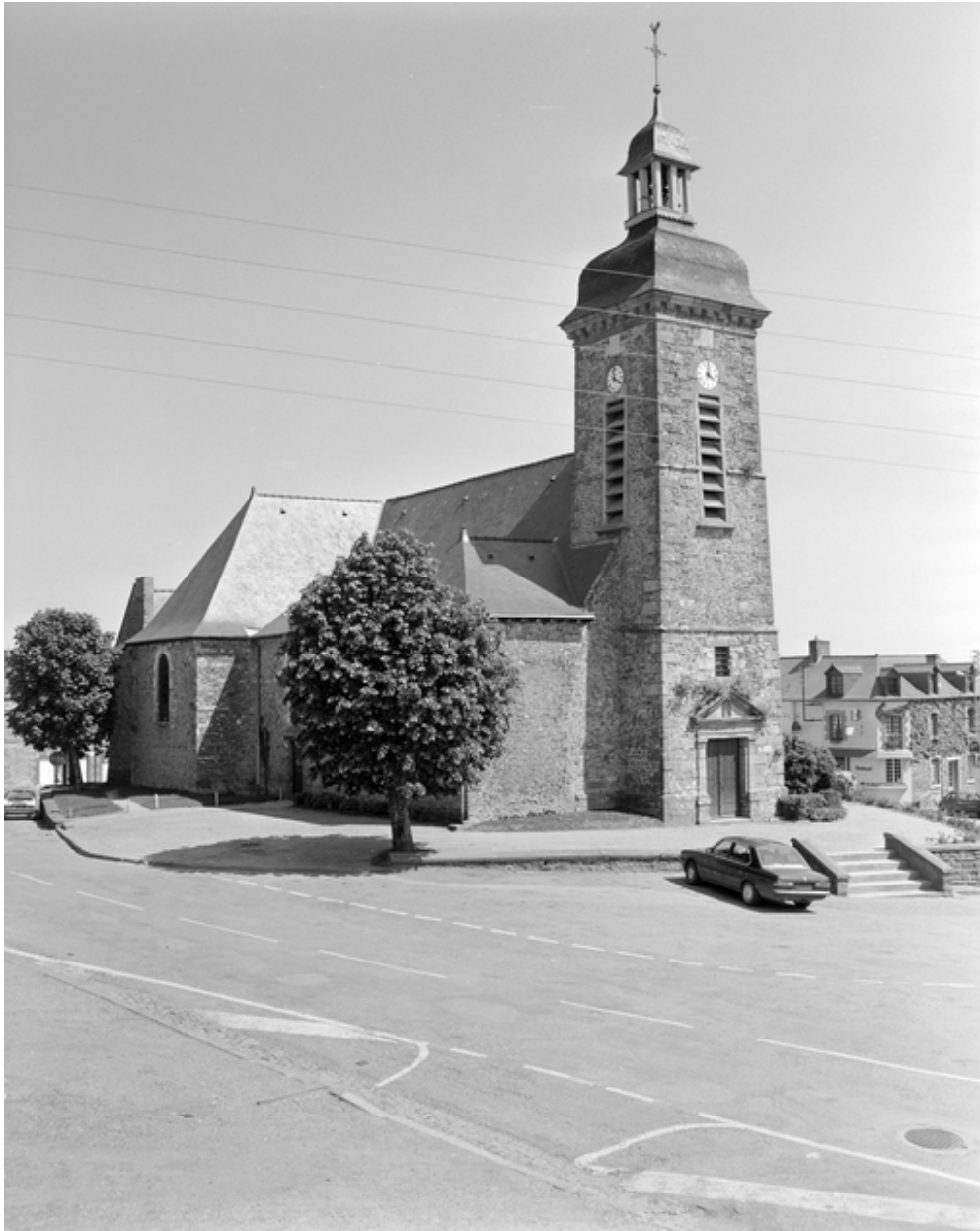
Elévation Nord-Ouest : vue générale
