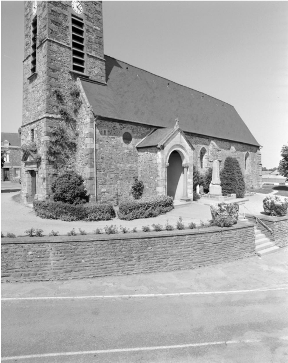
Elévation Sud-Ouest : vue générale
