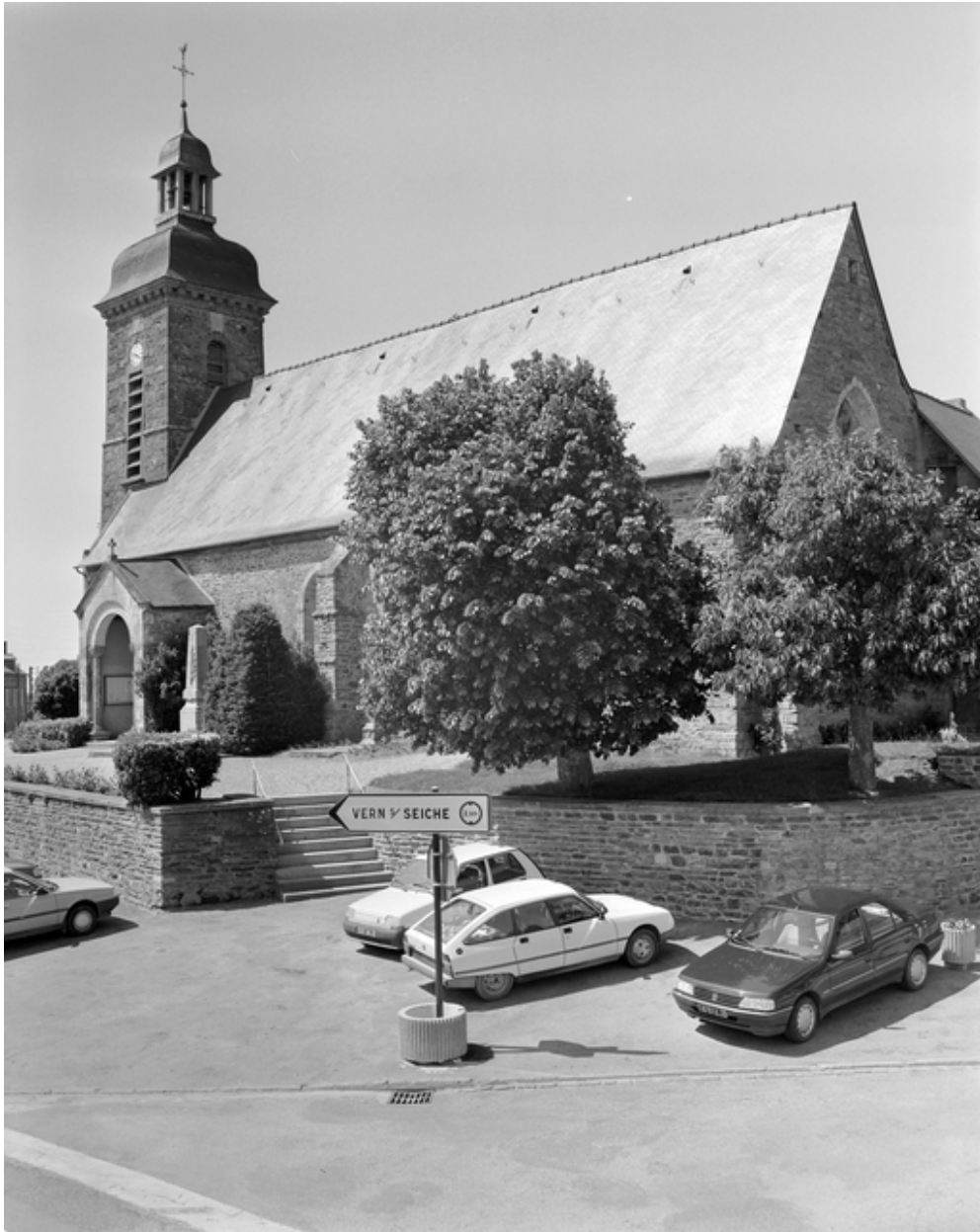
Elévation Sud : vue générale
