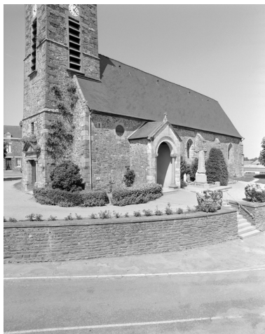
Elévation Sud-Ouest : vue générale Phot. Guy Artur, Phot. Norbert Lambart IVR53_19943500936X
