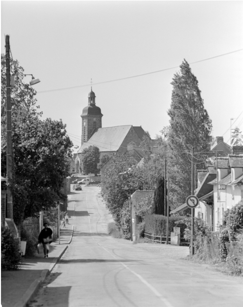
Elévation Sud-Ouest : vue générale
