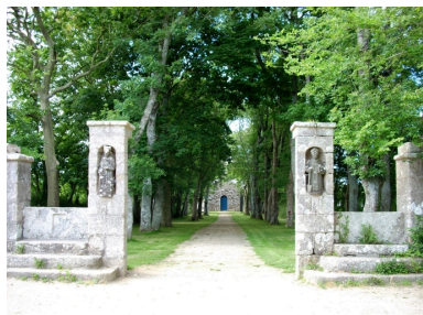
Locmaria-Plouzané, chapelle Saint-Sébastien : vue de situation depuis l'ouest Phot. Gwénaél Fauchille IVR53_20082906253NUCA
