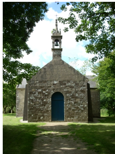
Locmaria-Plouzané, chapelle Saint-Sébastien : élévation ouest Phot. Gwénaél Fauchille IVR53_20082906255NUCA
