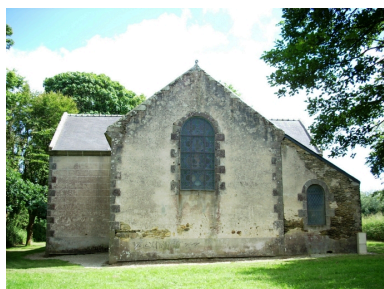
Locmaria-Plouzané, chapelle Saint-Sébastien : élévation est Phot. Gwénaél Fauchille IVR53_20082906256NUCA
