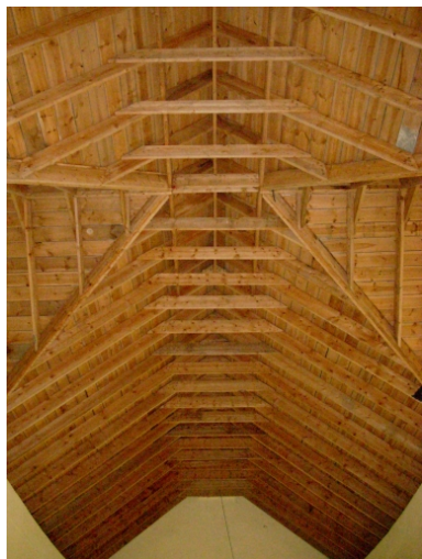
Locmaria-Plouzané, chapelle Saint-Sébastien : détail charpente en bois apparente Phot. Gwénaél Fauchille IVR53_20082906259NUCA
