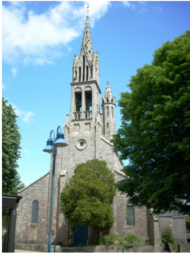
Eglise paroissiale Sainte-Claire de Penhars : vue générale ouest Phot. Gwénaél Fauchille IVR53_20082906404NUCA
