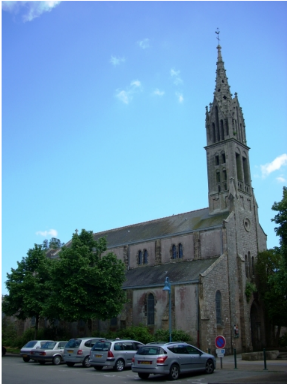
Eglise paroissiale Sainte-Claire de Penhars : vue générale nord-ouest
