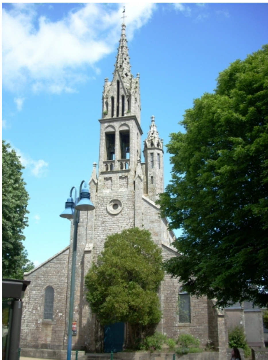
Eglise paroissiale Sainte-Claire de Penhars : vue générale ouest
