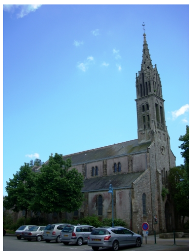
Eglise paroissiale Sainte-Claire de Penhars : vue générale nord-ouest Phot. Gwénaél Fauchille IVR53_20082906401NUCA
