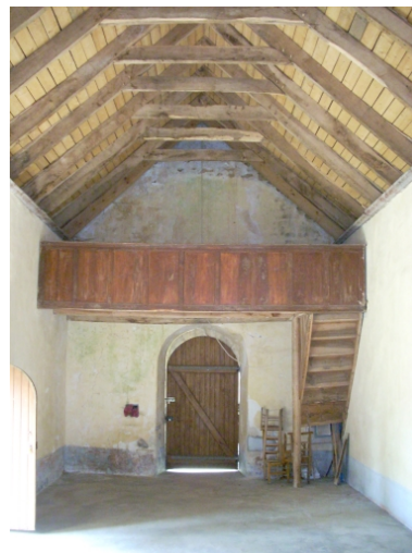
Saint-Evarzec, chapelle Sainte-Véronique : vue axiale ouest Phot. Gwénaél Fauchille IVR53_20082906737NUCA
