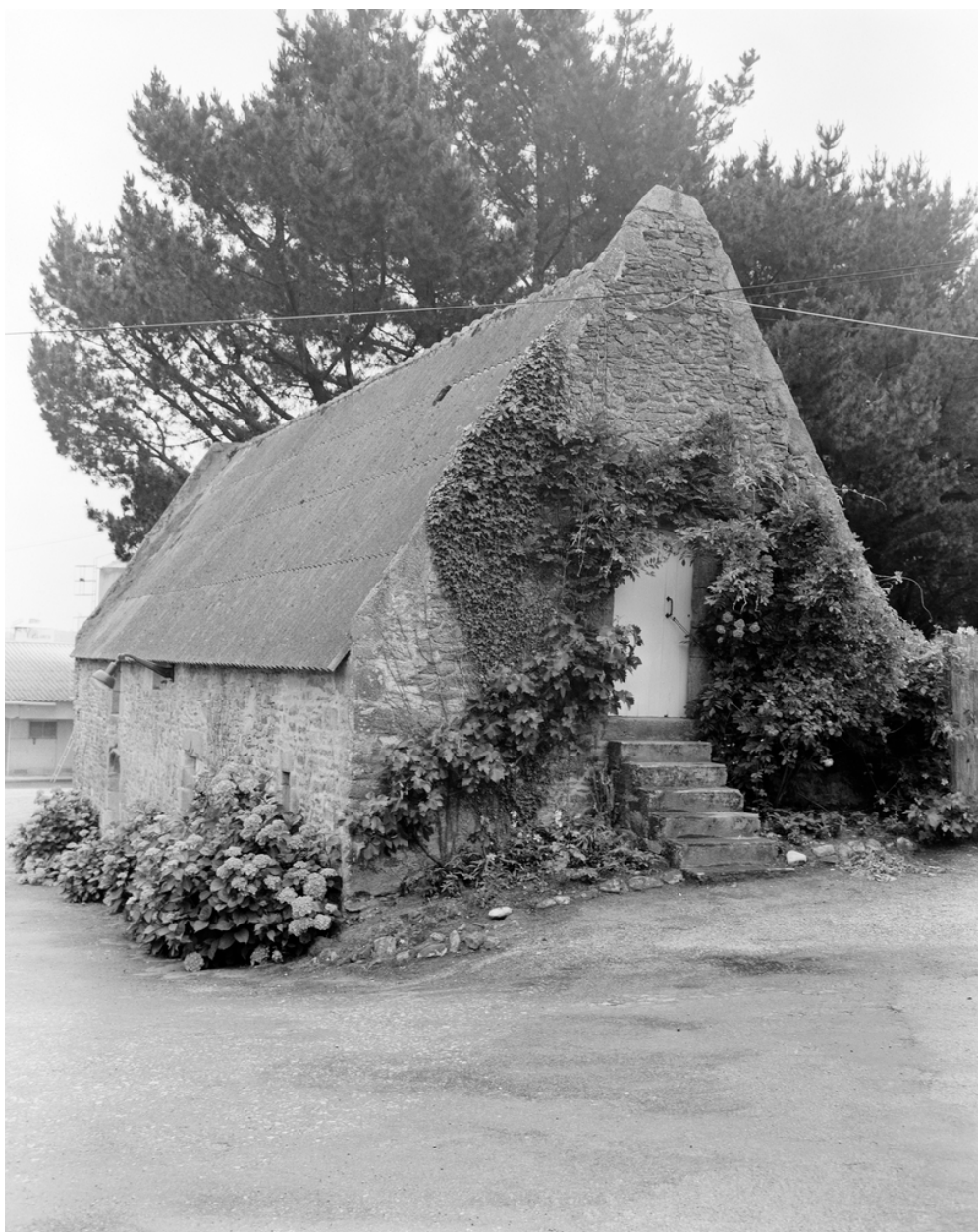
Keryvonnet. Cellier, vue générale ouest.
