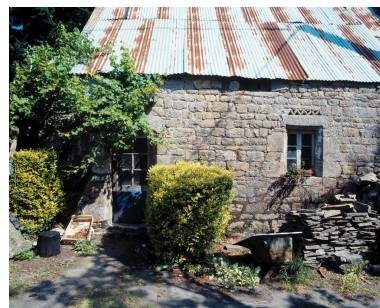
Le Moustoiric.maison repérée, élévation sud. Phot. Bernard Bègne IVR53_19975600779XA
