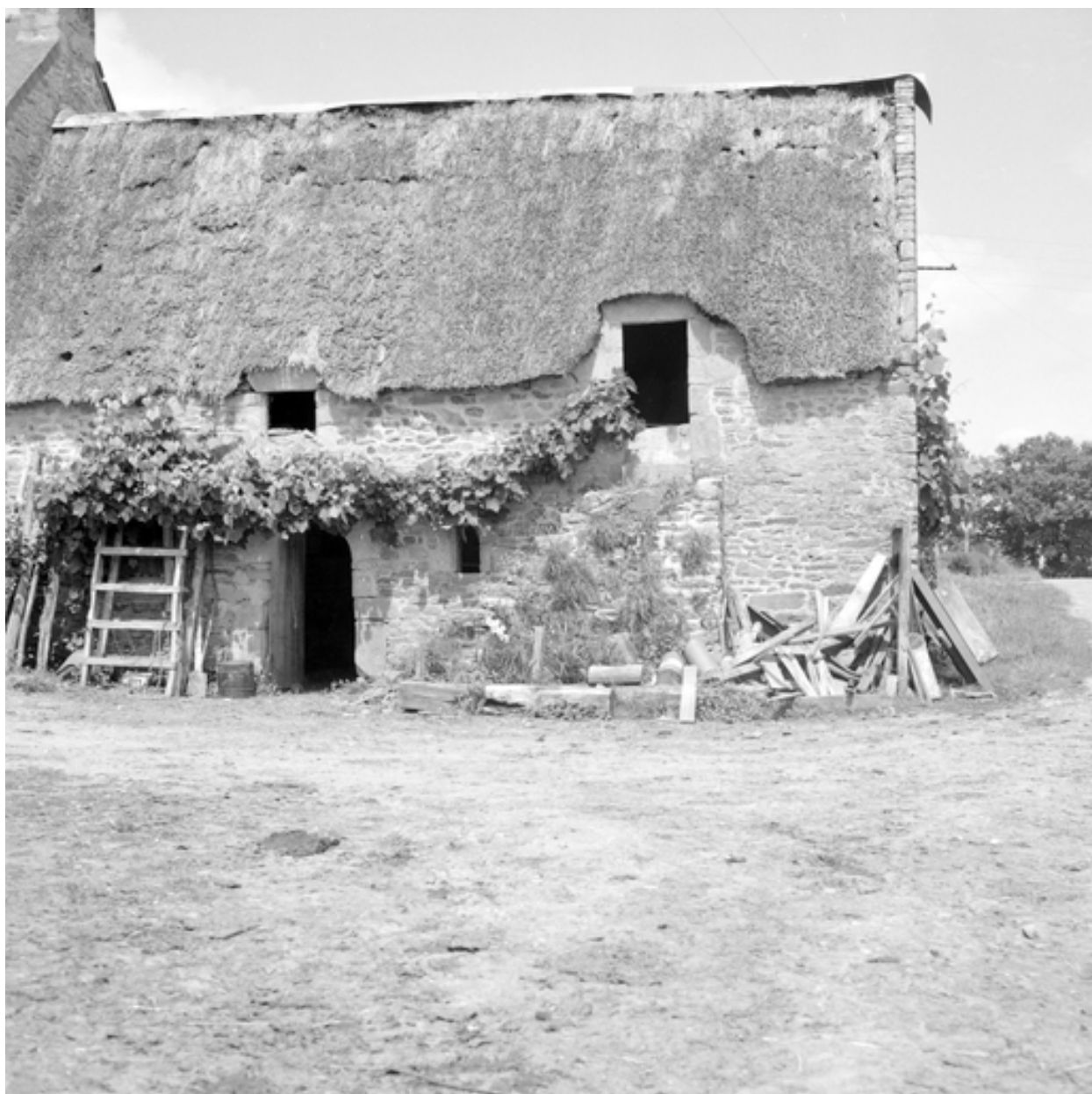
Kermaménic - Chaumière avec escalier en façade.
