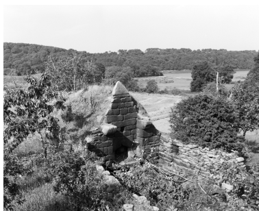
Le Scouhel. Four à pain et vue du Scorff à marée haute. Phot. Bernard Bègne IVR53_19975600797X
