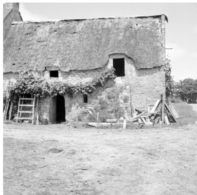
Kermaménic - Chaumière avec escalier en façade. Phot. Marie Berthou IVR53_19745600946X
