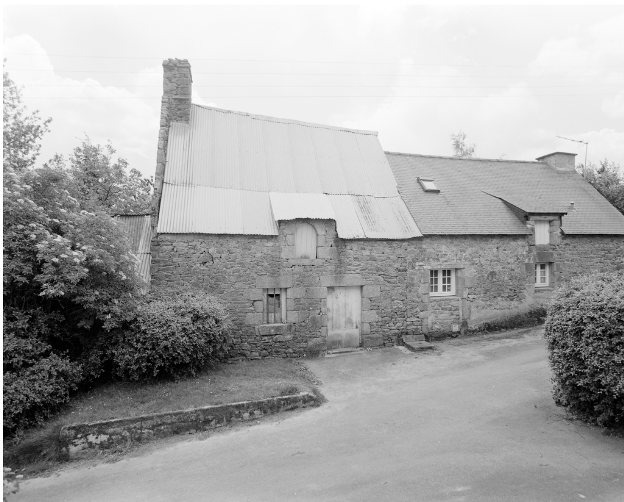
Gorlhès, maison, élévation sud.
