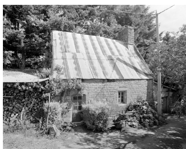
Le Moustoiric. Maison repérée, élévation sud. Phot. Bernard Bègne IVR53_19975600666X
