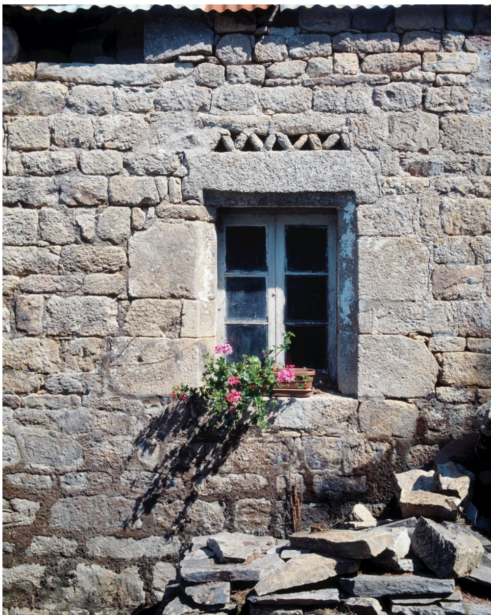
Le Moustoiric. Maison repérée, (R1), détail arc de décharge en chevrons.
