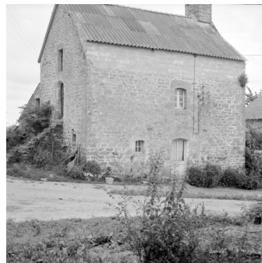
CAUDAN, maison datée de 1830, escalier sur pignon. Phot. Bernard Bègne IVR53_19745600940X
