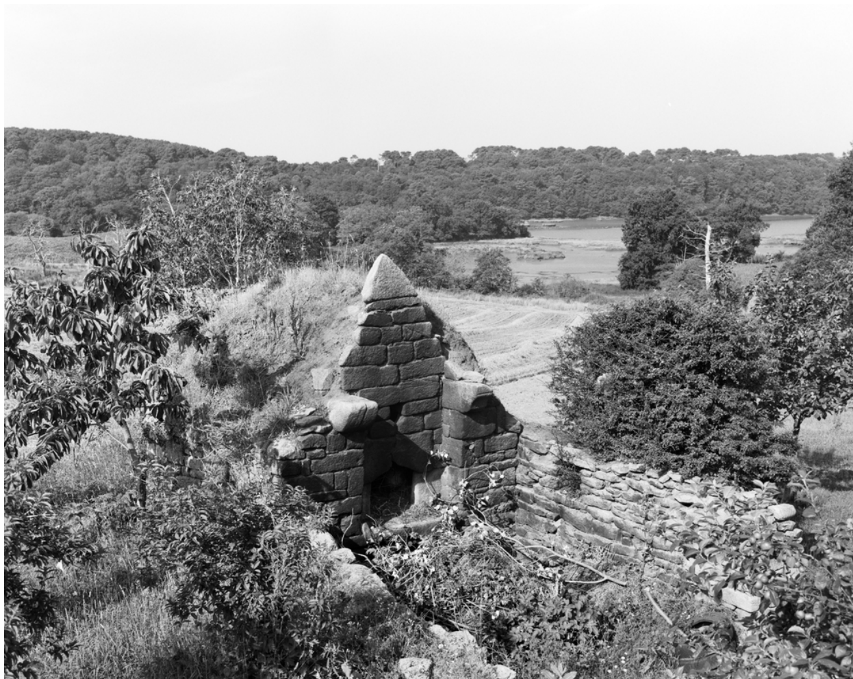
Le Scouhel. Four à pain et vue du Scorff à marée haute.
