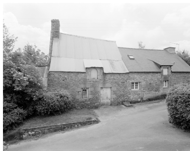
Gorlhès, maison, élévation sud. Phot. Bernard Bègne IVR53_19975600621X
