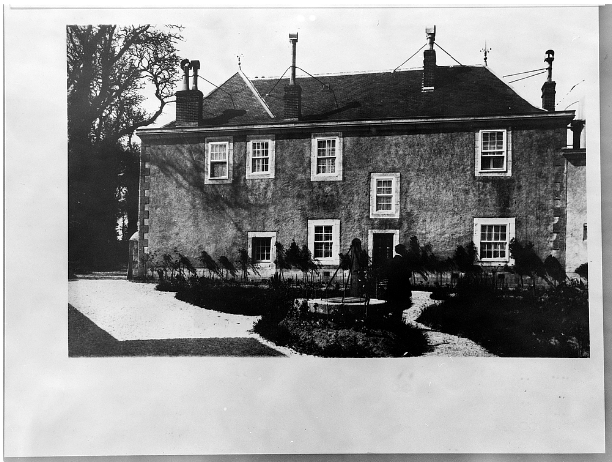
Reproduction - Bâtiment ouest, élévation sud
