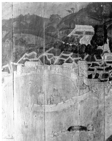
Le couvent vers 1730, détail de peinture sur bois (collection privée). Phot. Guy Artur, Phot. Norbert Lambart IVR53_19862901574X
