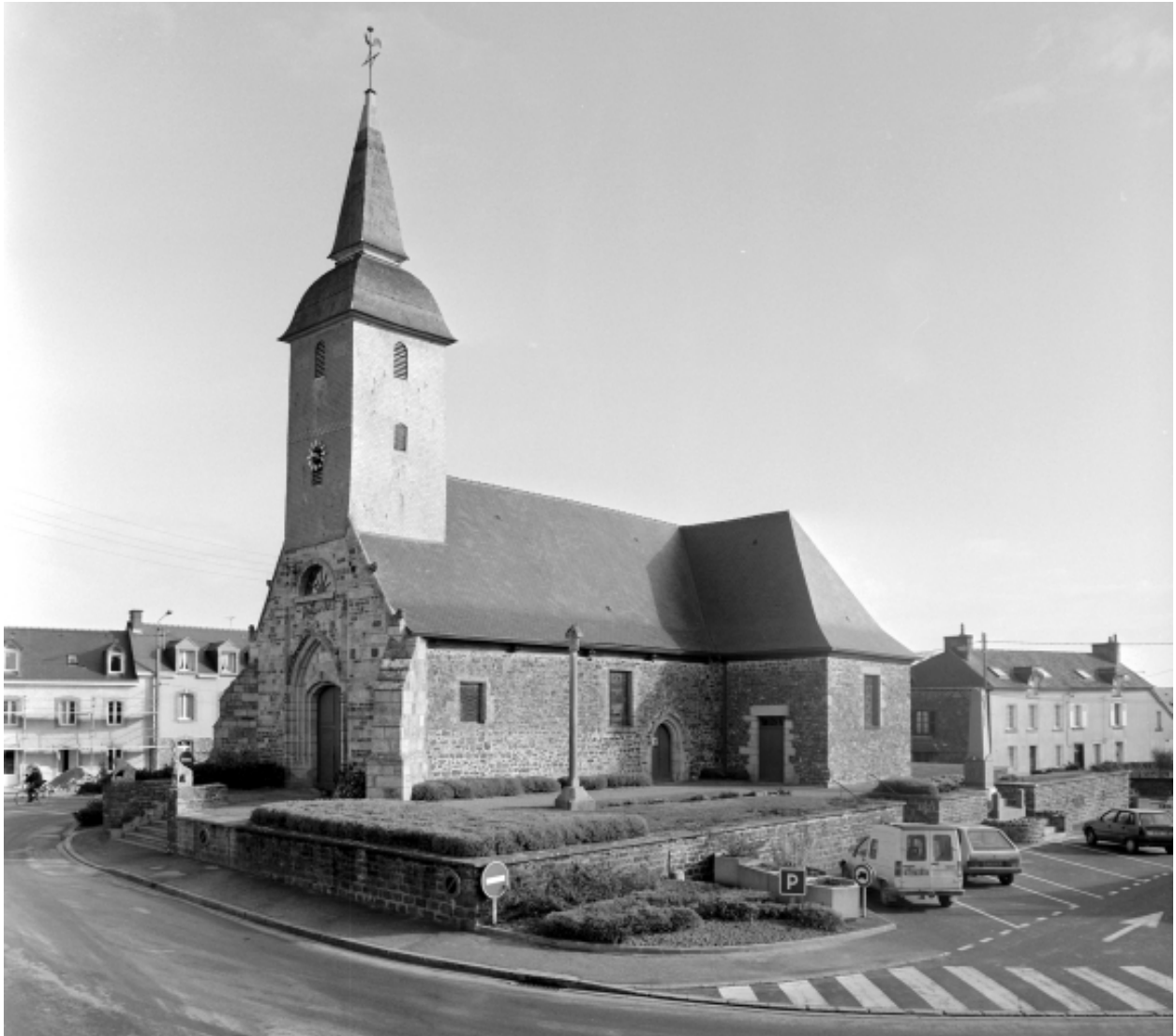
Vue générale du sud
