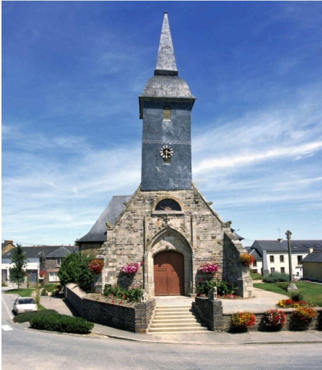
Vue depuis l'ouest
