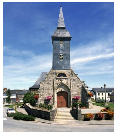
Vue depuis l'ouest Phot. Guy Artur, Phot. Norbert Lambart IVR53_20033517742NUCA
