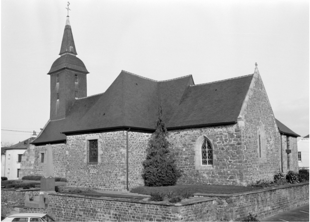
Vue générale du sud-est
