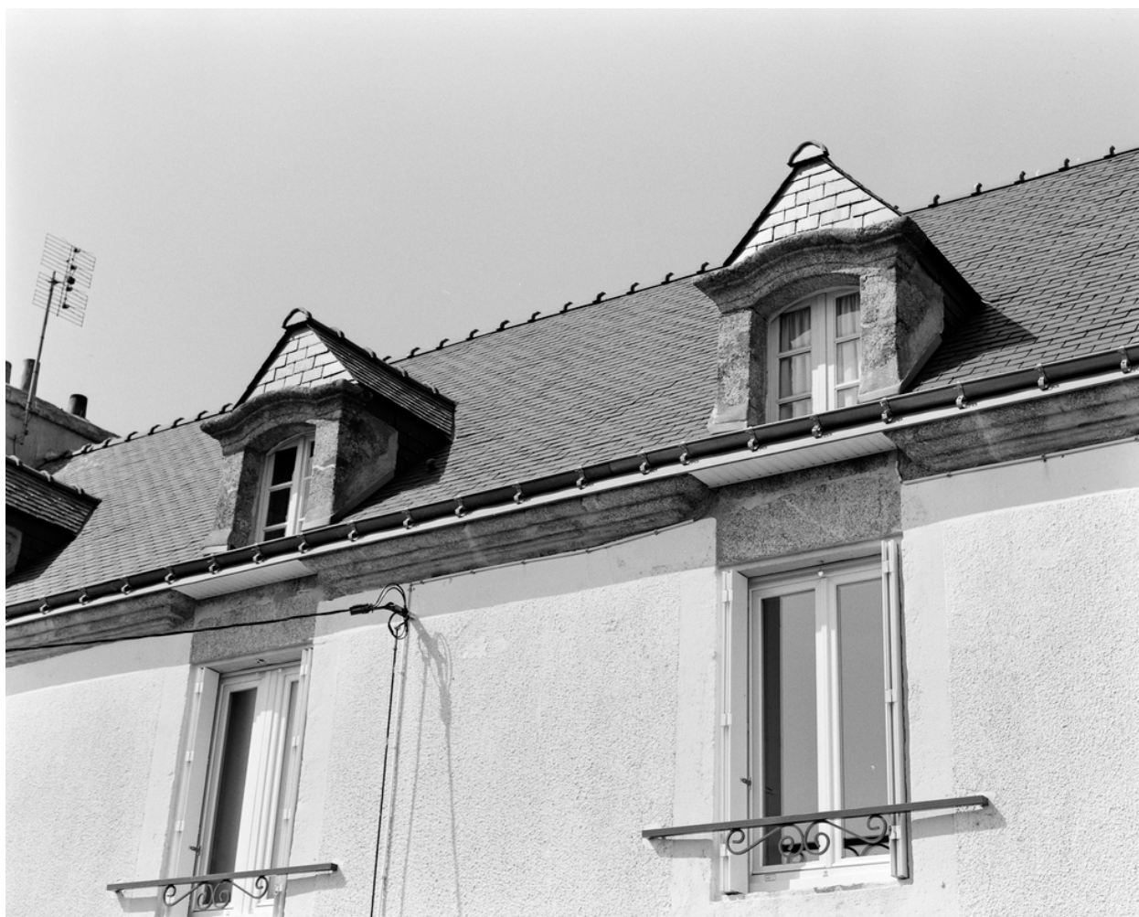
Elévation antérieure : détail des lucarnes.
