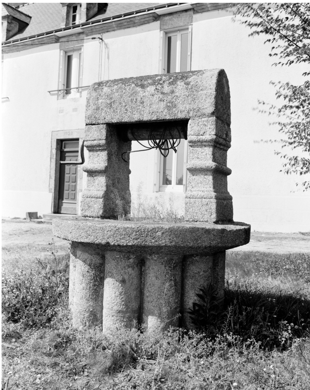
Puits, vue générale.
