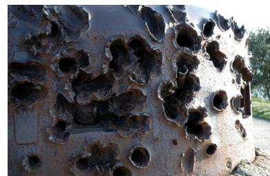
Cloche blindée pour mitrailleuse implantée sur un bunker : effets des combats d'août 1944
