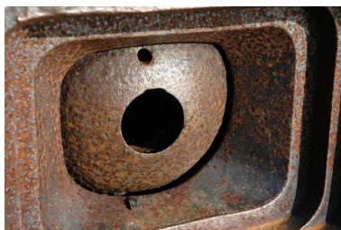
Cloche blindée implantée sur un bunker : détail de la rotule (l'oeil de la machine de guerre) Phot. Guillaume Lécueillier IVR53_20052904269NUCA
