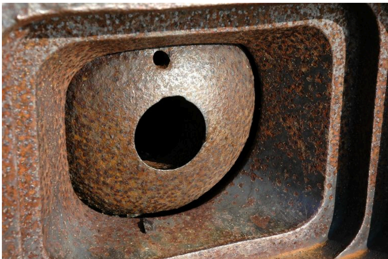
Cloche blindée implantée sur un bunker : détail de la rotule (l'oeil de la machine de guerre)
