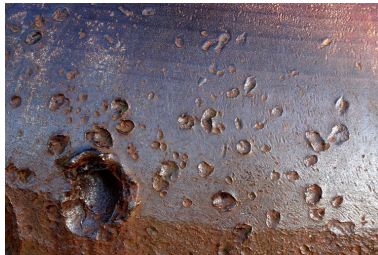
Cloche blindée pour mitrailleuse implantée sur un bunker : effets des combats d'août 1944 Phot. Guillaume Lécueillier IVR53_20052904264NUCA
