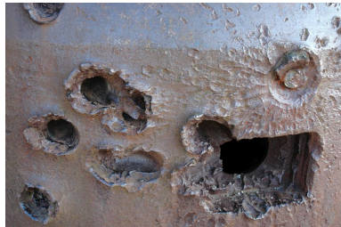
Cloche blindée pour mitrailleuse implantée sur un bunker : effets des combats d'août 1944 Phot. Guillaume Lécueillier IVR53_20052904263NUCA
