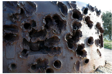
Cloche blindée pour mitrailleuse implantée sur un bunker : effets des combats d'août 1944 Phot. Guillaume Lécueillier IVR53_20052904262NUCA
