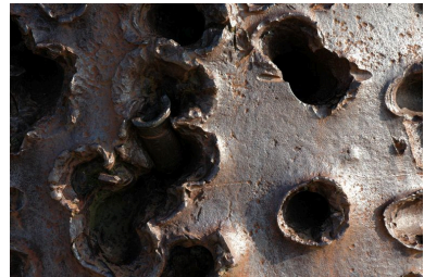
Cloche blindée pour mitrailleuse implantée sur un bunker : effets des combats d'août 1944 Phot. Guillaume Lécueillier IVR53_20053522695NUCA
