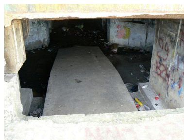
Intérieur de la casemate Phot. Julien Amghar IVR53_20082908631NUCA
