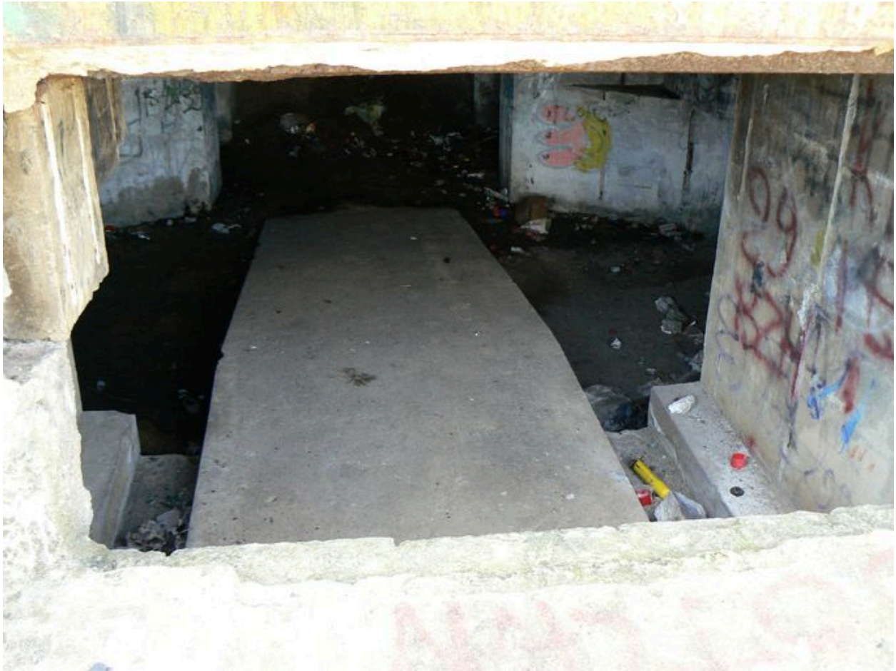
Intérieur de la casemate
