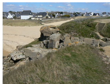
Vestiges du poste de tir donnant sur la plage de Bellangenêt Phot. Julien Amghar IVR53_20082908634NUCA
