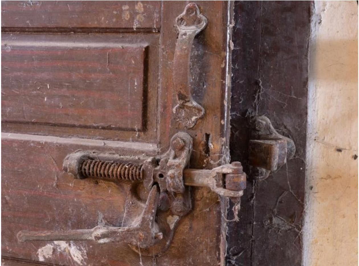
Système de fermeture des chambres froides (détail)
