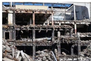
Déconstruction de l'ancien frigorifique, 10 mars 2022 : côté ouest, infrastructures béton et parement en moellon pour les façades
