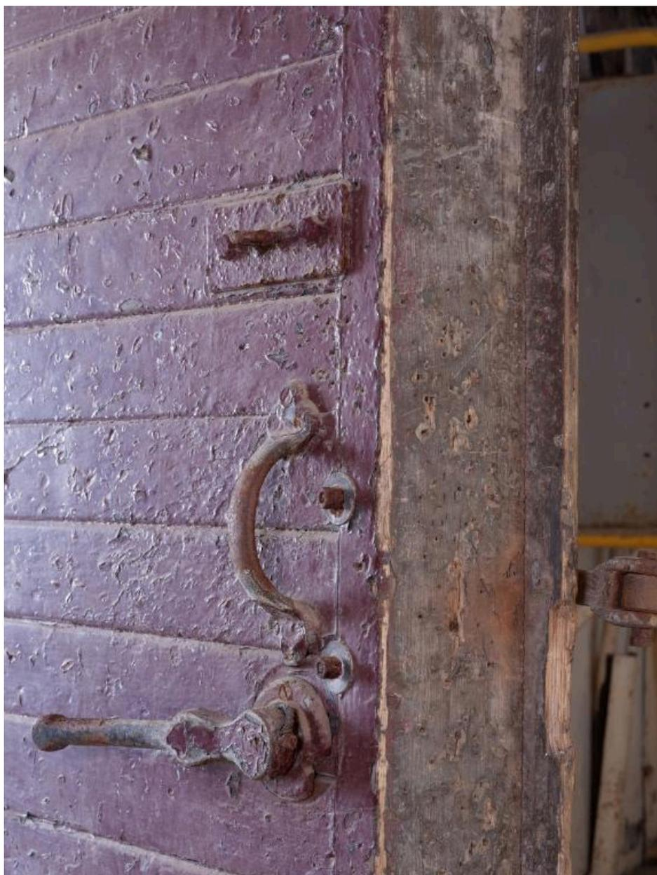
Système de fermeture des chambres froides (détail)
