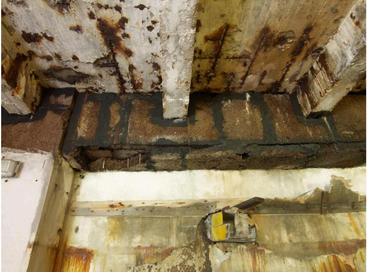
Frigorifique de Lorient : isolant en liège
