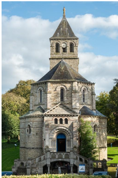
Chapelle Notre-Dame-de-la-Peinière vue générale Phot. Léna Leroy IVR53_20243501356NUCA
