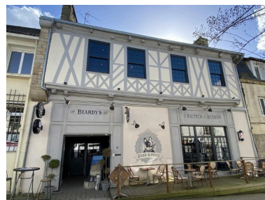
Façade nord Phot. Baptiste Oligo IVR53_20265610750NUCA
