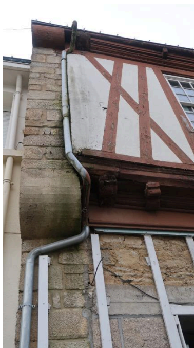
Vue rapprochée du mur en encorbellement et des modifications (état 2019) Phot. Fanny Gosselin IVR53_20195606109NUCA
