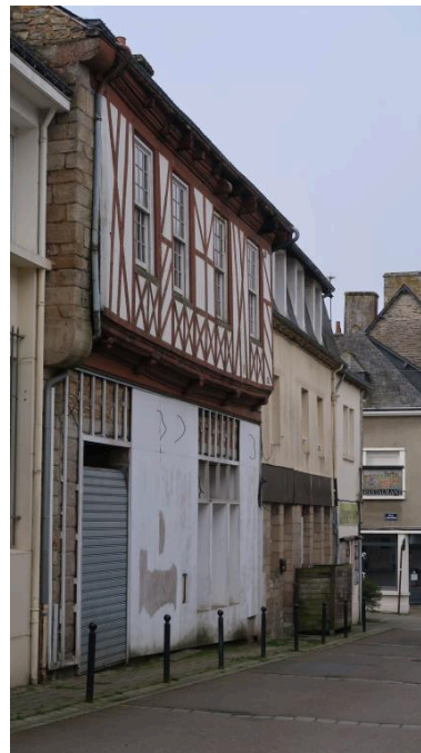
Façade du 12 rue Beaumanoir avec rdc en travaux (2019) Phot. Fanny Gosselin IVR53_20195606107NUCA
