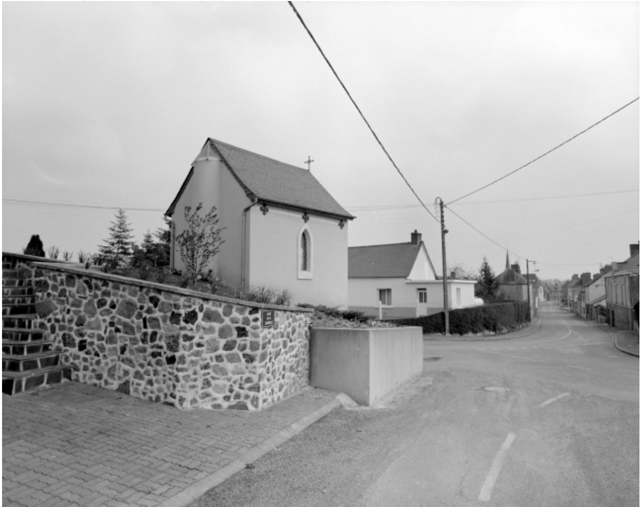
Elévation Sud : vue générale
