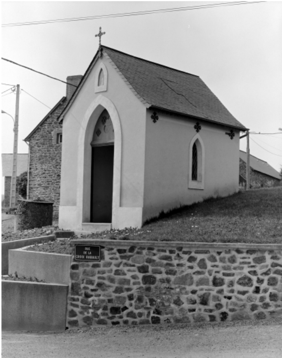
Elévation Nord-Est : vue générale
