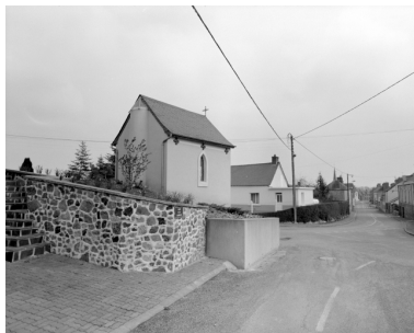
Elévation Sud : vue générale Phot. Bernard Bègne, Phot. M. Loyon IVR53_19933500254X
