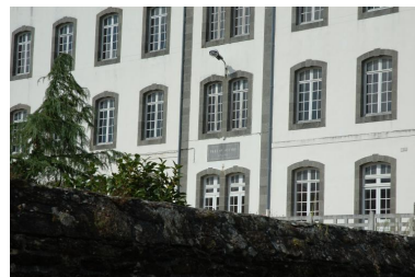
Vue générale : détail de l'élévation principale orientée vers le sud-sud-ouest (état en 2005) Phot. Guillaume Lécueillier IVR53_20082909767NUCA
