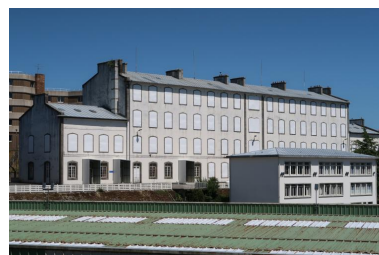
Vue générale : élévation principale orientée vers le sud-sud-ouest (état en 2022) Phot. Guillaume Lécuillier
