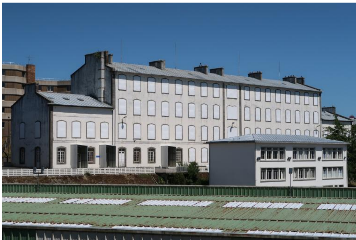
Vue générale : élévation principale orientée vers le sud-sud-ouest (état en 2022)
