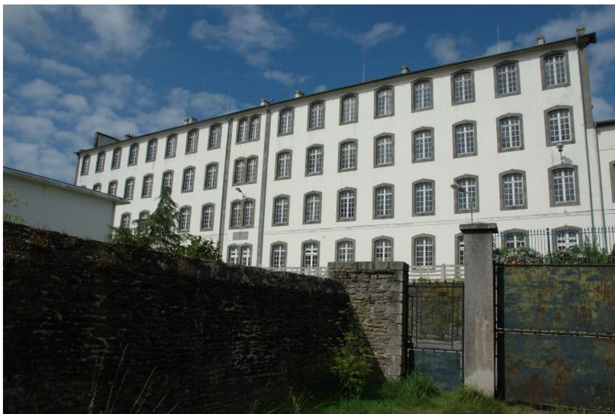
Vue générale : élévation principale orientée vers le sud-sud-ouest (état en 2005)
