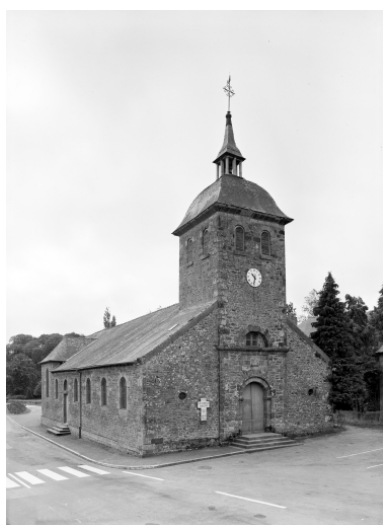
Elévation Nord-Ouest : vue générale Phot. L. Lamandé IVR53_19853501270V
