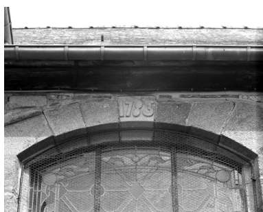
Elévation nord, partie est, fenêtre datée : détail de l'inscription Phot. L. Lamandé IVR53_19853501105X
