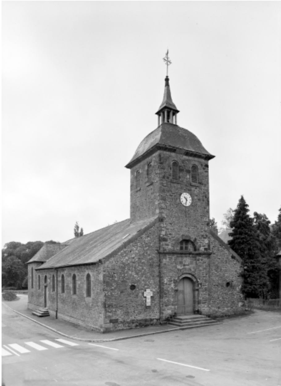
Elévation Nord-Ouest : vue générale
