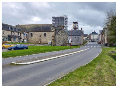
Entrée nord du bourg depuis la D82 Phot. Bernard Bègne IVR53_20263500532NUCA
