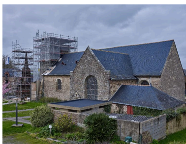
L'église de Chanteloup avec son clocher déposé, 2026 Phot. Bernard Bègne IVR53_20263500530NUCA
